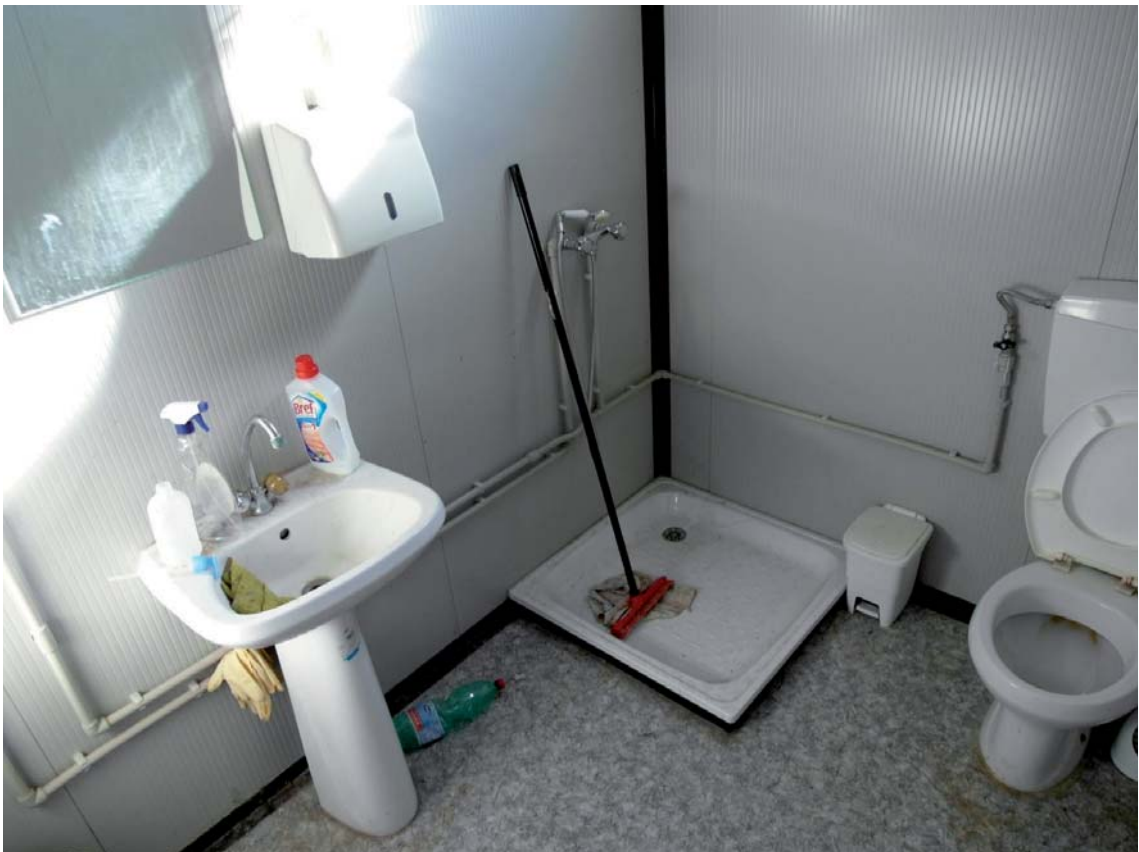
Foto n. 14: Bagno (box prefabbricato esterno).
