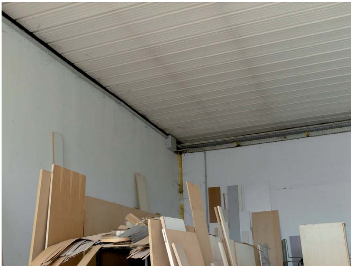
Foto n. 6: Particolare del soffitto.
