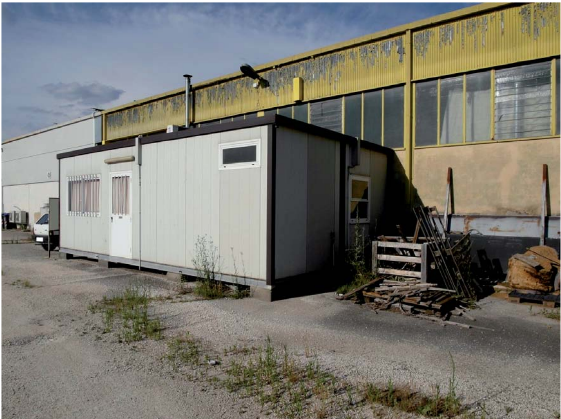
Foto n. 4: Box prefabbricato esterno uso ufficio e servizi.
