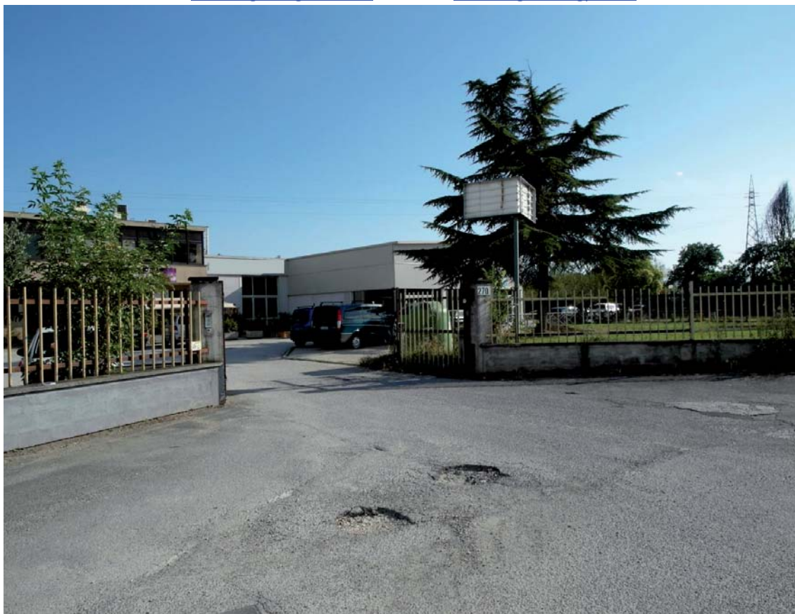
Foto n. 1: Accesso al fabbricato dal lato via Narni.
