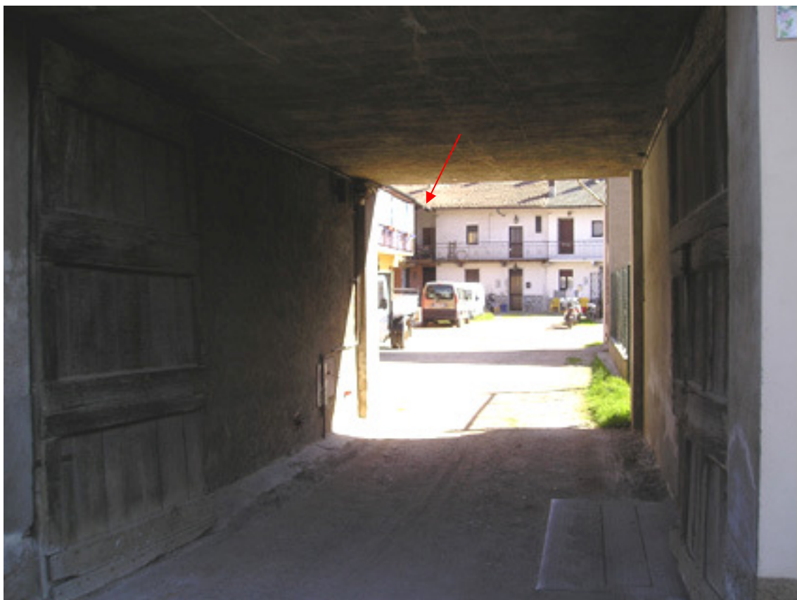
Foto 2 – L'ingresso al cortile, sullo sfondo l'immobile in esame.
