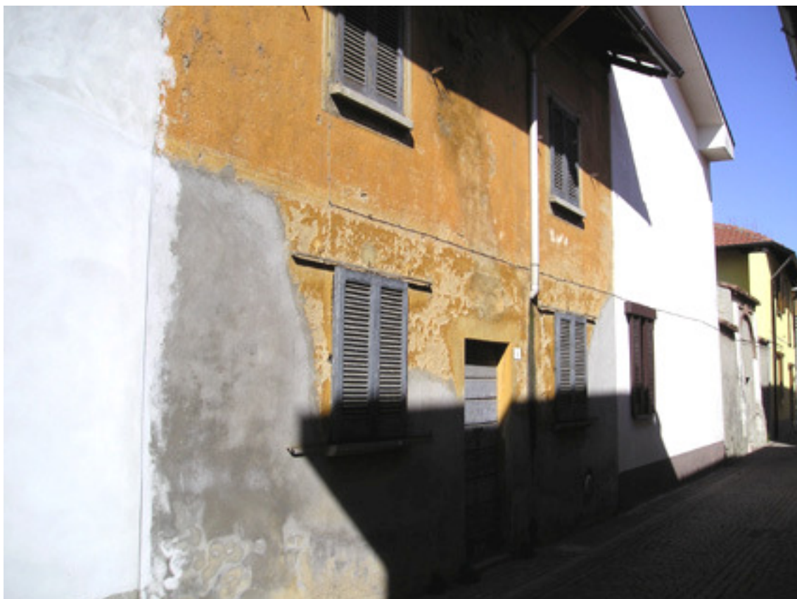
Foto 11 – La facciata est sulla Via Marconi.
