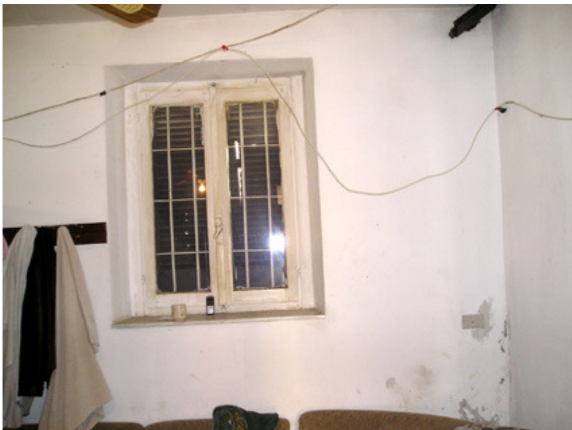
Foto 8 – Vista parziale del locale al piano terra.
