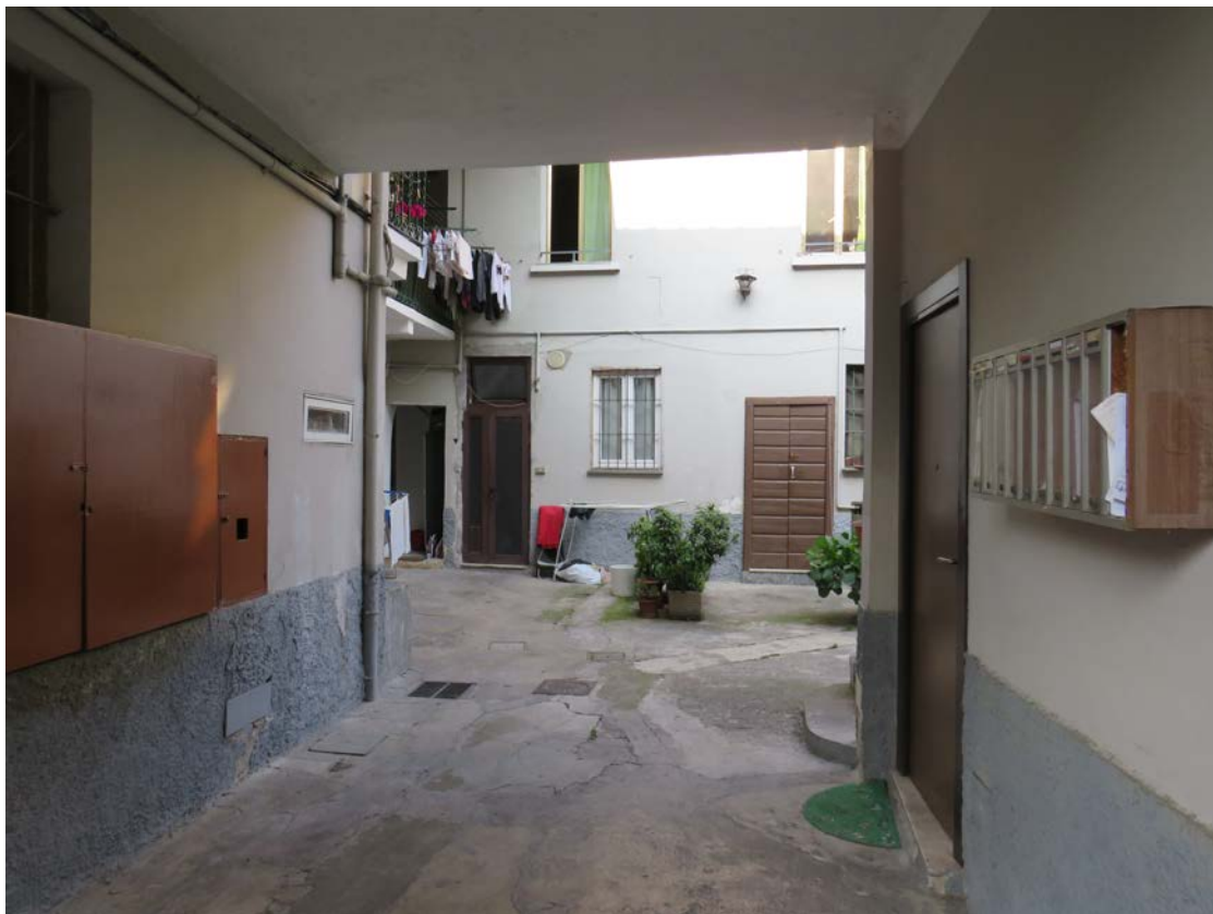
ANDRONE DI INGRESSO
