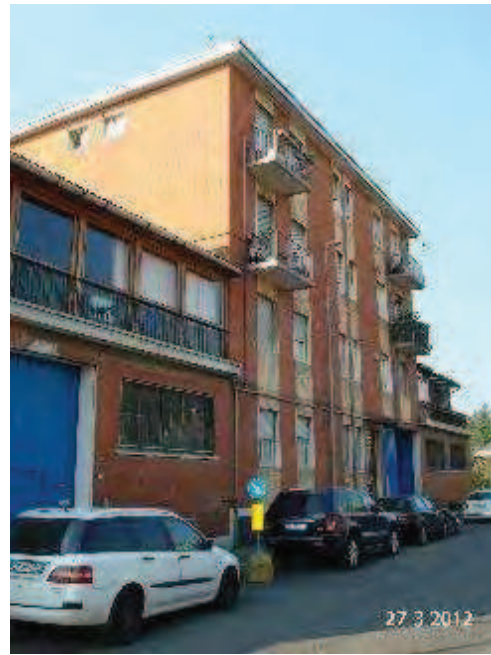
VIA FIUME, 6 - FRONTE
