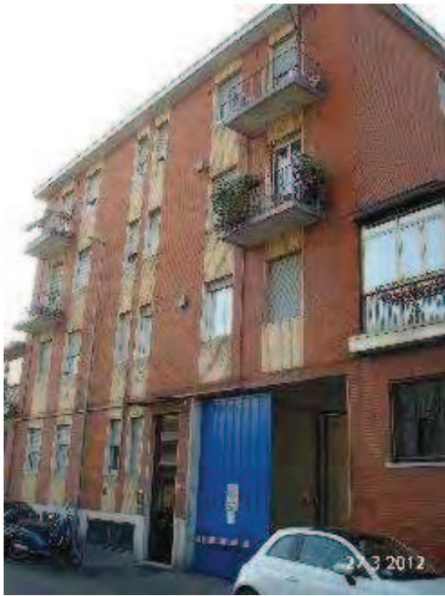
VIA FIUME, 6 - FRONTE
