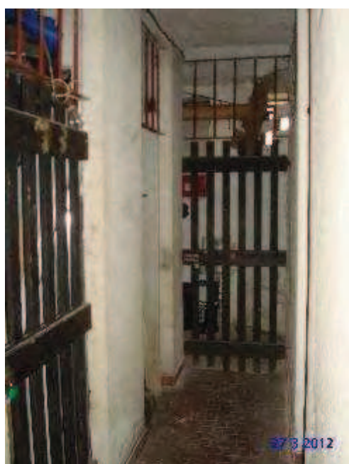
VIA FIUME, 6 - PORTE CANTINE
