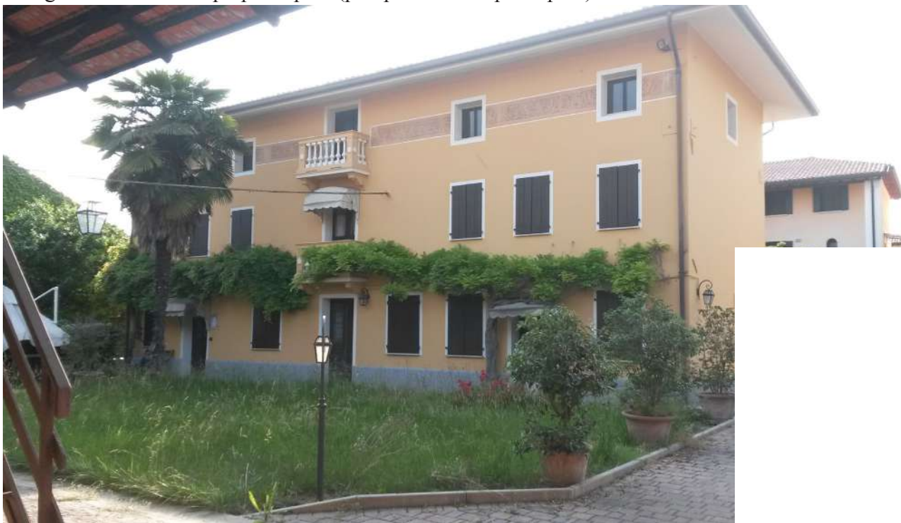
Fotografia 9 - Vista corpo principale (prospetto fronte principale)
