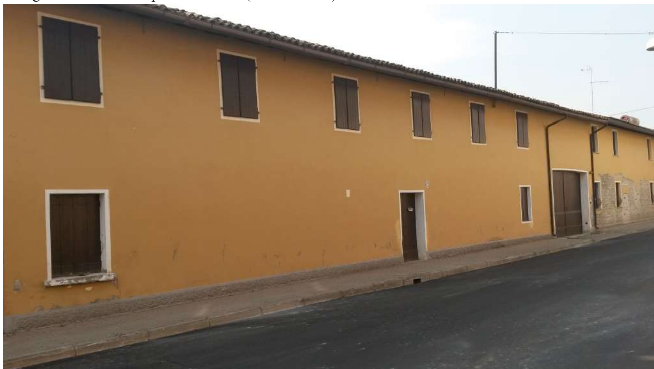
Fotografia 8 - Vista corpo secondario (fronte strada)
