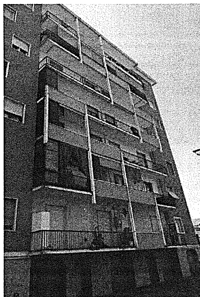
Pioltello- Appartamento con solaio
