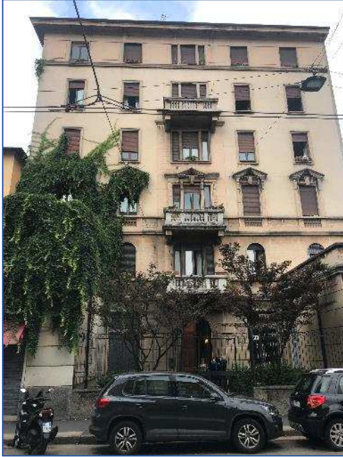
Foto 1 – Corpo di fabbrica su via Menabrea 33
