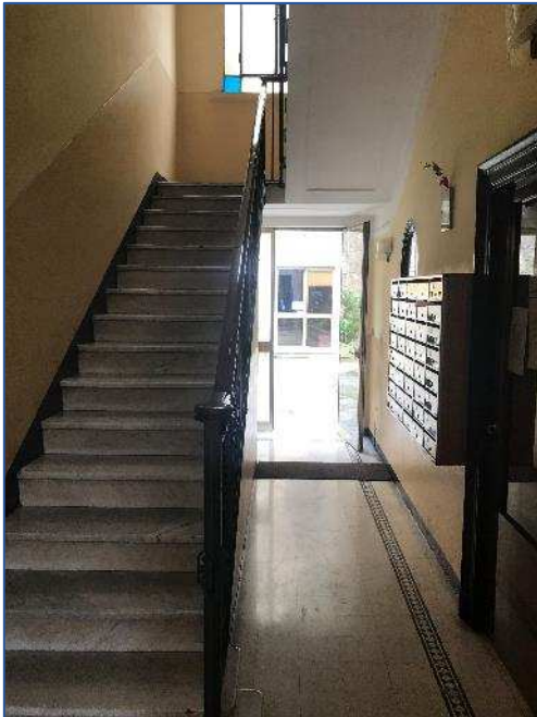
Foto 3 - vano scala comune primo fabbricato
