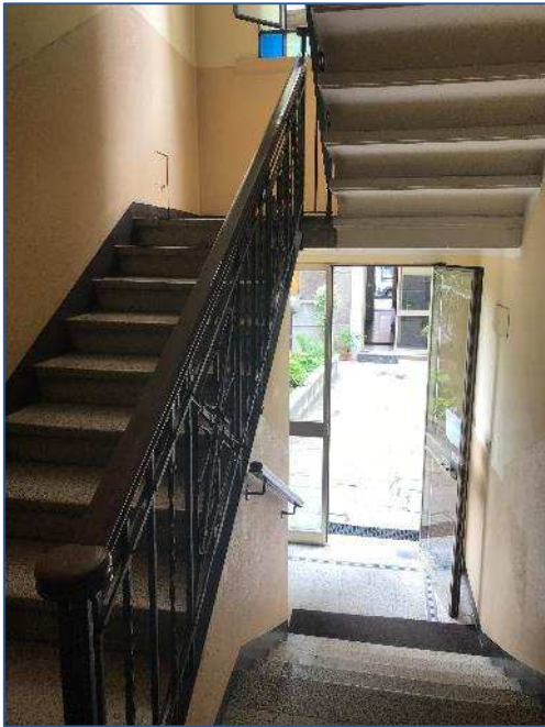
Foto 5 - vano scala corpo interno
