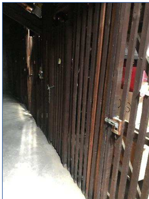
Foto 20 - disimpegno comune sottotetto
