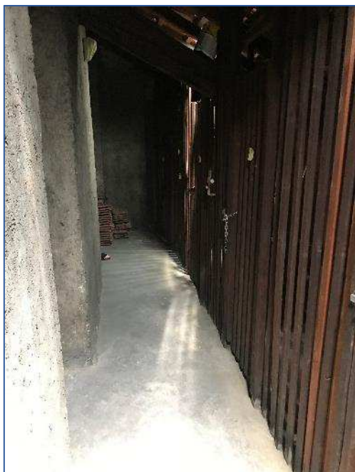
Foto 19 - disimpegno comune sottotetto
