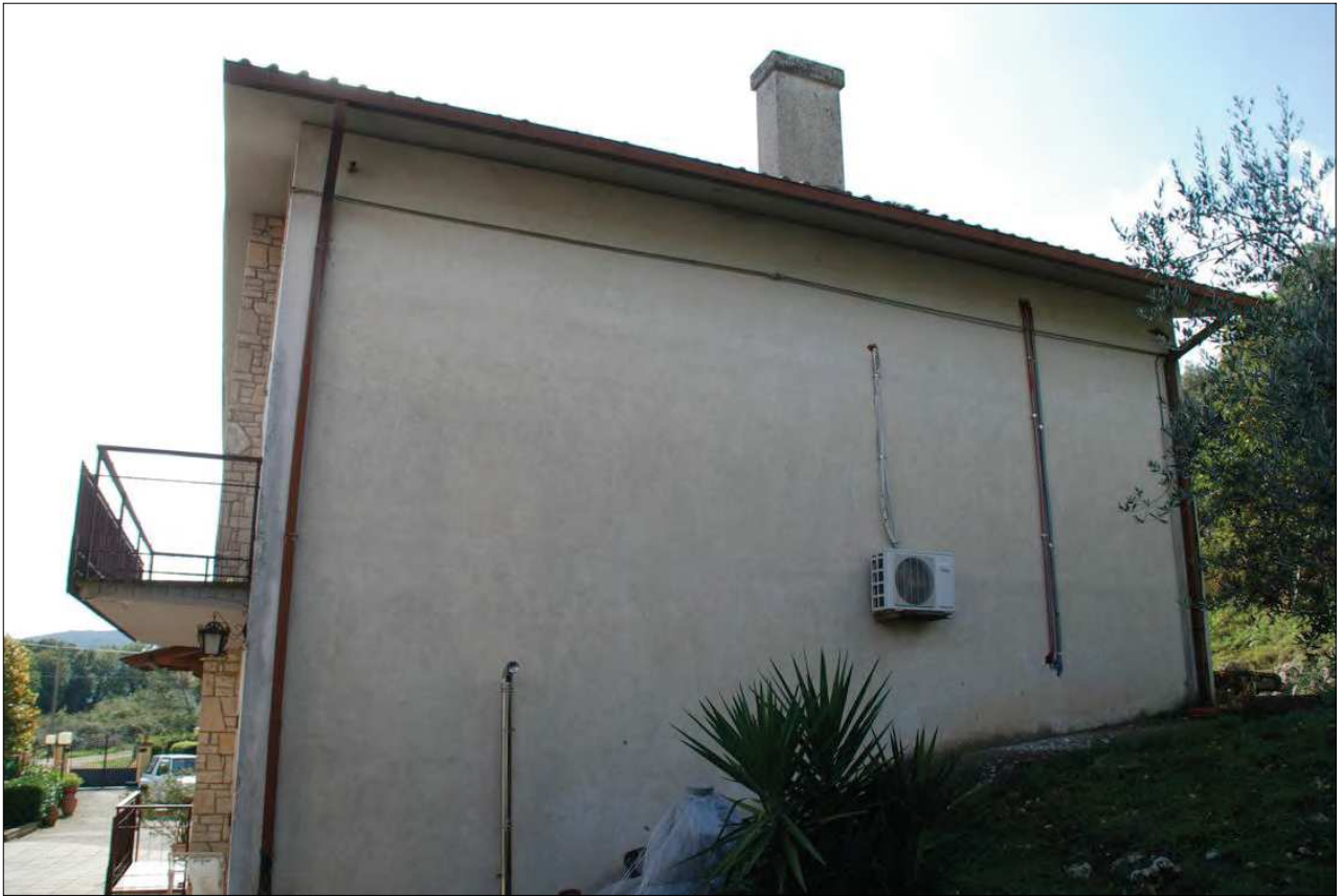
07_Foto del 03-11-2016_Abitazione Fg. 54 part. 61 sub. 2
