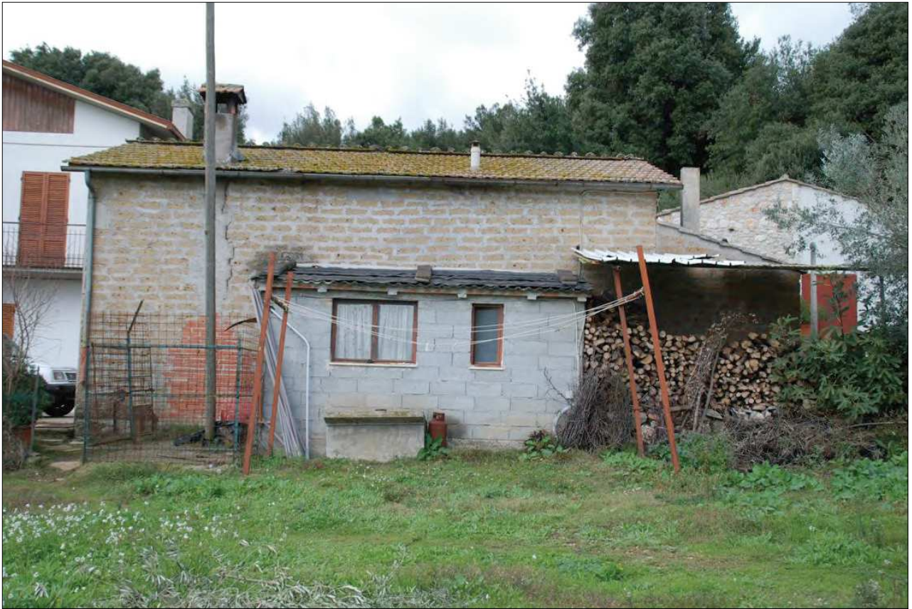
03_Foto del 12-11-2016_garage Fg. 54 part. 61 sub. 3
