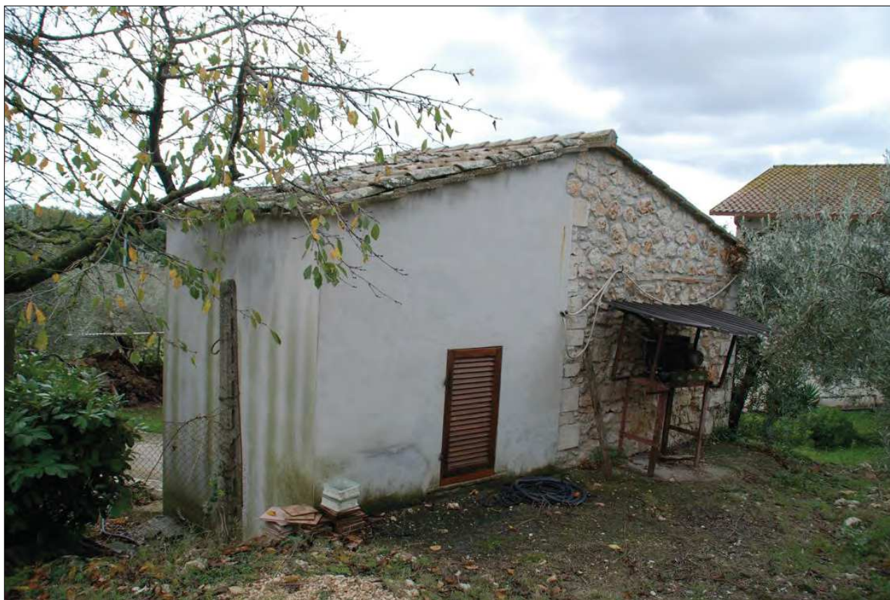
18_Foto del 12-11-2016_Abitazione_pertinenza Fg. 54 part. 61 sub. 2
