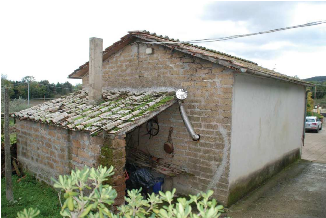
06_Foto del 12-11-2016_garage Fig. 54 part. 61 sub. 3
