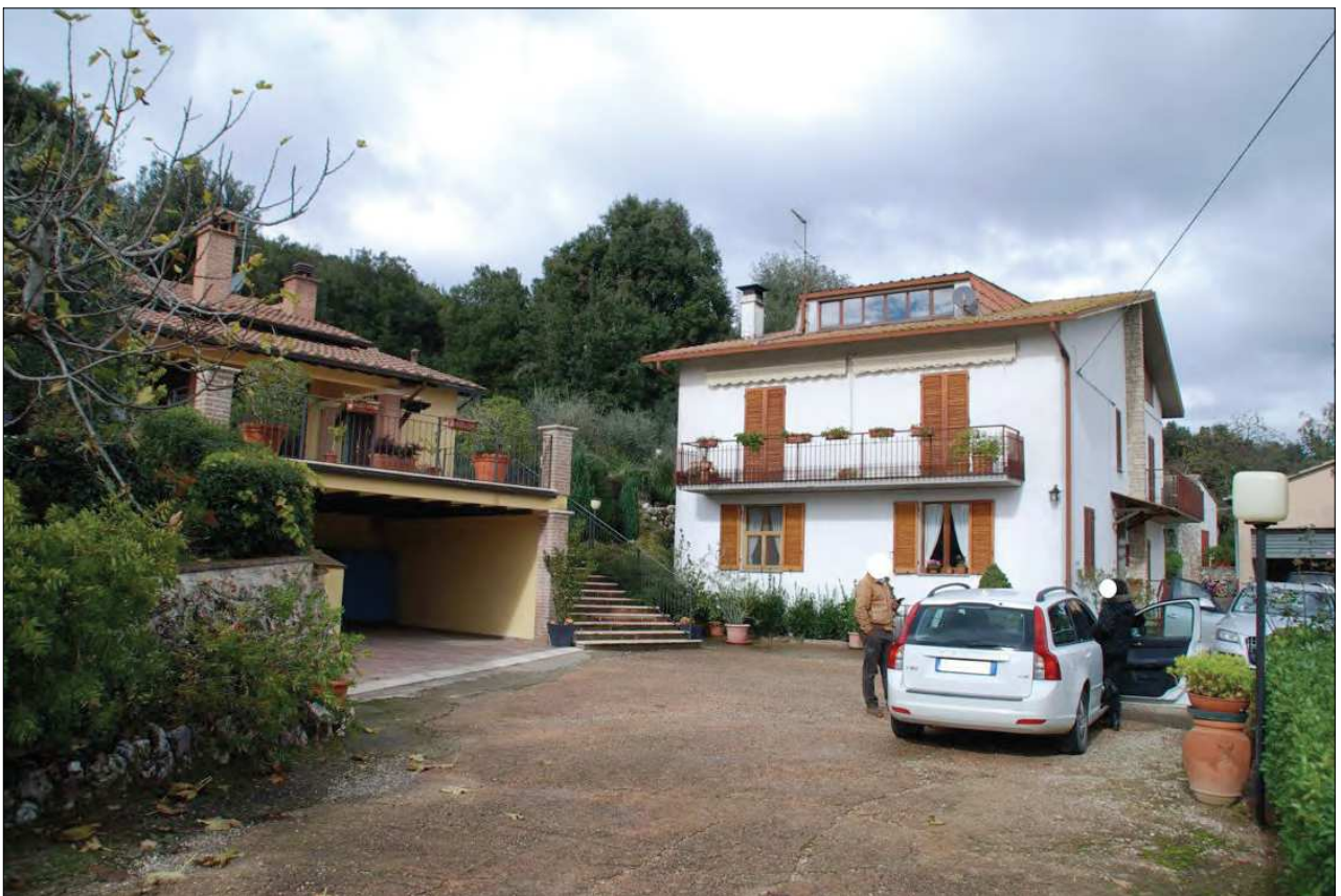
02_Foto del 12-11-2016_Abitazione Fg. 54 part. 61 sub. 2
