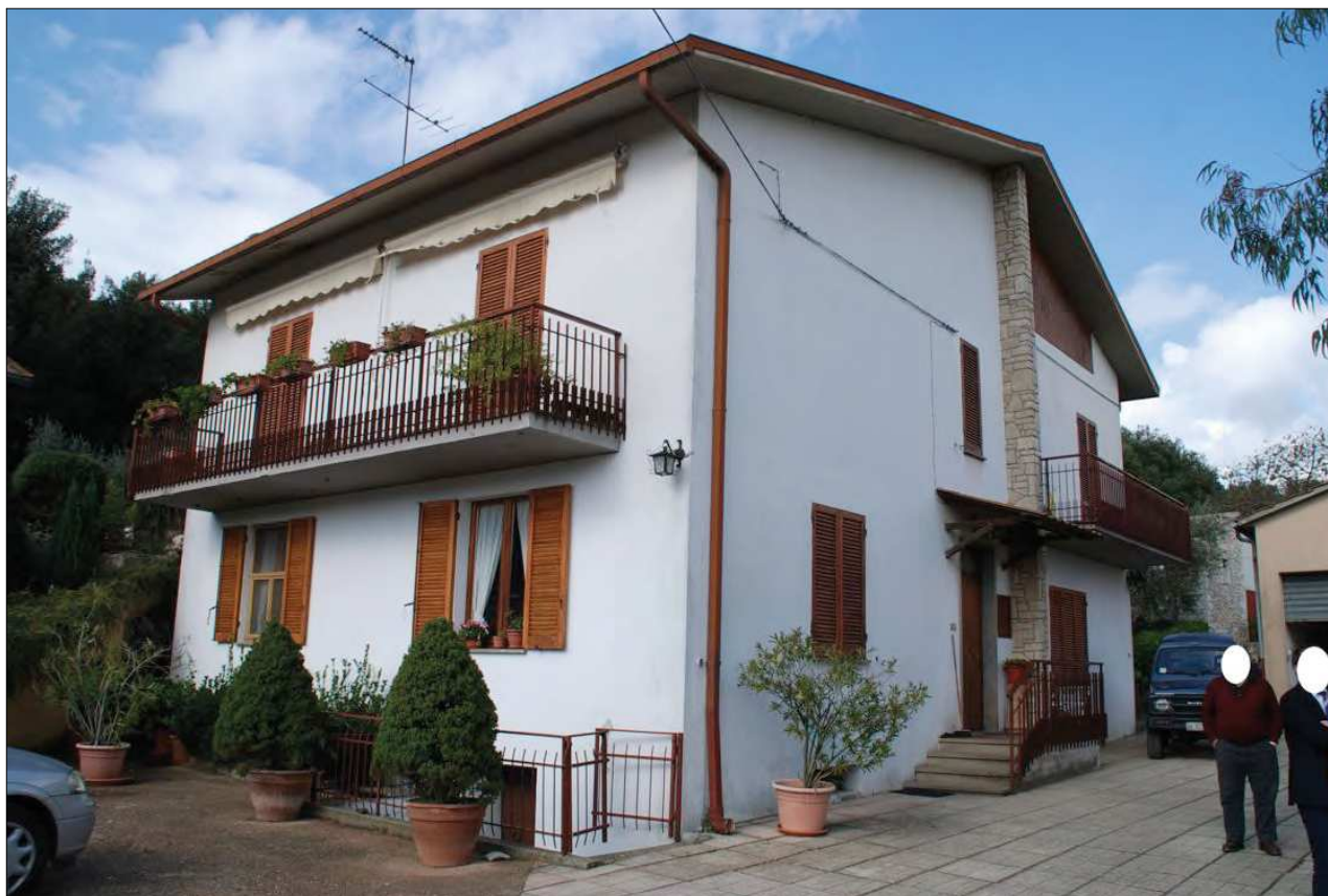
03_Foto del 12-11-2016_Abitazione Fg. 54 part. 61 sub. 2
