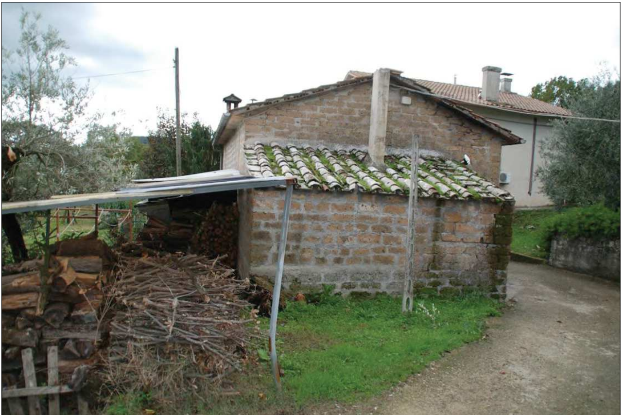
02_Foto del 12-11-2016_garage Fg. 54 part. 61 sub. 3
