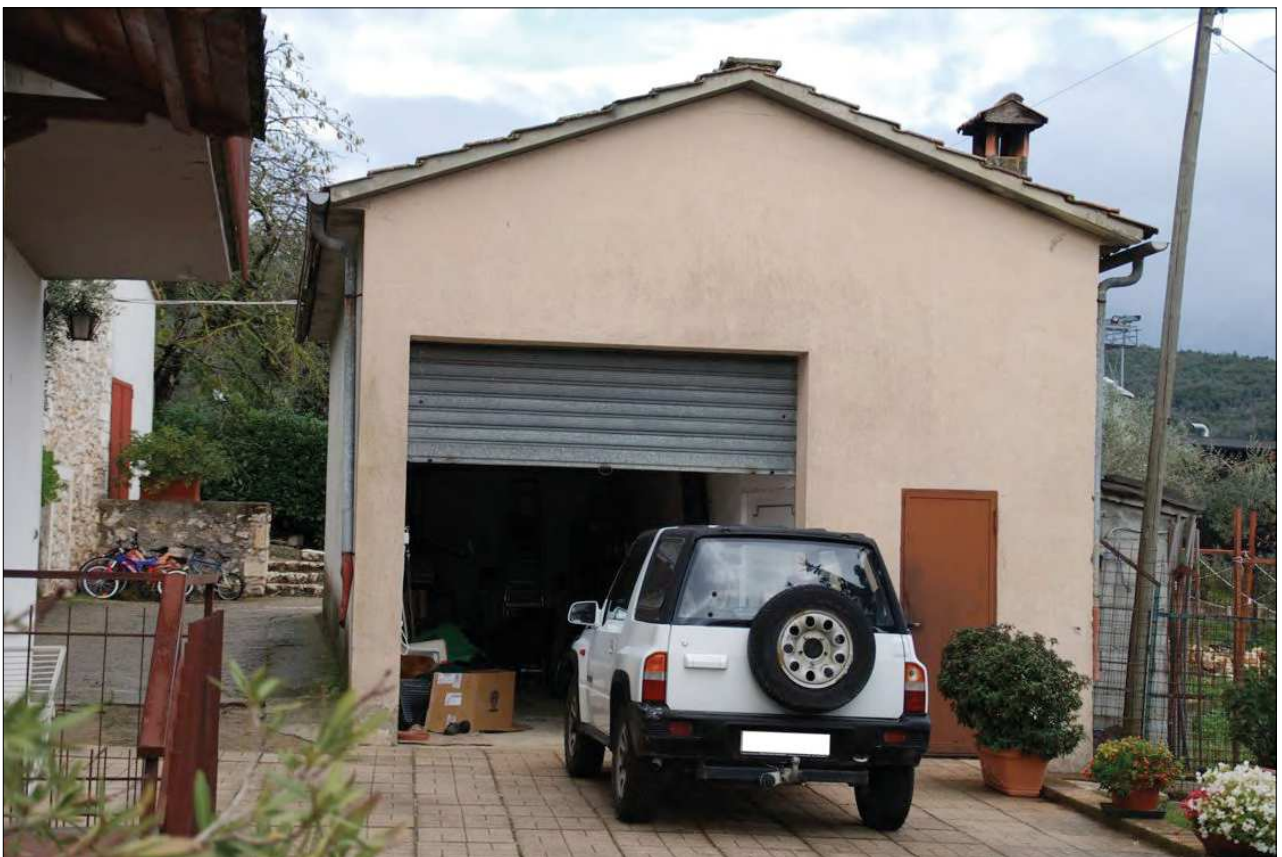
01_Foto del 12-11-2016_garage Fg. 54 part. 61 sub. 3
