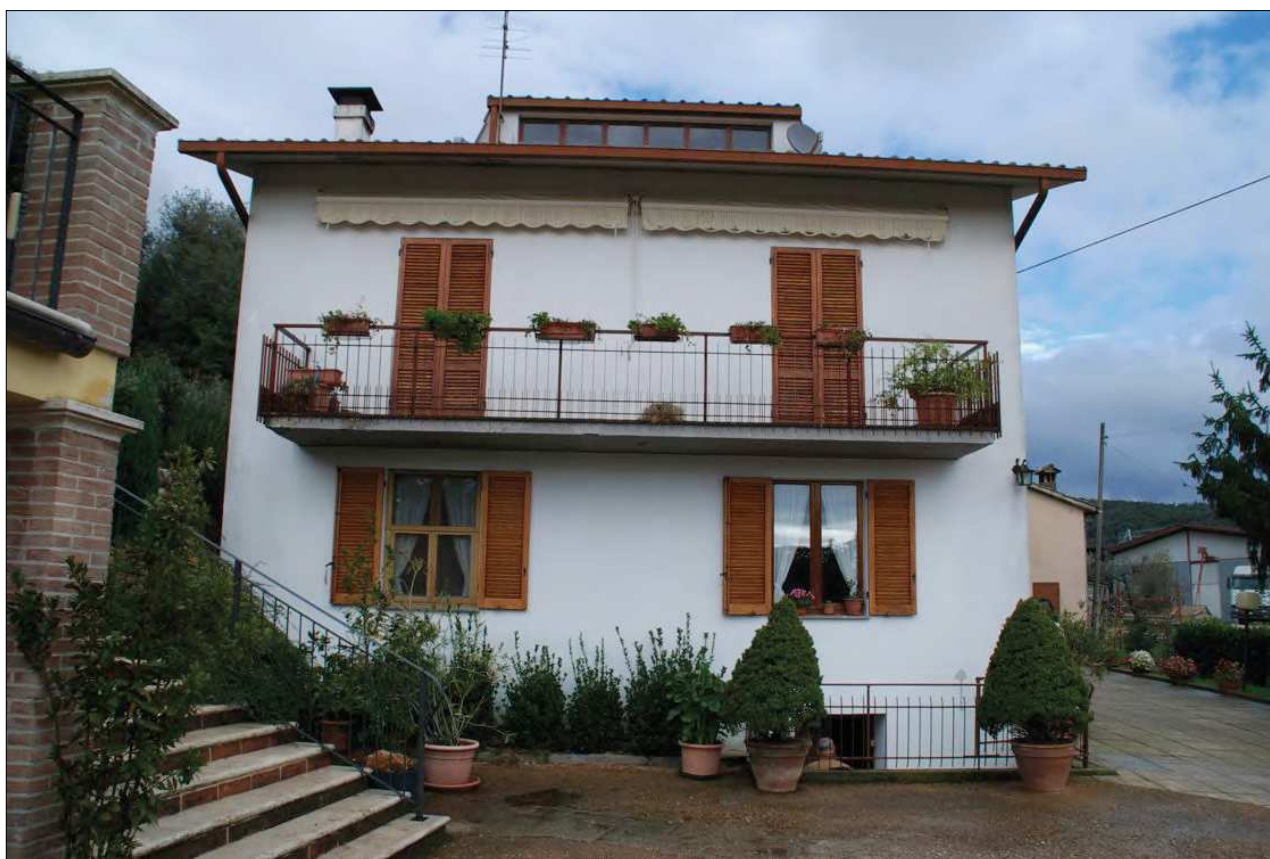
04_Foto del 12-11-2016_Abitazione Fg. 54 part. 61 sub. 2
