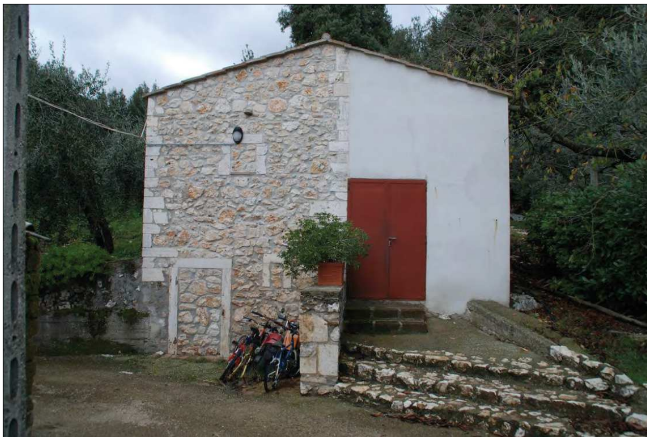
17_Foto del 12-11-2016_Abitazione_pertinenza Fg. 54 part. 61 sub. 2
