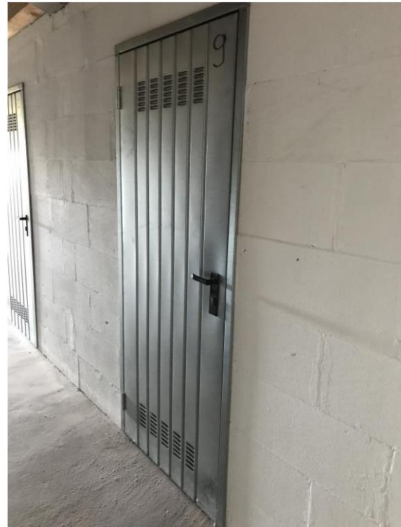
Fig.27: entrata "ripostiglio" sottotetto
