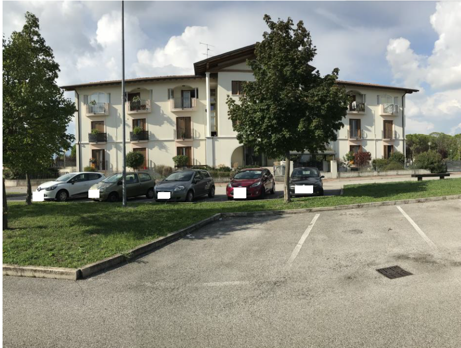
Fig.1: vista da sud
