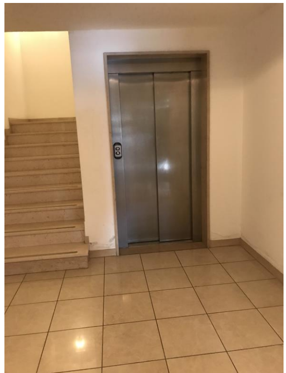
Fig.4: vano scala e ascensore
