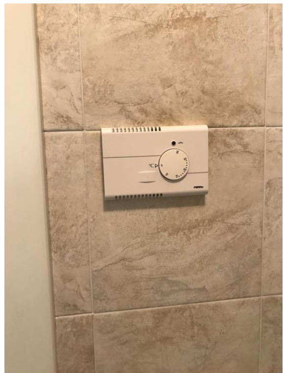
Fig.18: termostato bagno
