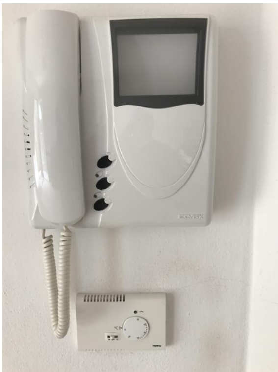
Fig.17: citofono e termostato
