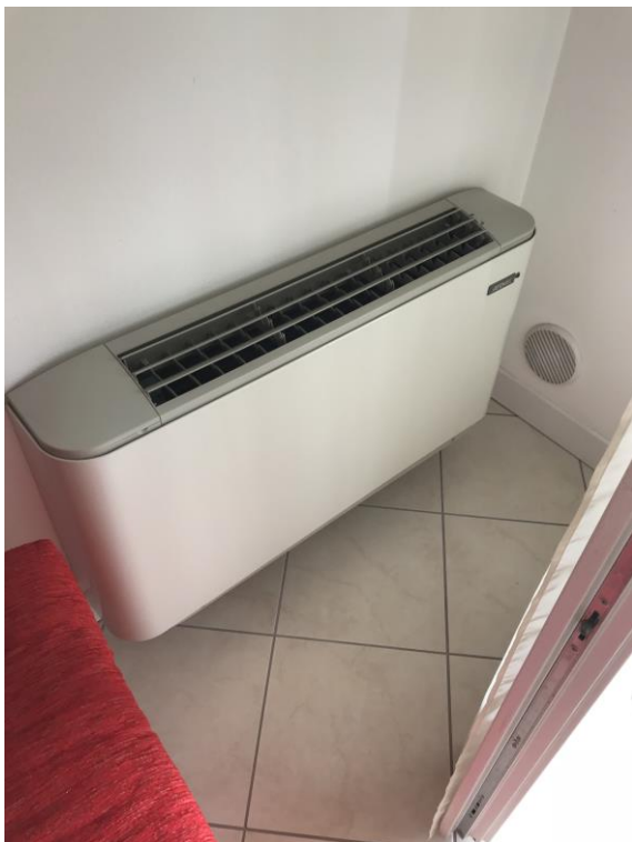
Fig.19: ventilconvettori
