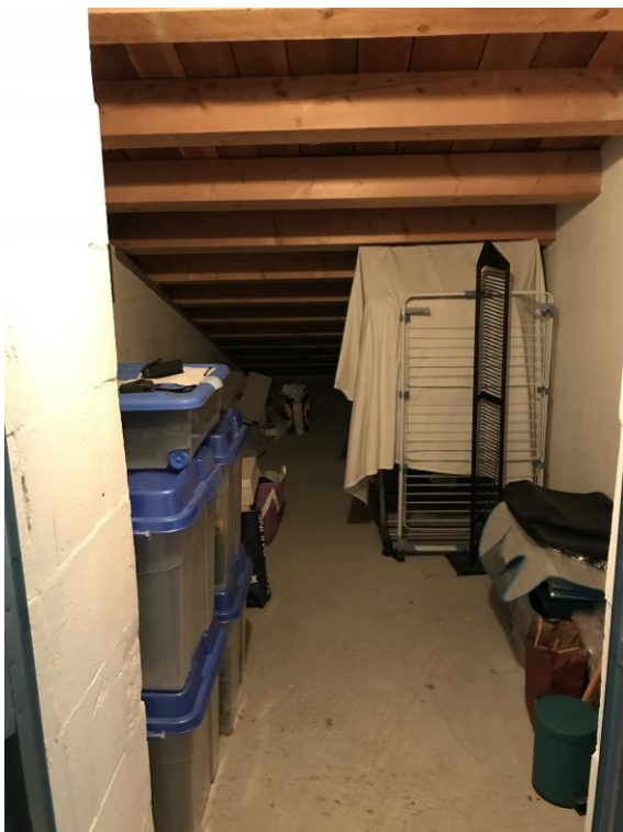
Fig.28: vista interno del ripostiglio sottotetto
