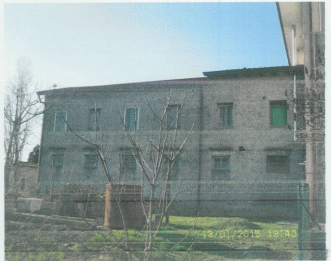
Fabbricato F.18, mapp.74 Sub. 4-6
