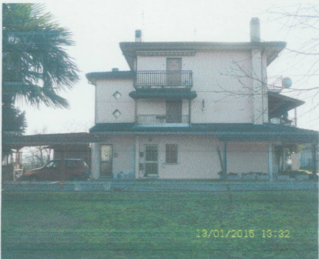
Fabbricato F.18, mapp.74 Sub. 4-6
