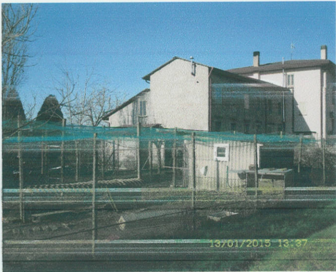
Fabbricato F.18, mapp.74 Sub. 4-6
