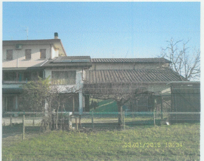
Fabbricato F.18, mapp.74 Sub. 4-6
