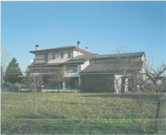
Fabbricato F.18, mapp.74 Sub. 4-6
