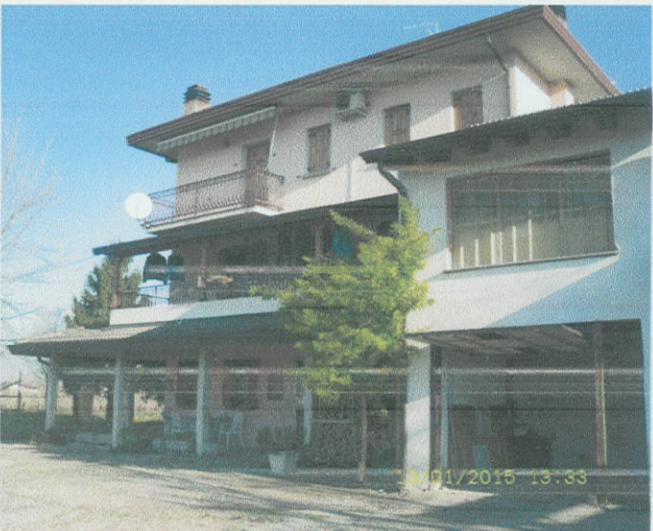
Fabbricato F.18, mapp.74 Sub. 4-6
