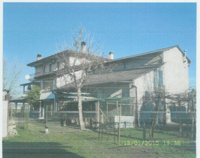
Fabbricato F.18, mapp.74 Sub. 4-6
