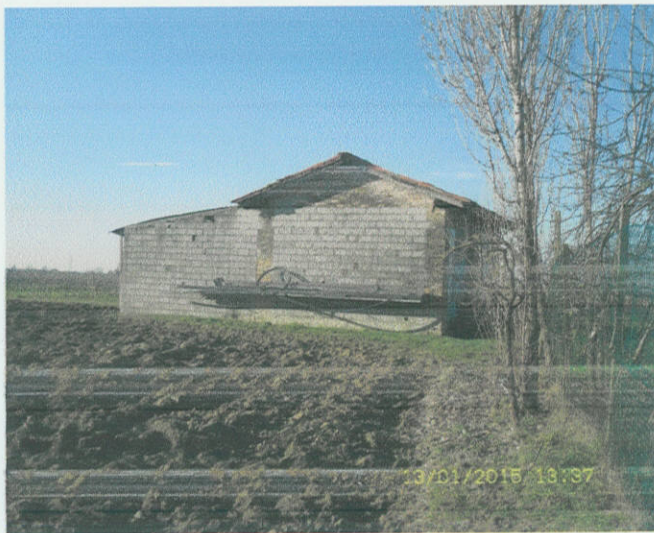
Tettoia F.18, mapp. 3, Sub. 2
