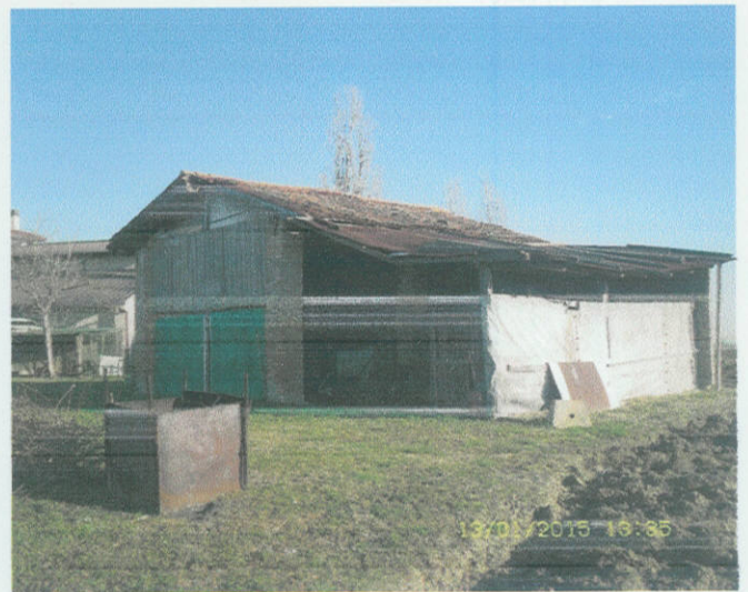
Tettoia F.18, mapp. 3, Sub. 2
