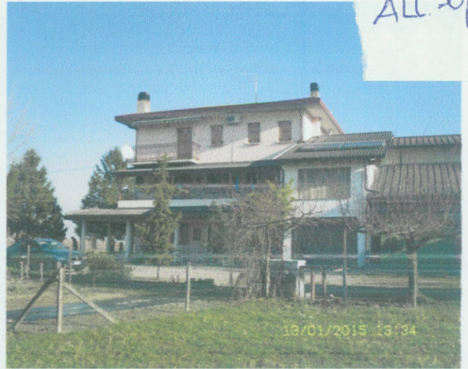
Fabbricato F.18, mapp.74 Sub. 4-6
