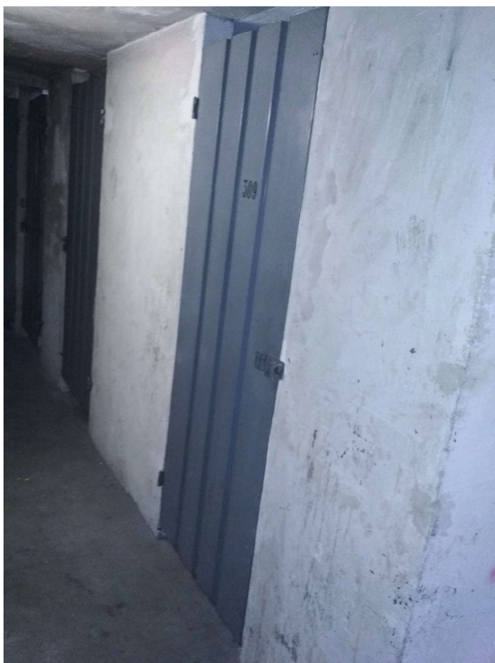
Foto n. 12 – Ingresso al vano solaio (n. 309)
