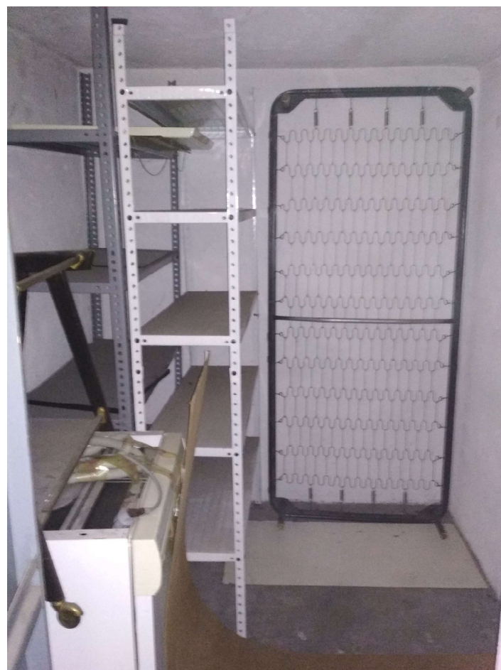
Foto n. 13 – Vano solaio (n. 309)
