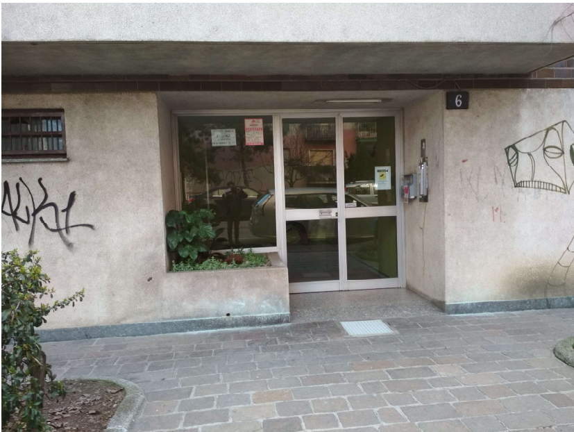
Foto n. 2 – Ingresso al fabbricato
