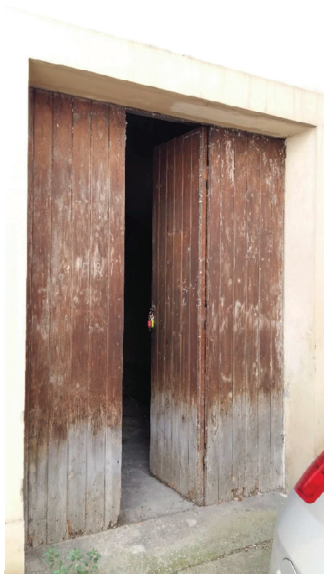
FOTO 4 – INGRESSO VIA SAFFI N. 8
