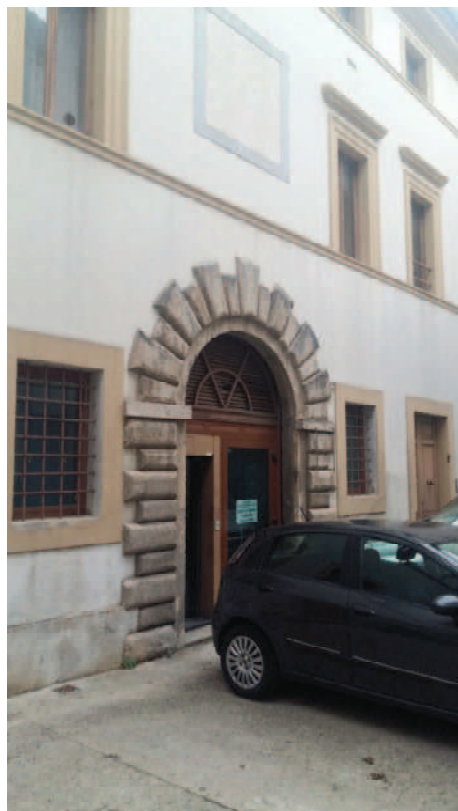
FOTO 4 – INGRESSO VIA SAFFI N. 12
