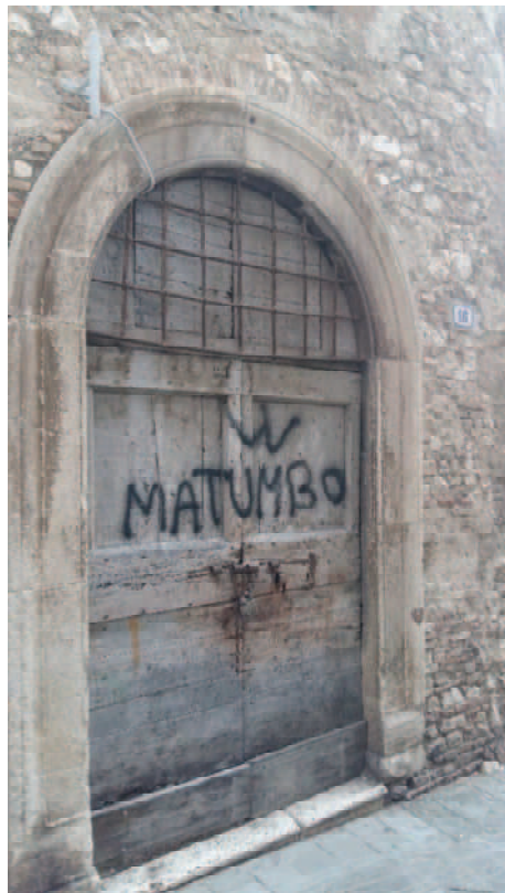
FOTO 4 – INGRESSO VIA SAFFI N. 16
