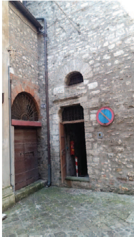
FOTO 5 – INGRESSO LOCALE CENTRALE TERMICA
