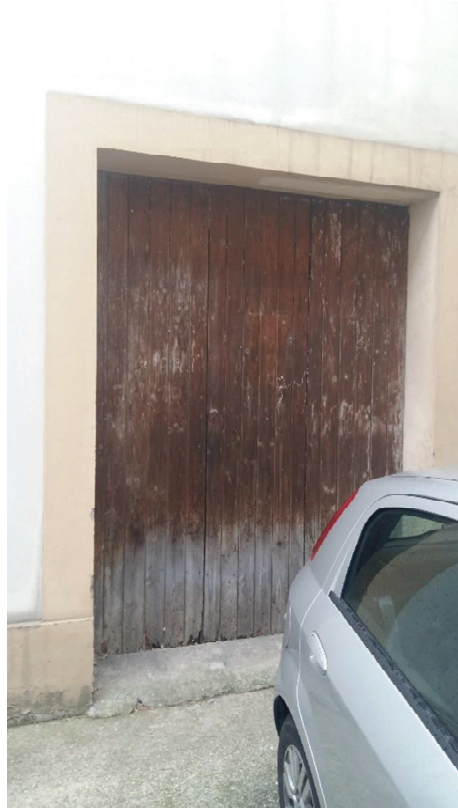
FOTO 3 – INGRESSO VIA SAFFI N. 8
