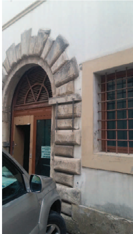
FOTO 5 – INGRESSO VIA SAFFI N. 12
