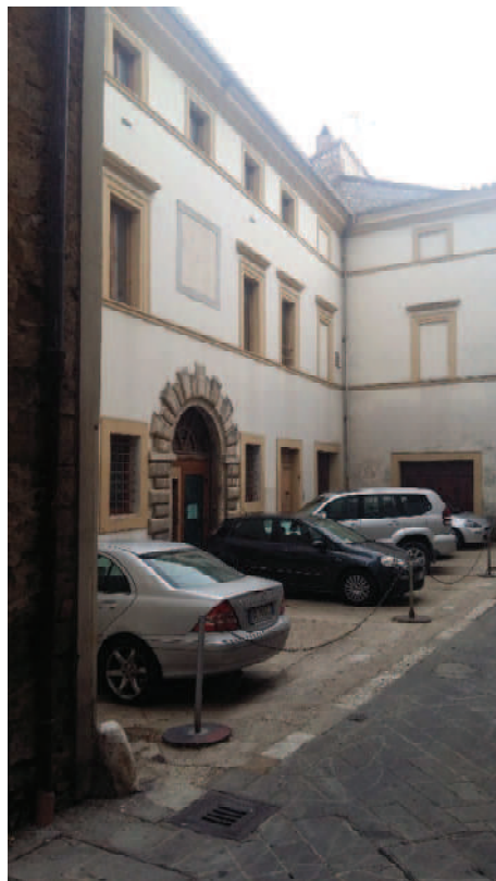
FOTO 2 – INGRESSO VIA SAFFI N. 12
