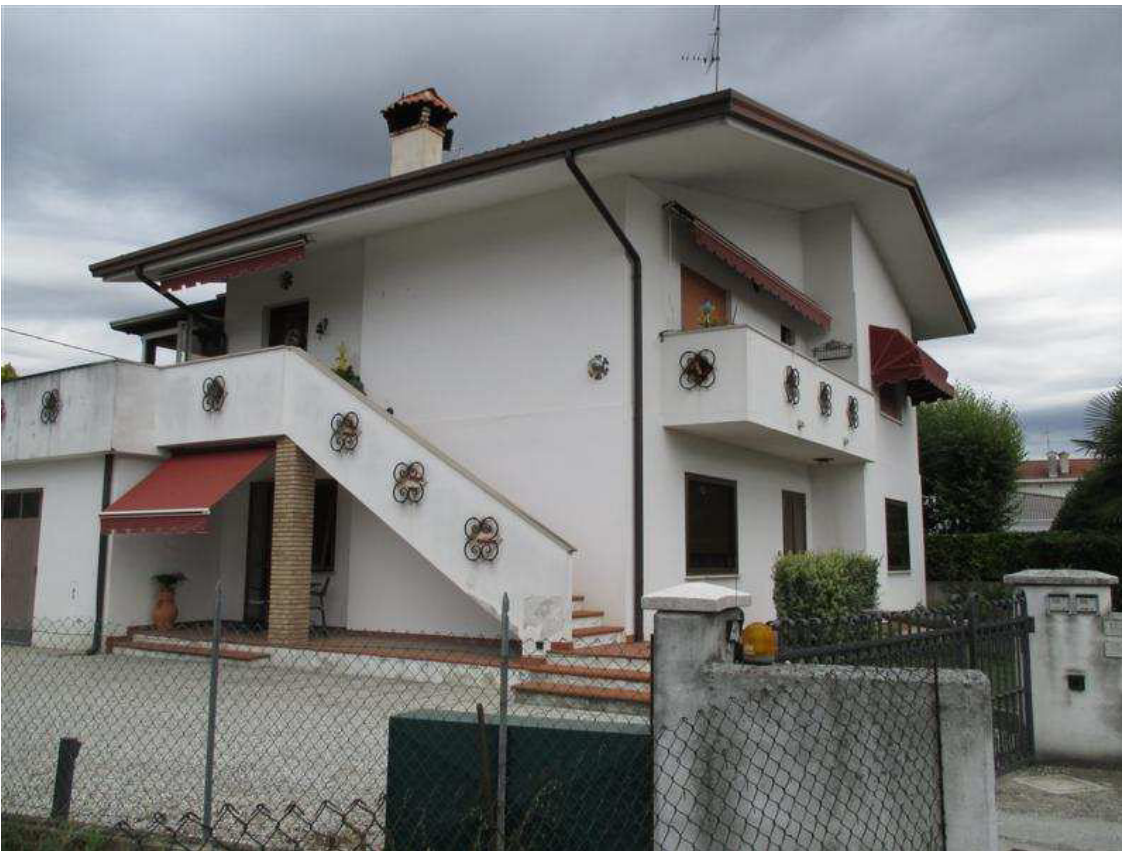
5) Veduta d'insieme del fabbricato dal cancello di ingresso
