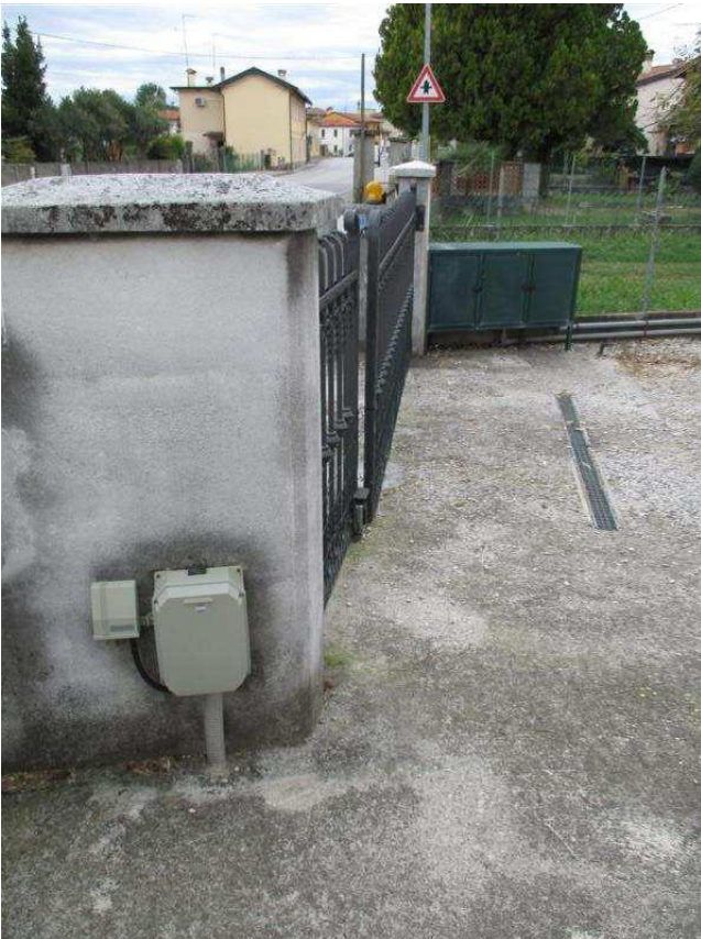
17) Particolare cancello di ingresso
