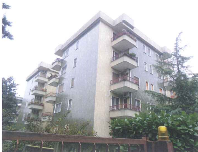
Edificio - vista dall'esterno lato sinistra
