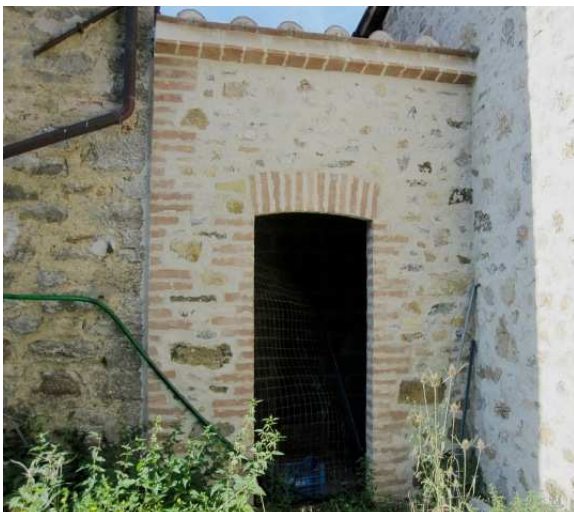
ACCESSORIO A/2) INGRESSO RETROSTANTE NORD
