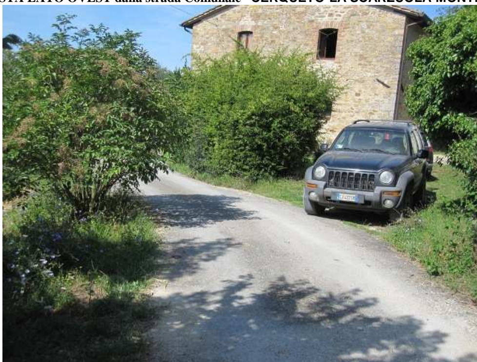
A/1) VISTA LATO OVEST OVEST dalla strada Comunale "CERQUETO-LA SCARZUOLA-MONTEGIOVE"
