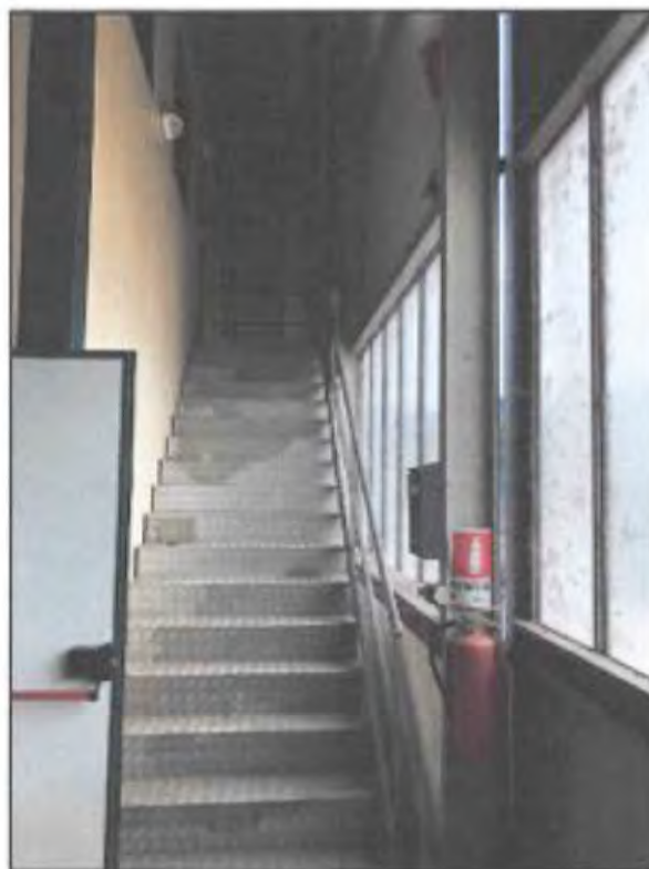
Scala esterna palazzina uffici
