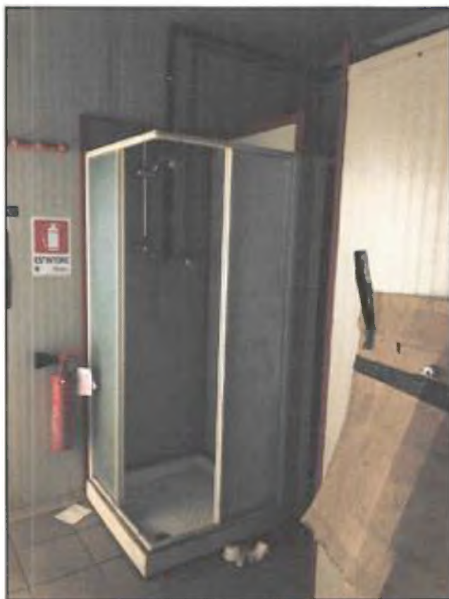
Locale WC palazzina uffici
