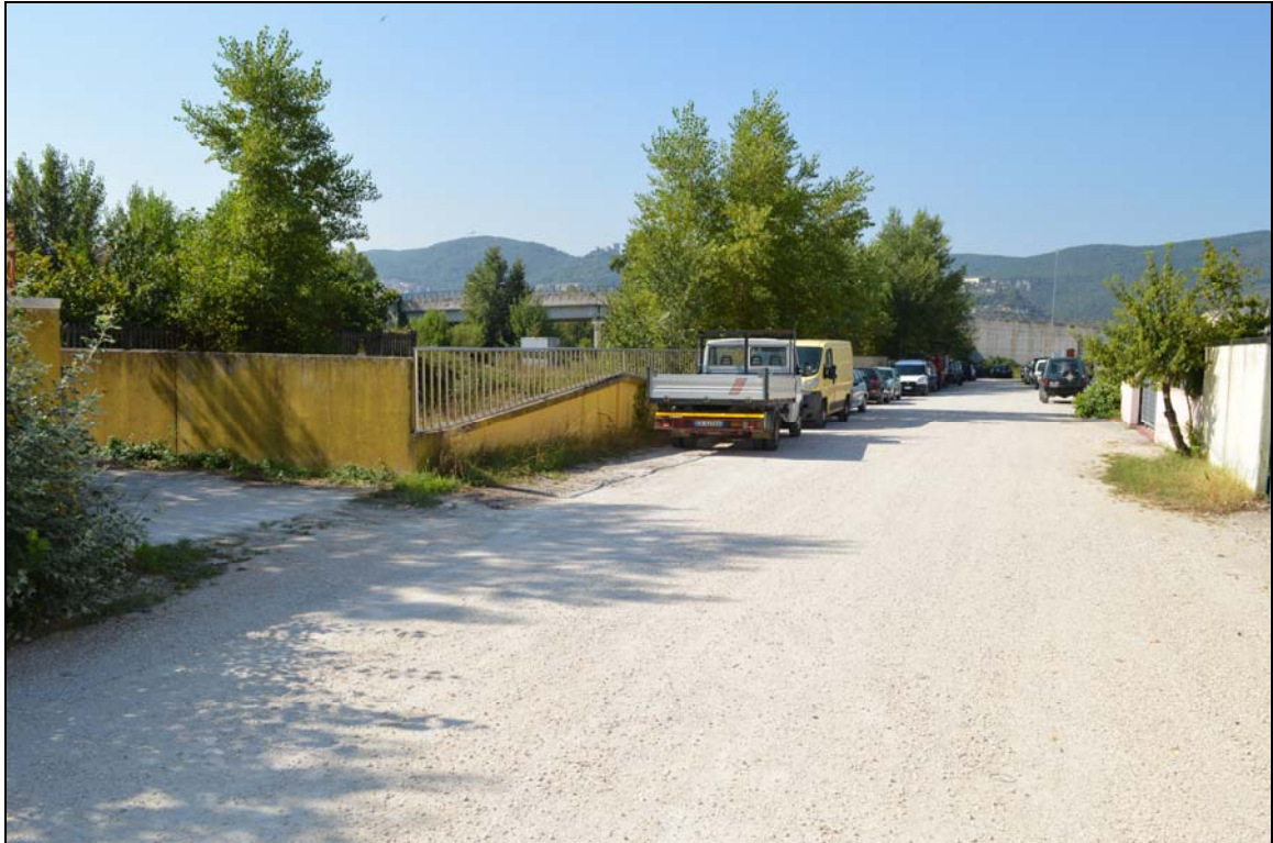
Foto n. 3 – Recinzione del lotto lungo Via Germi
