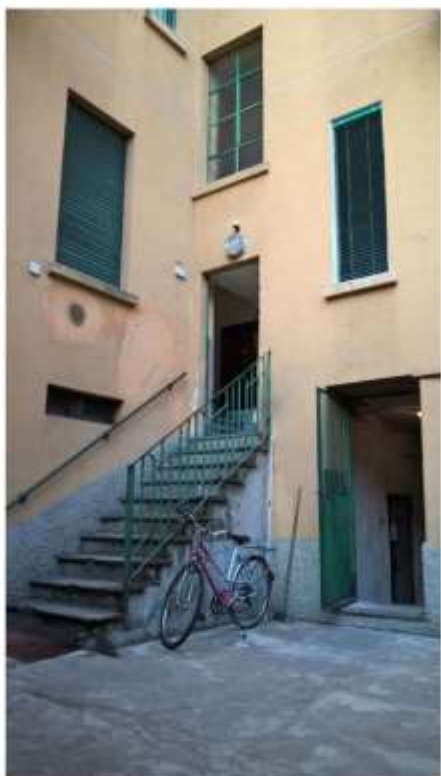
Foto n. 17: Accesso al Cortile e alle Cantine
