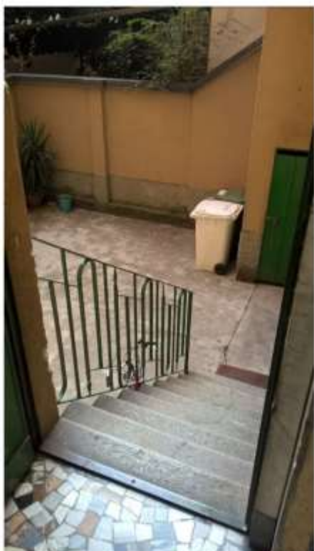
Foto n. 16: Scala di accesso al Cortile
