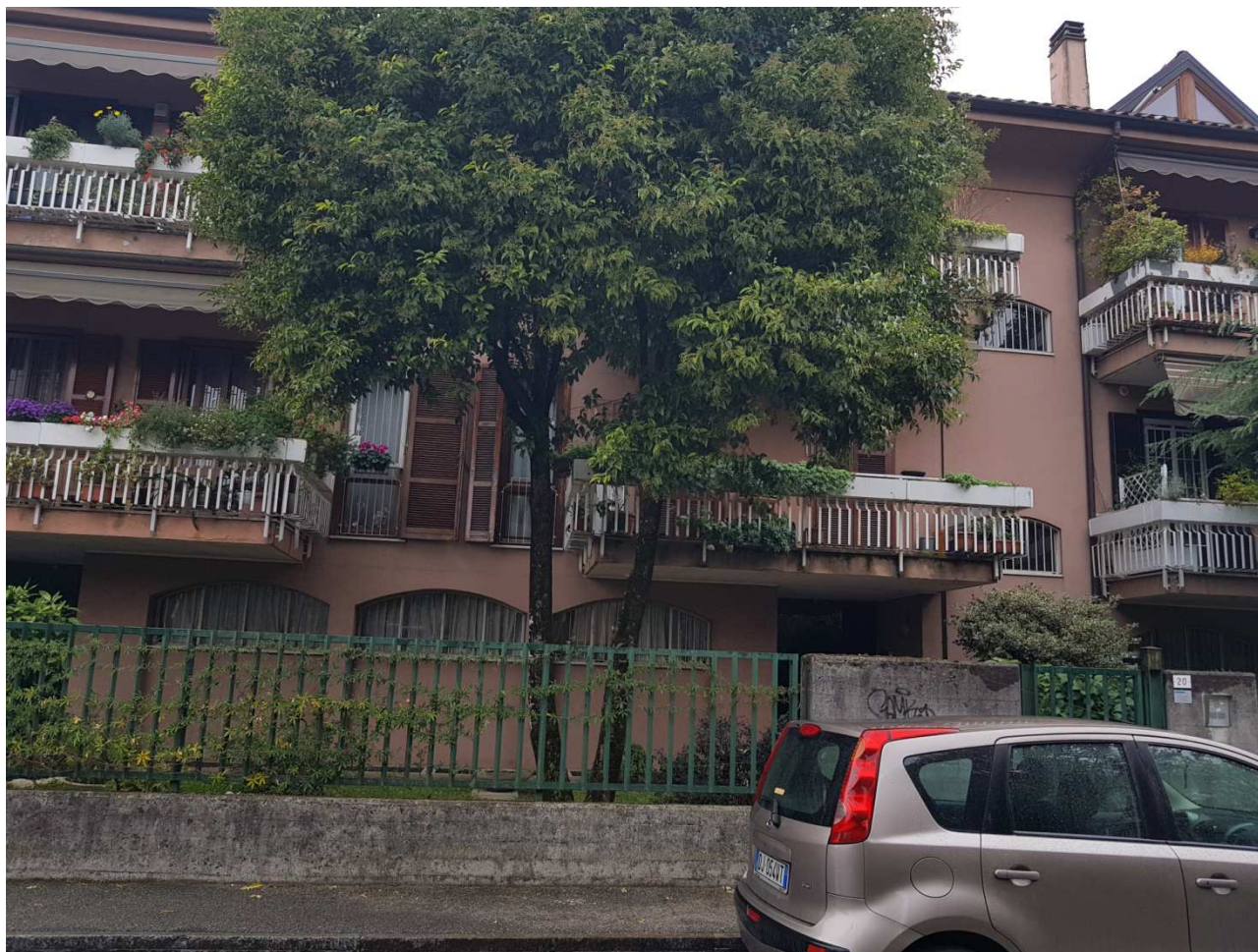
Figura 1-Vista dall' immobile da Via Lombradia
