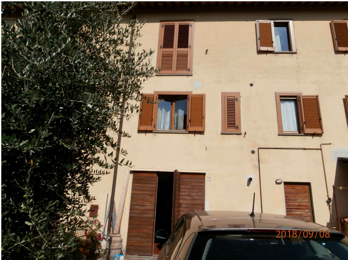
Foto n.22. – Primo piano della porzione di facciata posteriore di pertinenza dell'unità immobiliare staggita.
