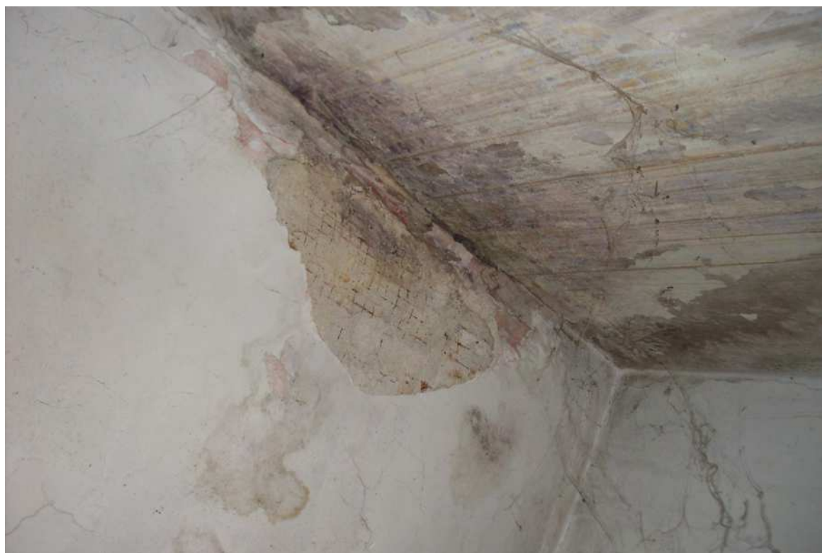
-Veduta interna locale camera –
