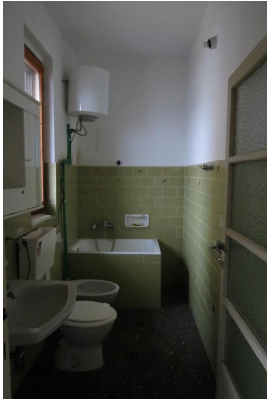
Locale bagno al piano primo.
