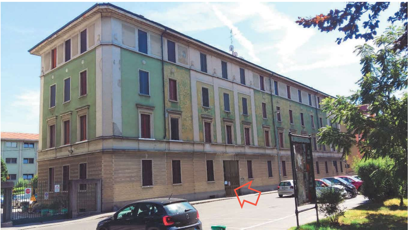
Vista del fabbricato da via Vincenzo Monti
