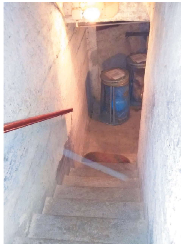
Viste scala accesso cantine
