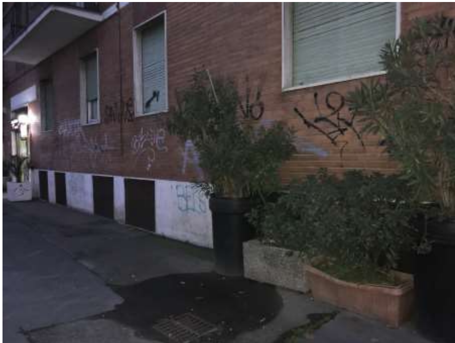
Immagine 10. Vista dall'esterno. Le finestre del piano seminterrato sono quelle nella fascia della zoccolatura.
