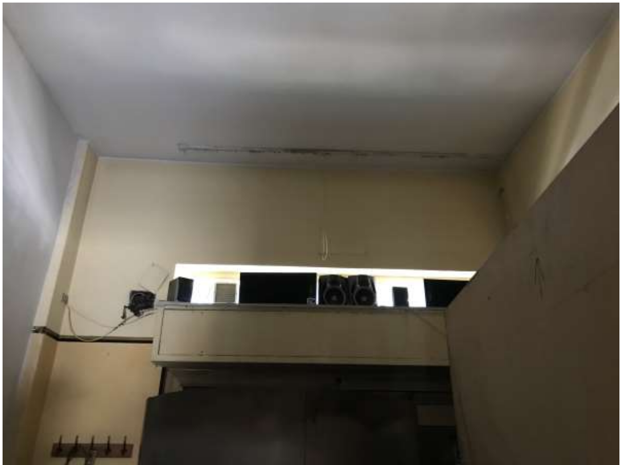
Immagini 7 e 8. Foto della parete realizzata (sulla destra).
