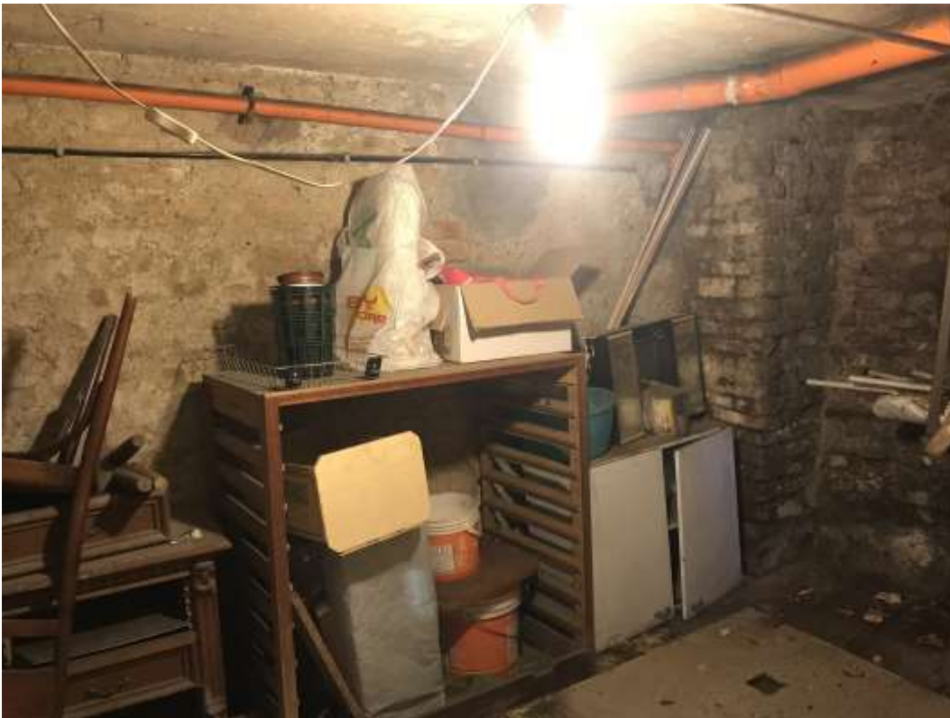
Immagini 9 e 10. Scale per la discesa al piano seminterrato e vista interna della cantina.
