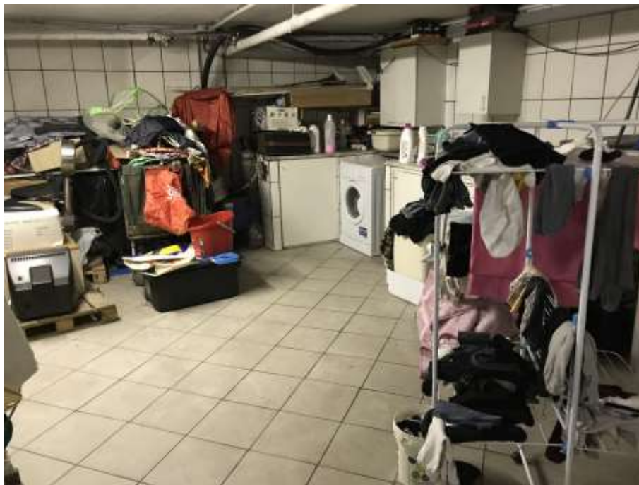
Immagini 3 e 4. Vista degli interni. La porzione senza finestre corrisponde alla parte del fabbricato in cui il piano terra è destinato a attività commerciali. L'altezza interna è dunque minore ( h=1,90 m).
