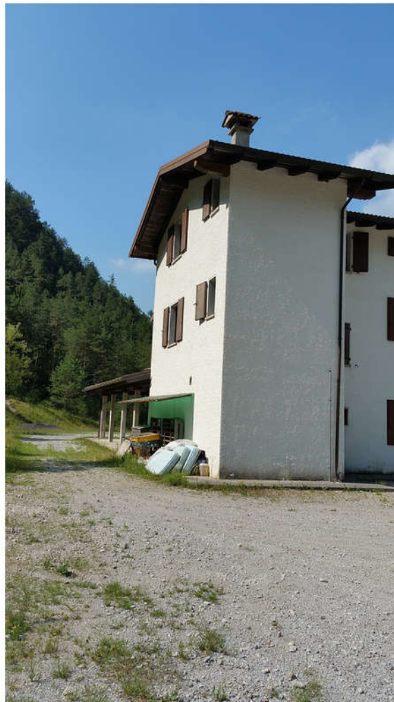
13 - lato nord est
