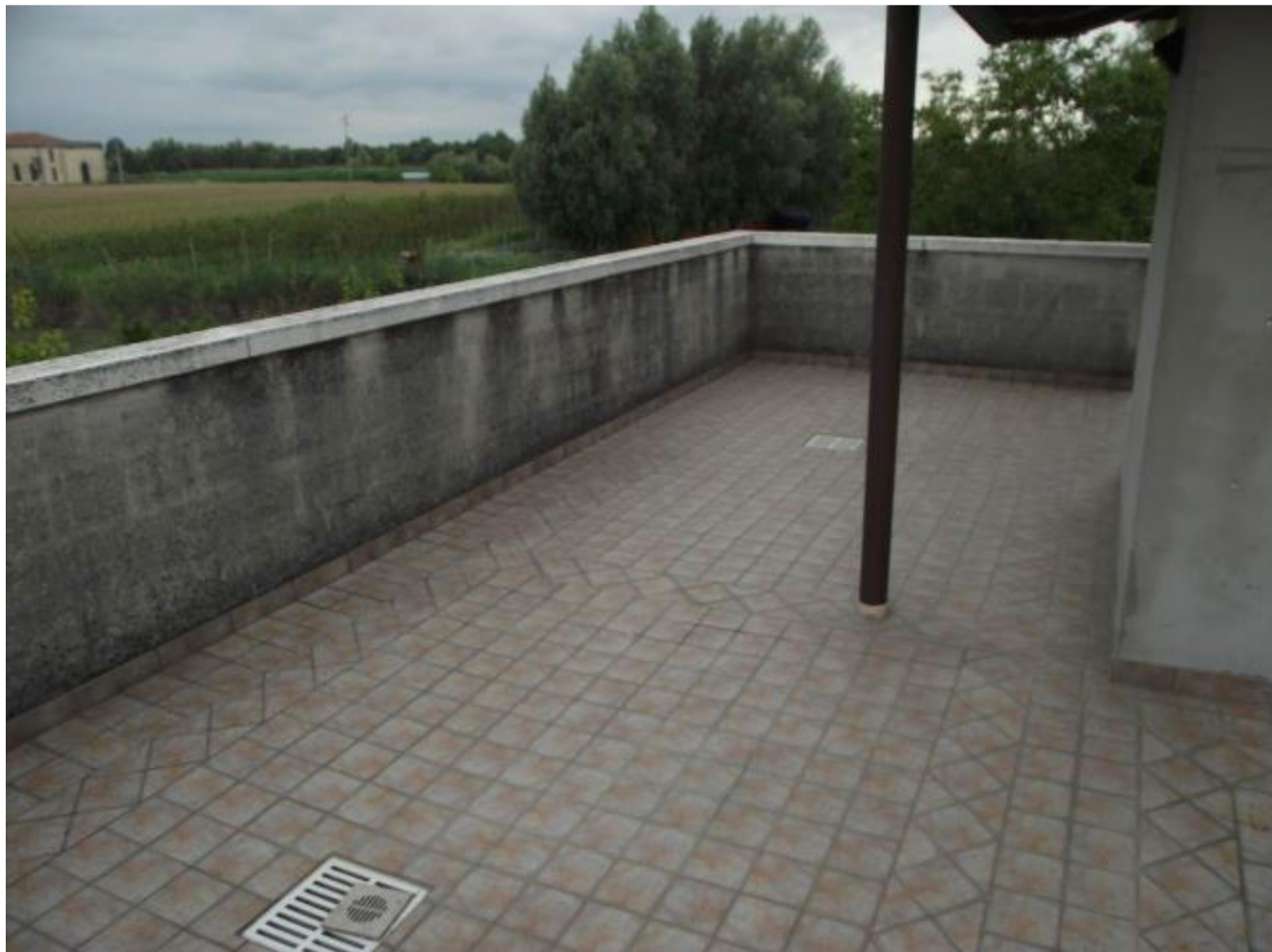
Foto 26 – terrazzo, lato edificio
