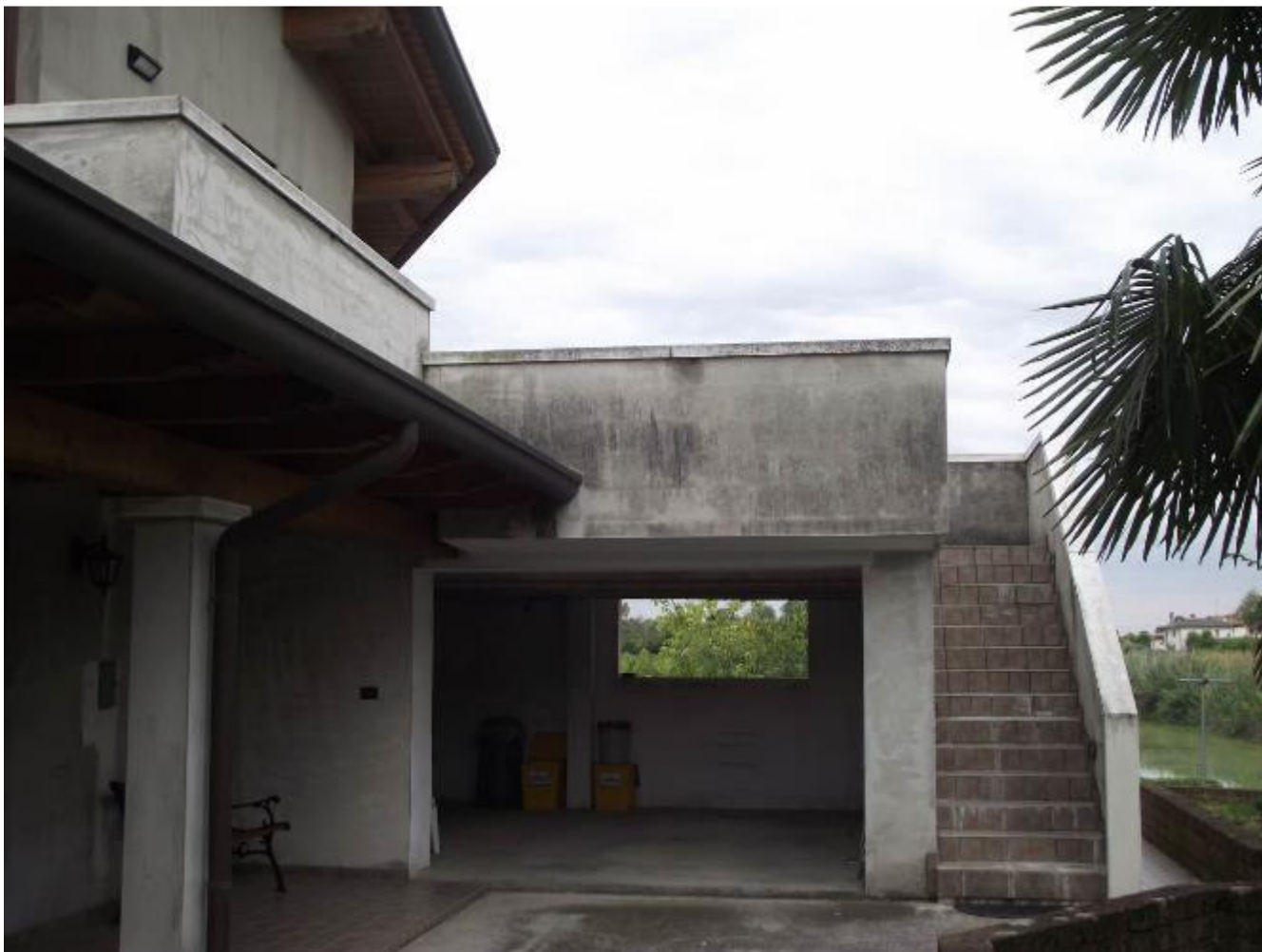
Foto 5 – scalinata di accesso e autorimessa
