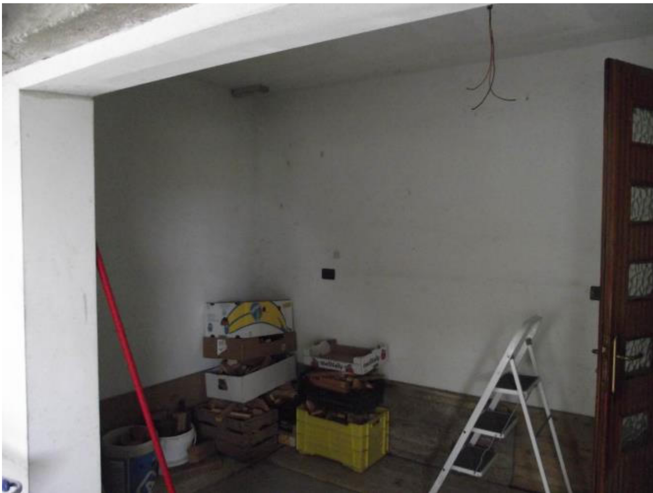
Foto 11 – ripostiglio nell'auto rimessa
