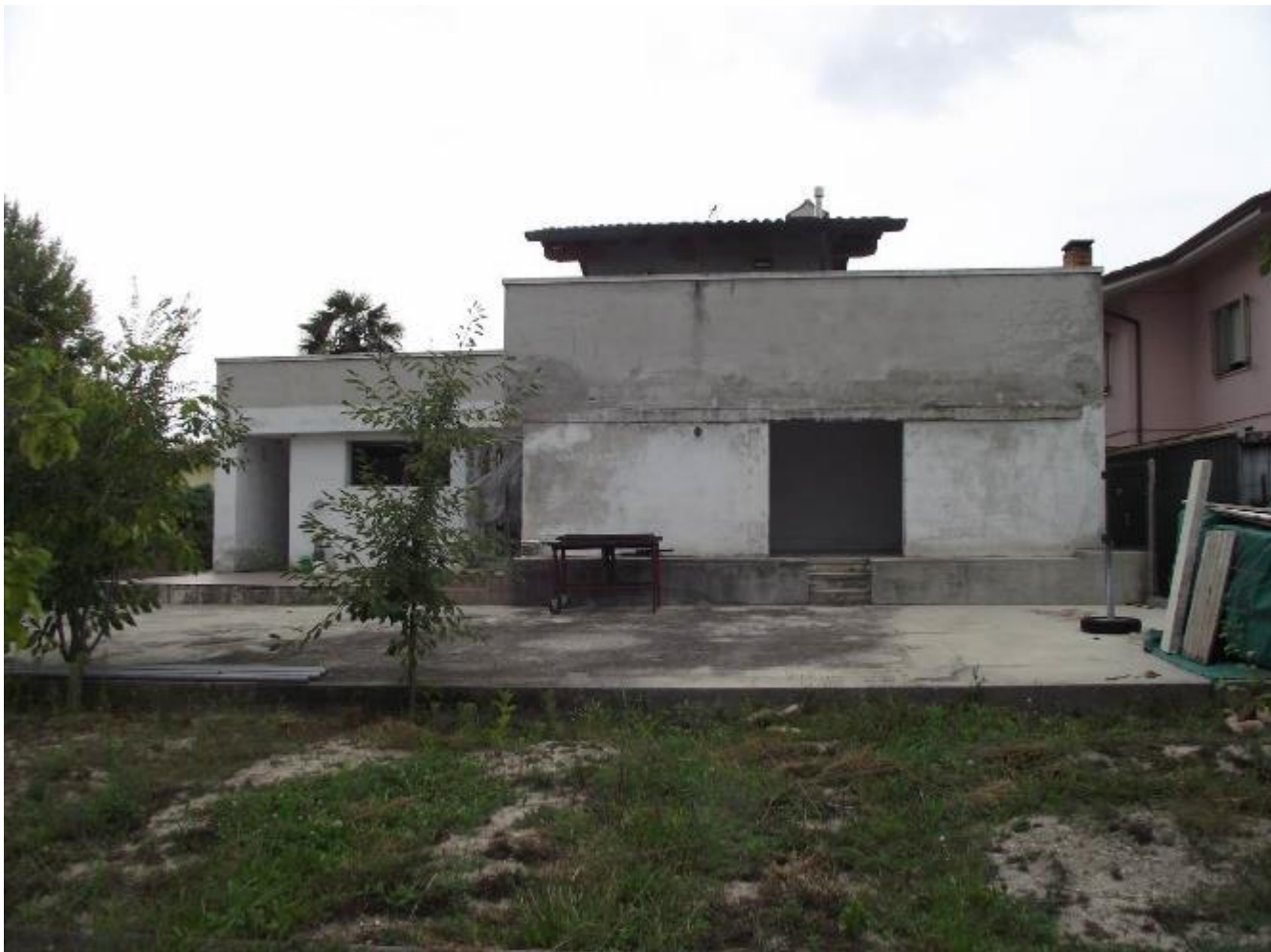
Foto 6 vista posteriore zona autorimessa e terrazza
