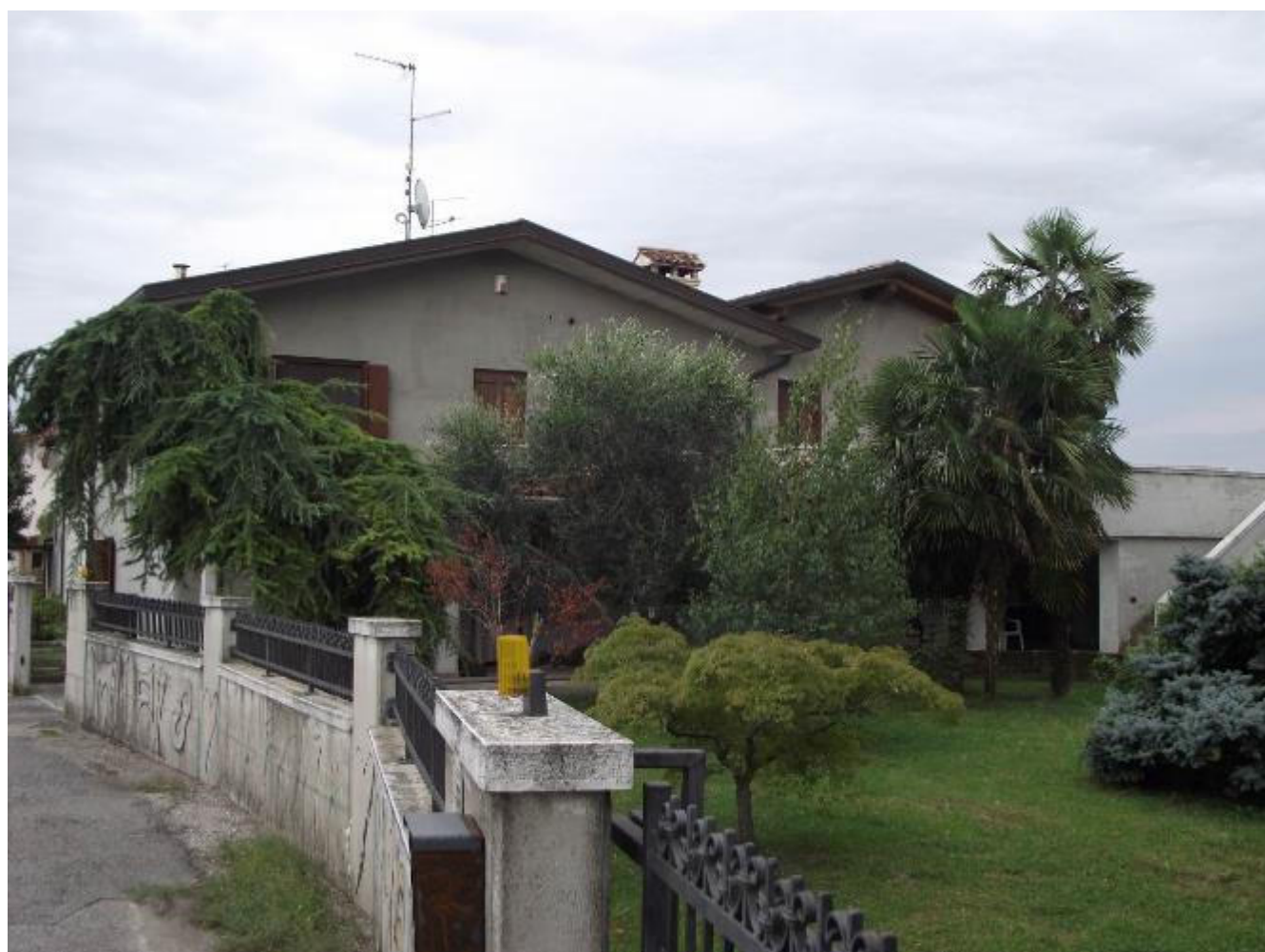
Foto 2 – prospetto verso strada
