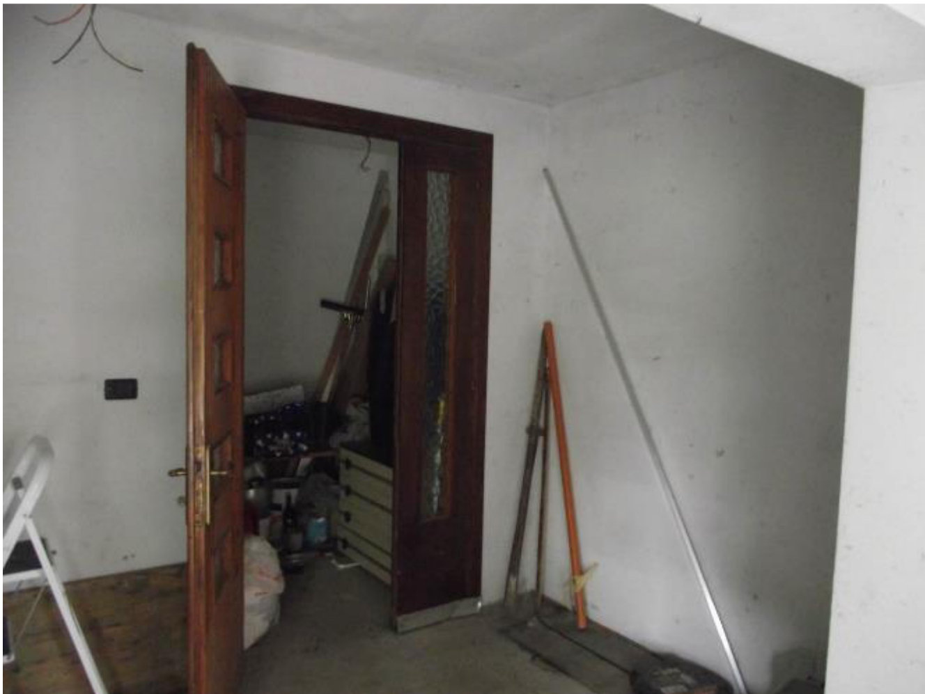
Foto 12 – altro ripostiglio nell'auto rimessa
