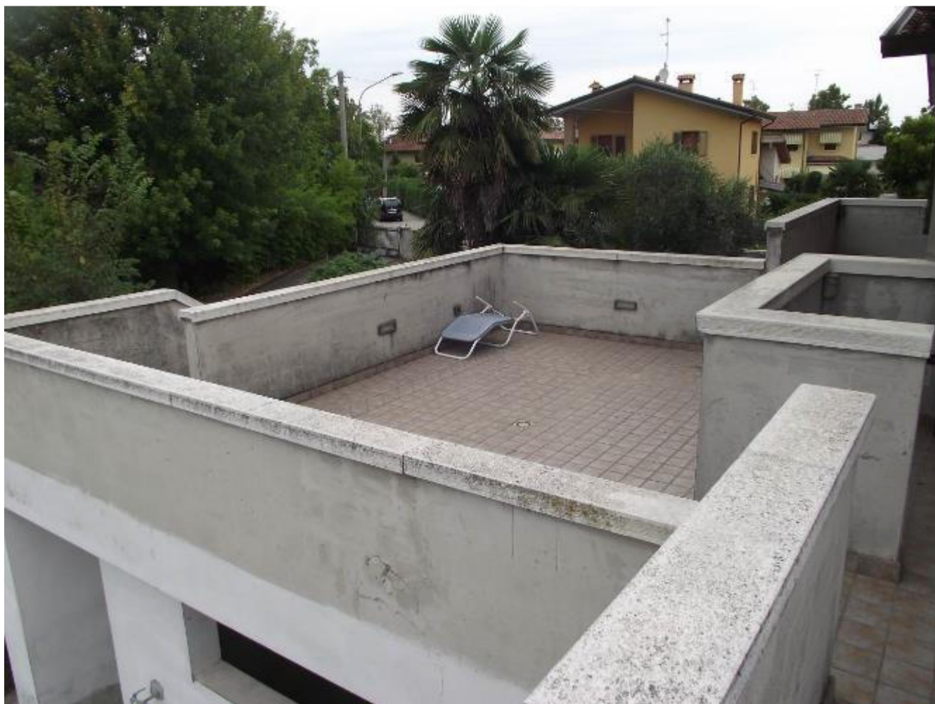
Foto 25 – terrazzo sul fronte principale, sopra autorimessa
