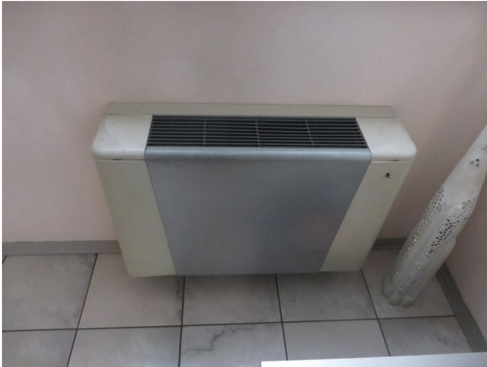
FOTO 33: VENTILCONVETTORE
