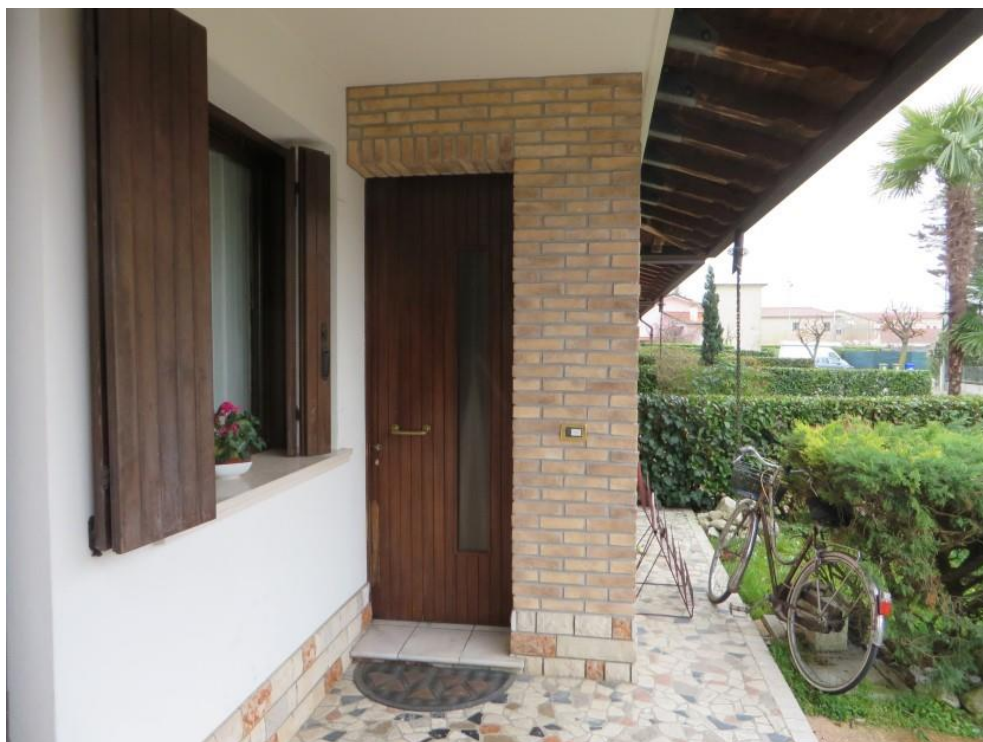
FOTO 11: INGRESSO ABITAZIONE (Piano Terra)
