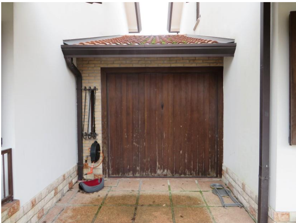
FOTO 18: ACCESSO GARAGE (Piano Terra)
