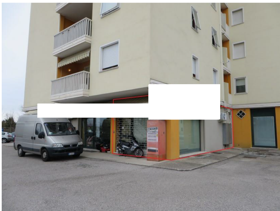
FOTO 42: PANORAMICA NEGOZIO IN ESECUZIONE
