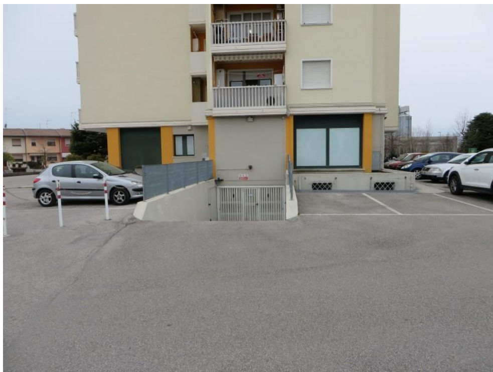
FOTO 41: AREA CONDOMINIALE E RAMPA PER PIANO INTERRATO
