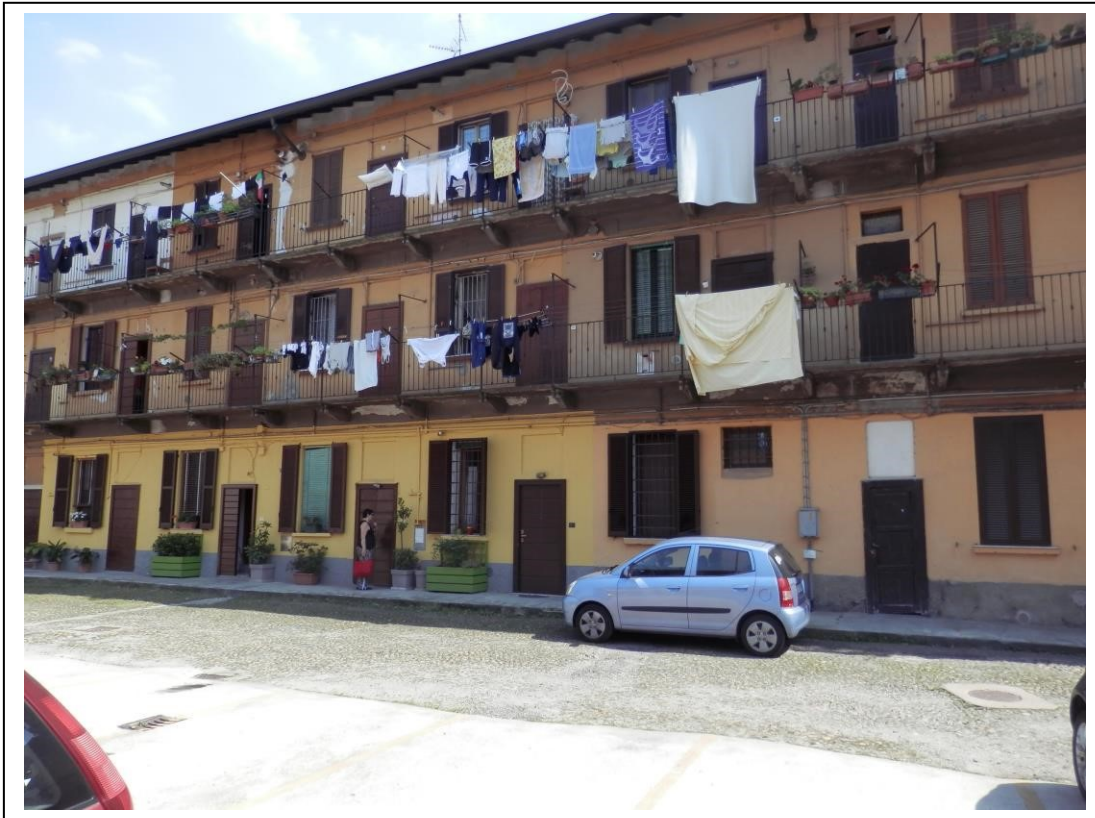
Fotografia n°3 – Vista della facciata del fabbricato rivolta sul cortile interno comune.
