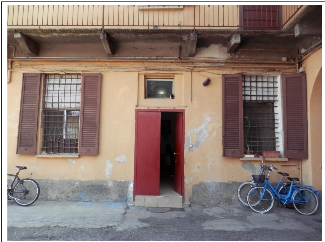
Fotografia n°4 – Vista della porta d'ingresso all'u.i. dal cortile interno comune.
