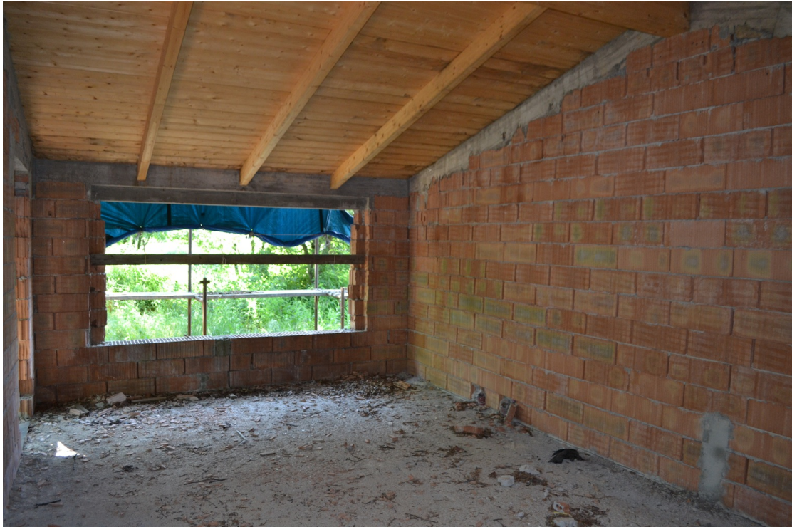
FOTO 14 – Corpo B. Interni.
