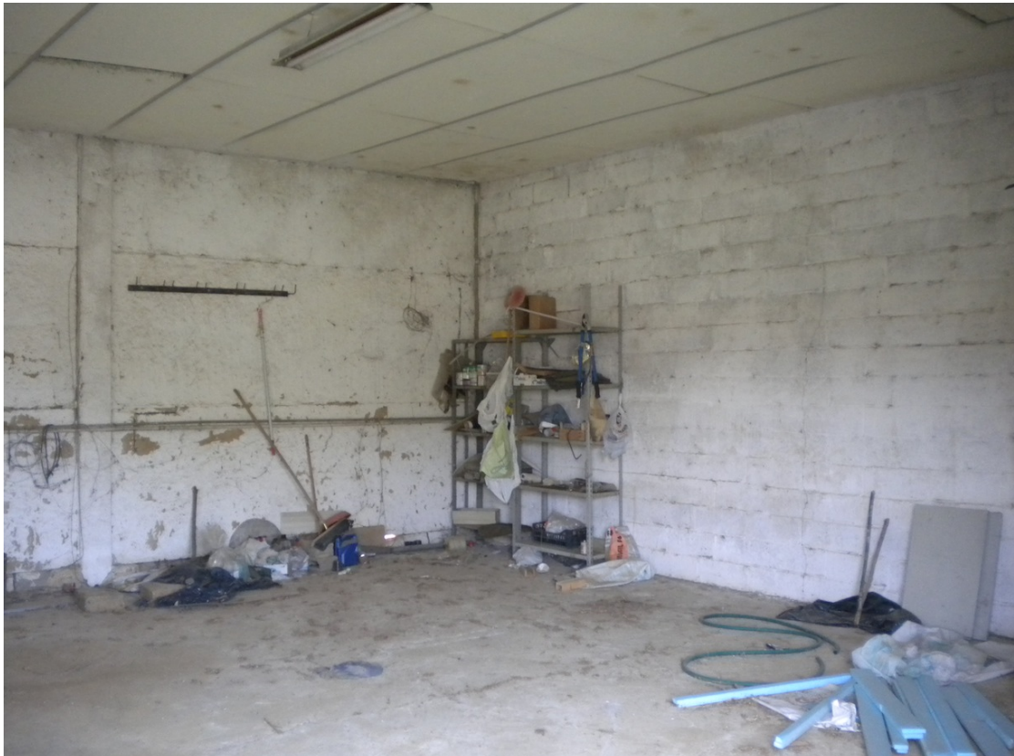
FOTO 10 – Corpo A. Unita' principale. Interni.
