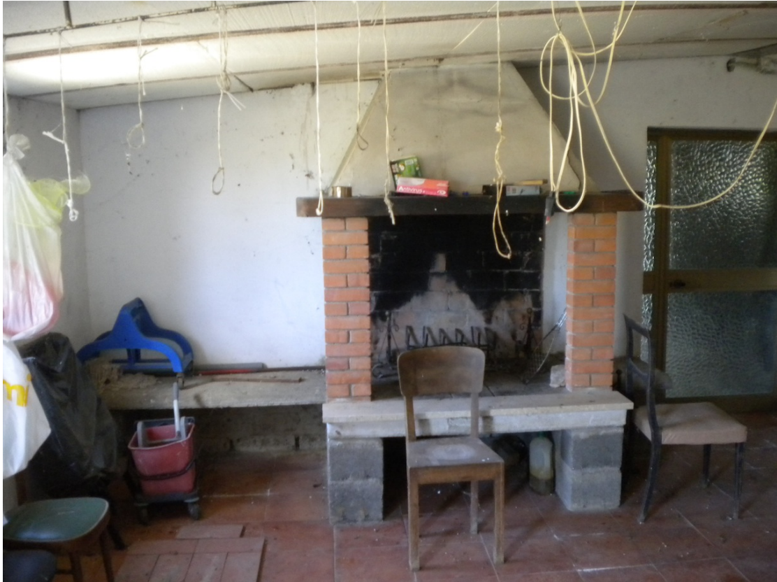
FOTO 9 – Corpo A. Unita' secondaria. Interni.
