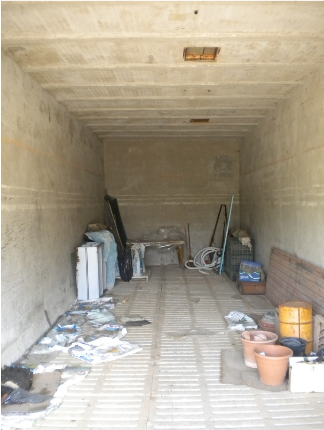
FOTO 13 – Corpo A. Unita' principale. Interni.
