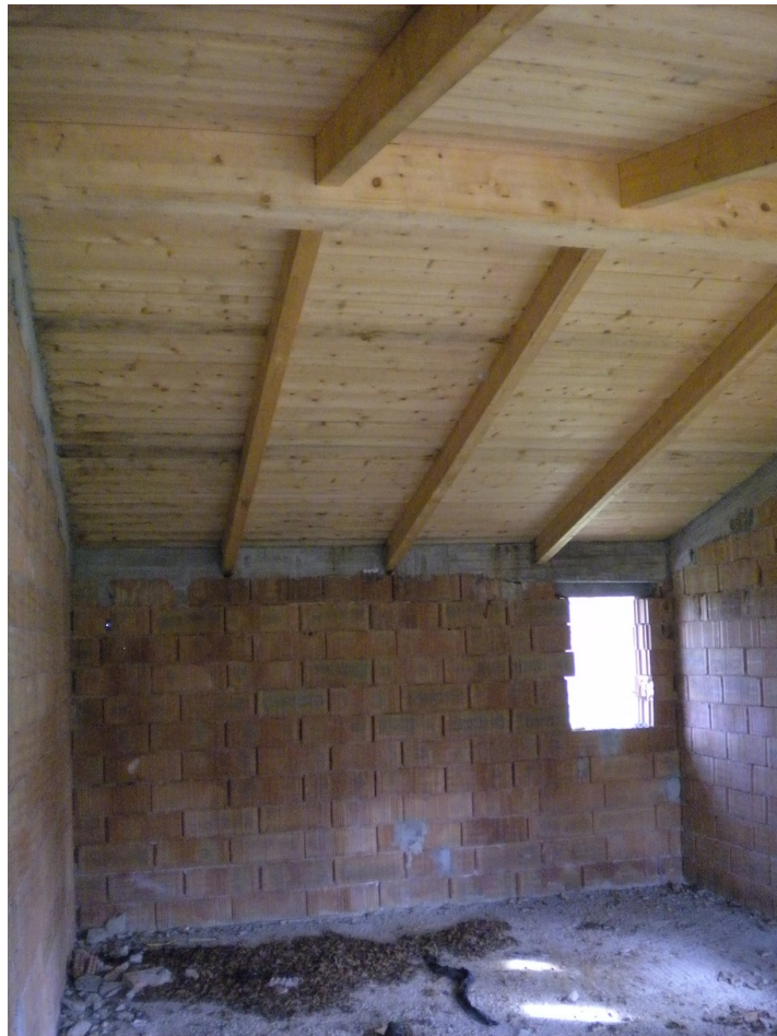
FOTO 15 – Corpo B. Interni.
