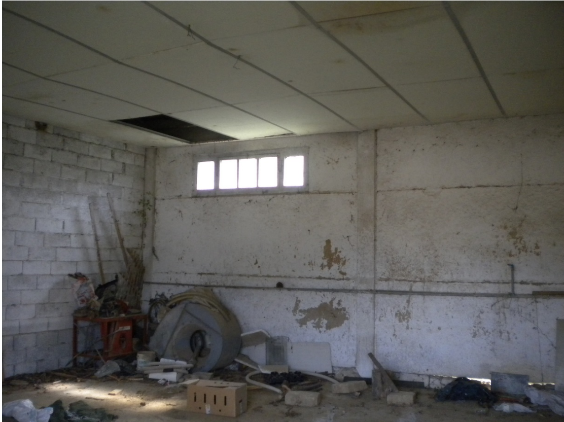
FOTO 11 – Corpo A. Unita' principale. Interni.
