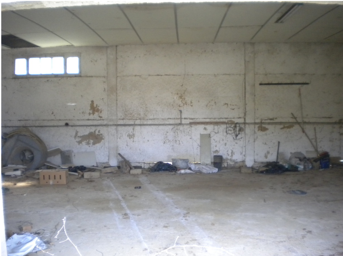
FOTO 12 – Corpo A. Unita' principale. Interni.
