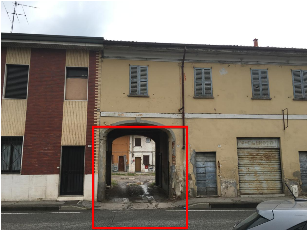
Via Roma 31 ingresso allo cortile in cui è posizionato l'ingresso all'U.I.
