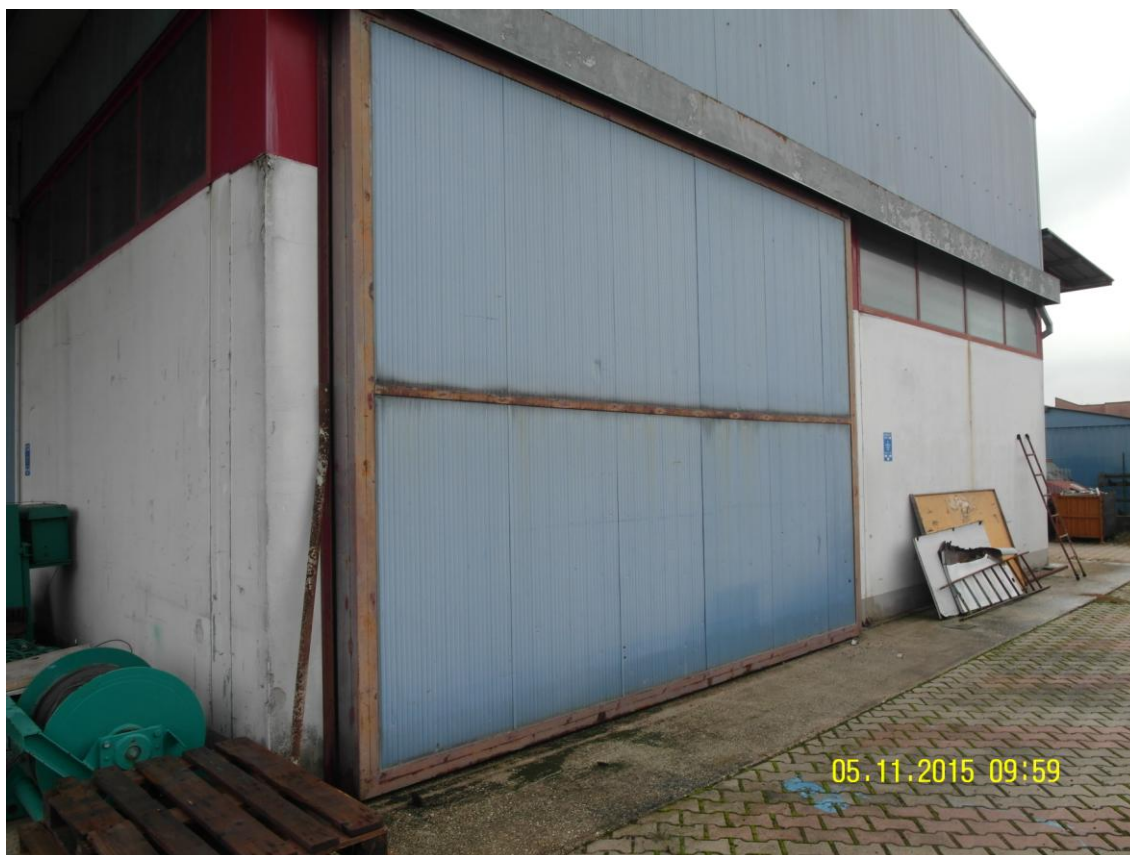
Foto n. 4: Particolare della corte esterna lato Ovest verso il canale "Recentino".
