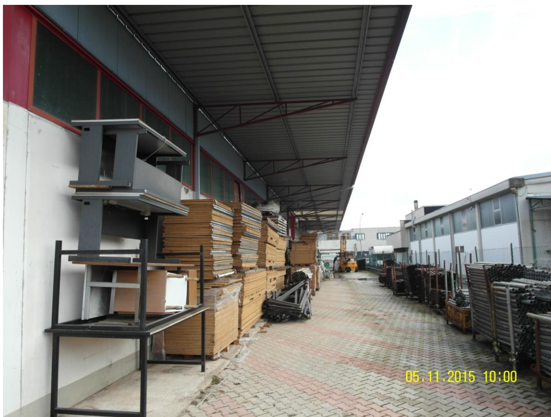
Foto n. 5: Corte esterna lato Sud.
