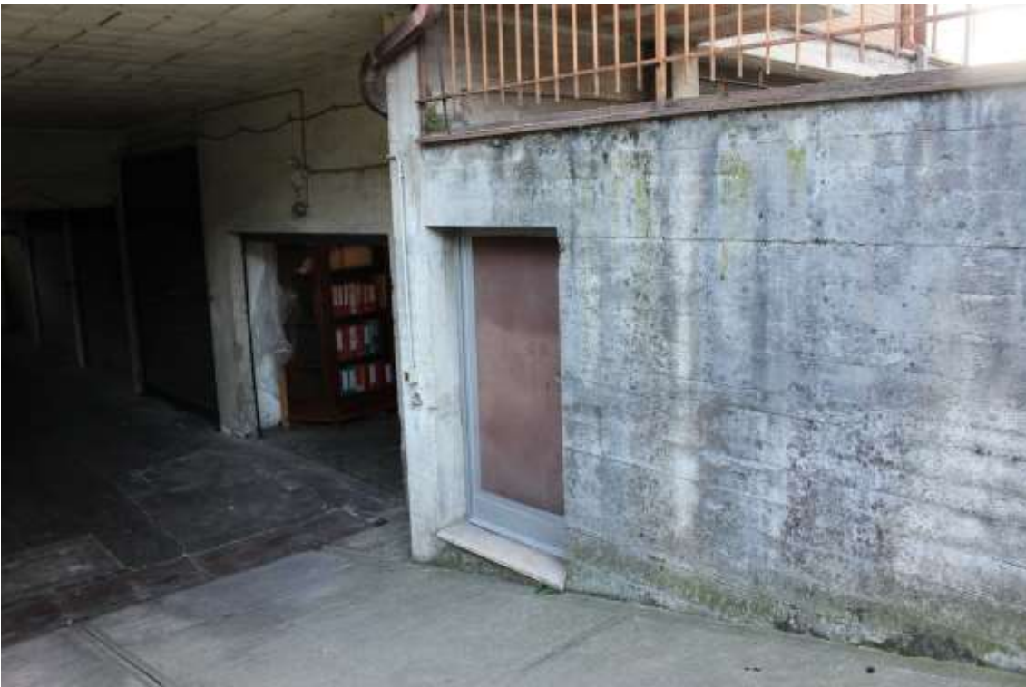
Foto 15_ interrato _rampa autorimesse
