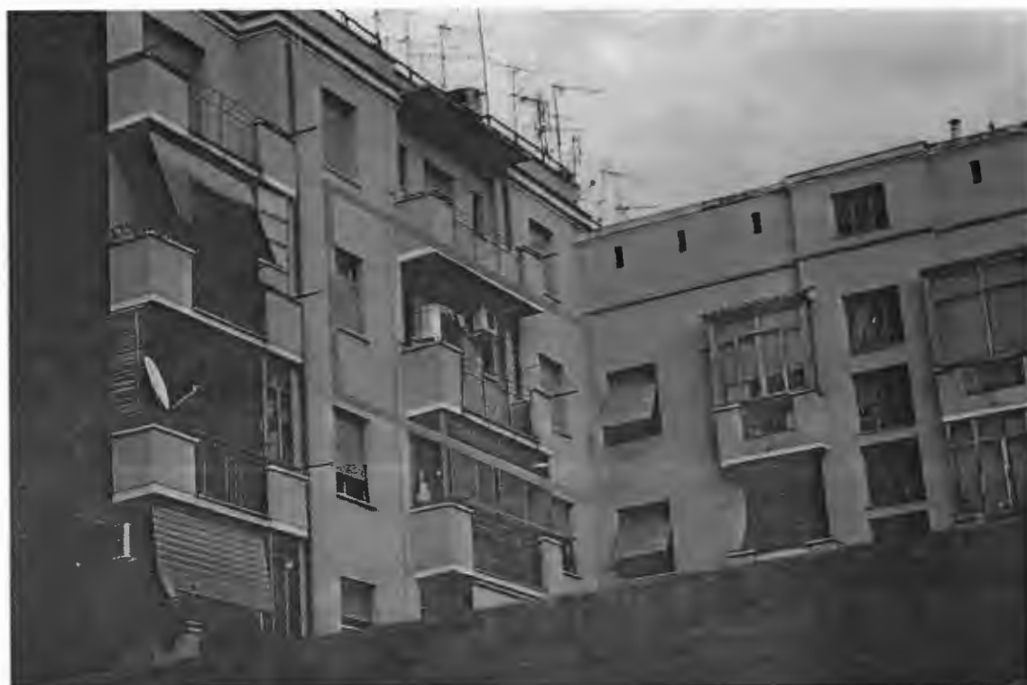
04-Localizzazione dell'unità da una vista sud dell'edificio
