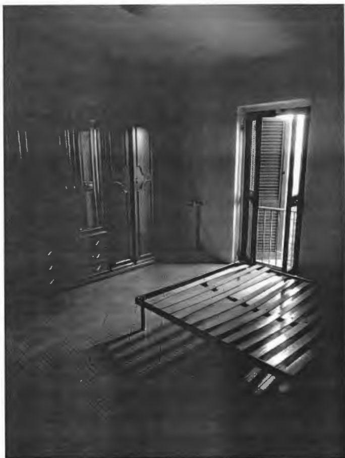
Locale 02 – La portafinestra sul fronte nord (foto n.9)
