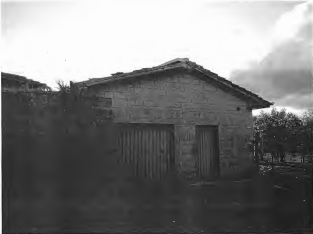
Il magazzino, fronte Nord (foto n.17)
