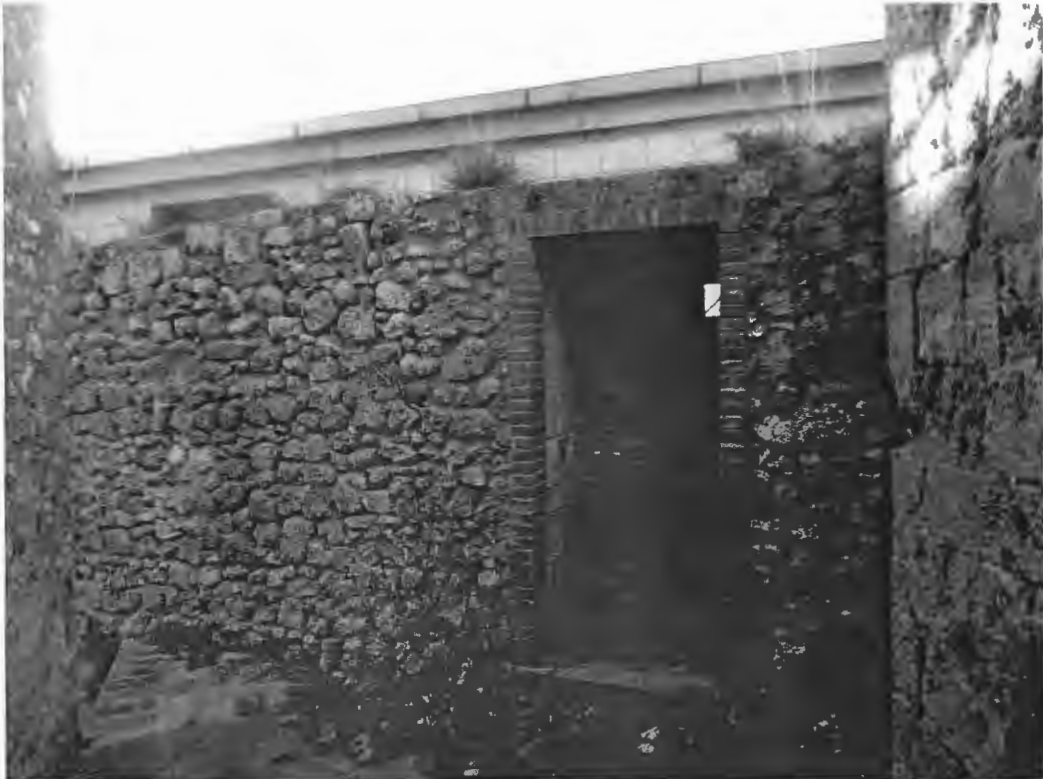
Il magazzino, ingresso dalla corte (foto n.18)
