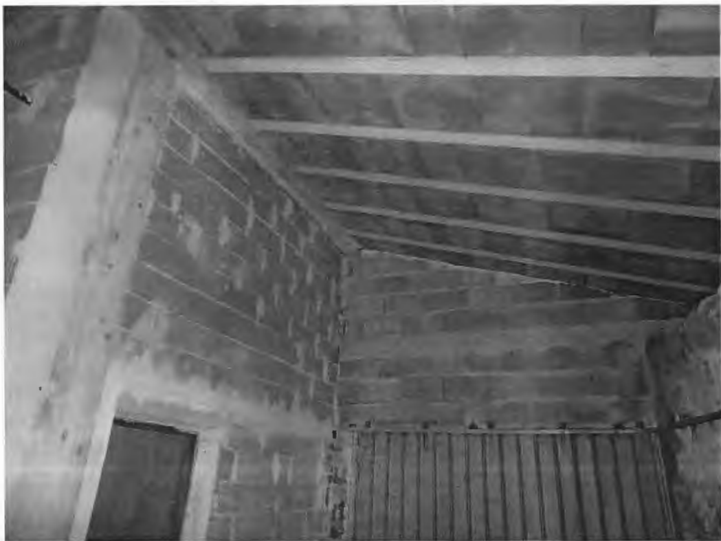
Il magazzino, pareti e copertura (foto n.20)
