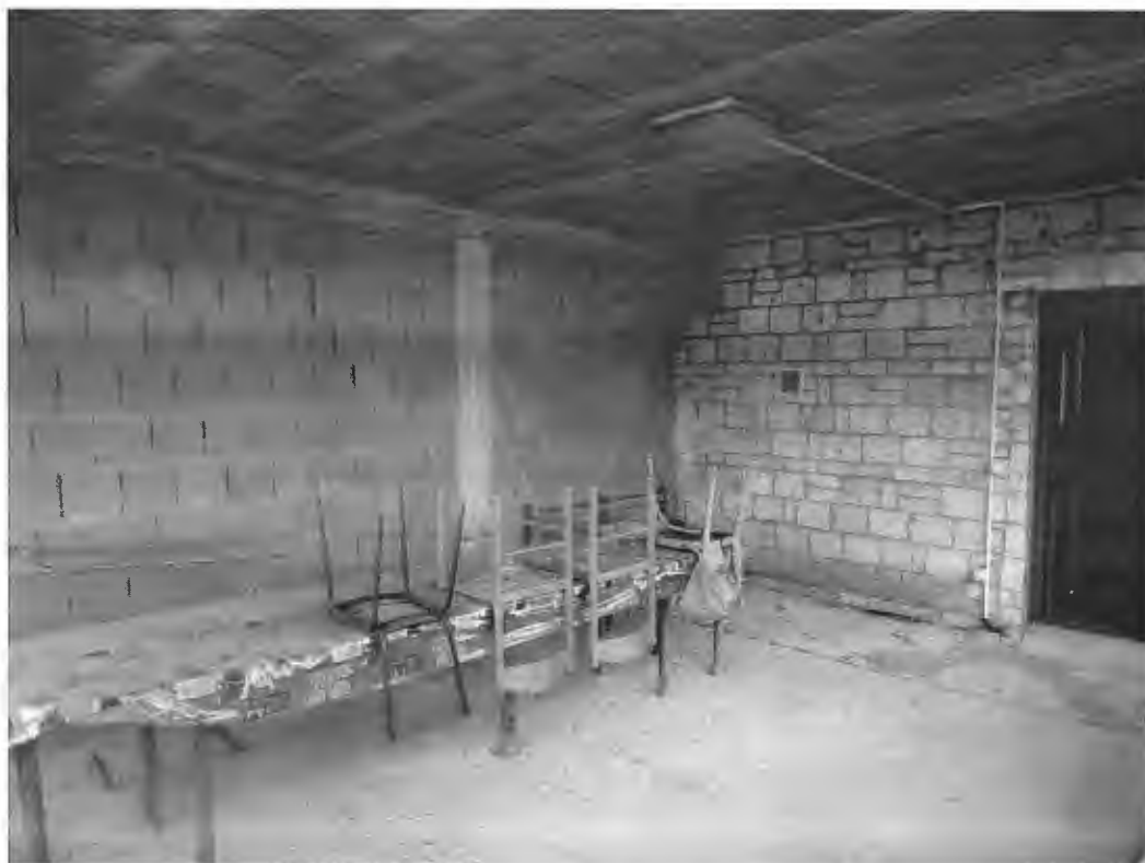
La loggia – Vista interna (foto n.13)
