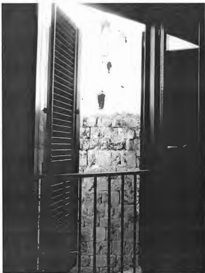
Dettaglio infissi esterni (foto n.11)
