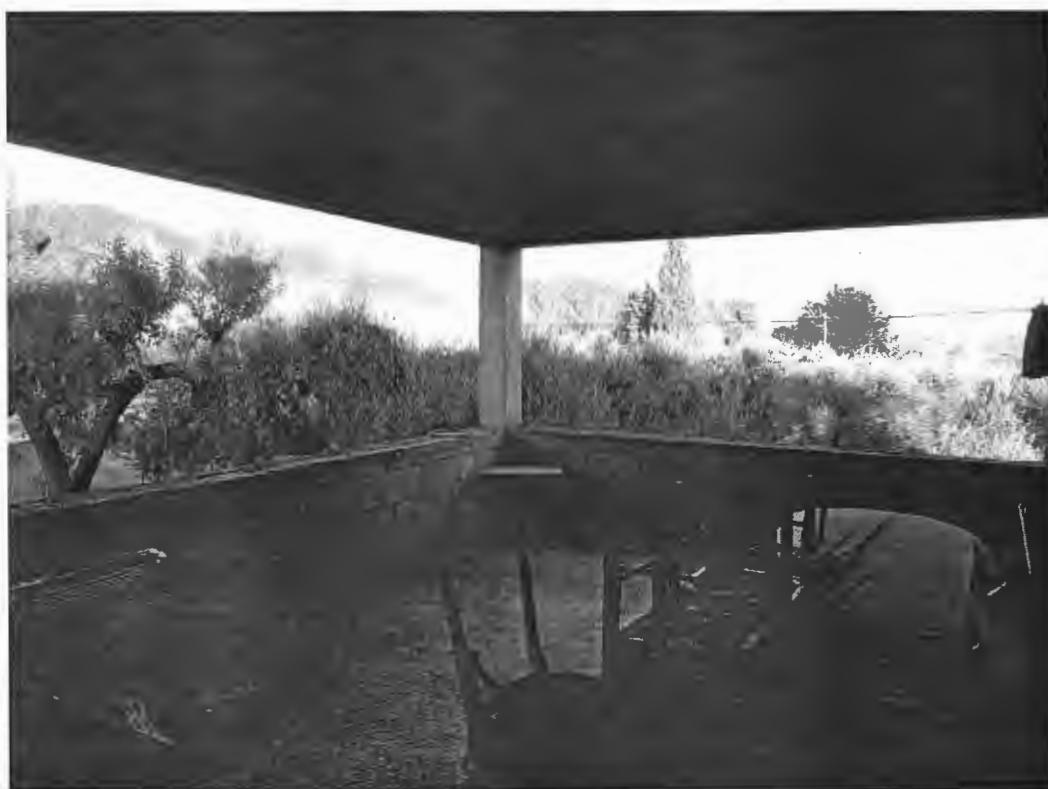
La loggia – Vista in direzione est (foto n.12)
