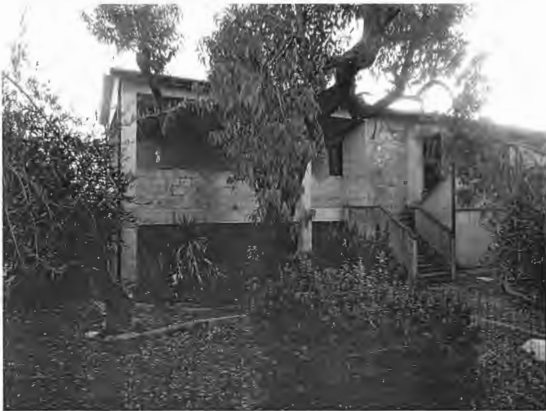
Fronte nord – Ingresso (foto n.2)
