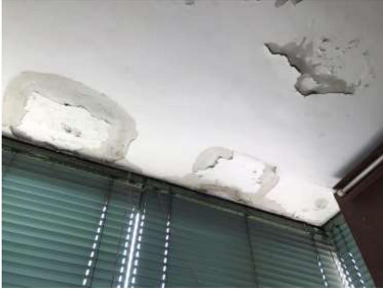
**Foto 19.** Vista del soffitto del balcone, dettaglio dei segni di degrado dovuti a infiltrazioni dalla copertura o dalla gronda.
