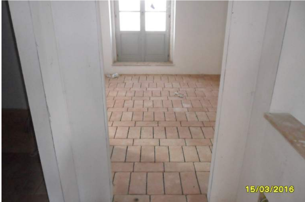
CORPO B - interno fabbricato
