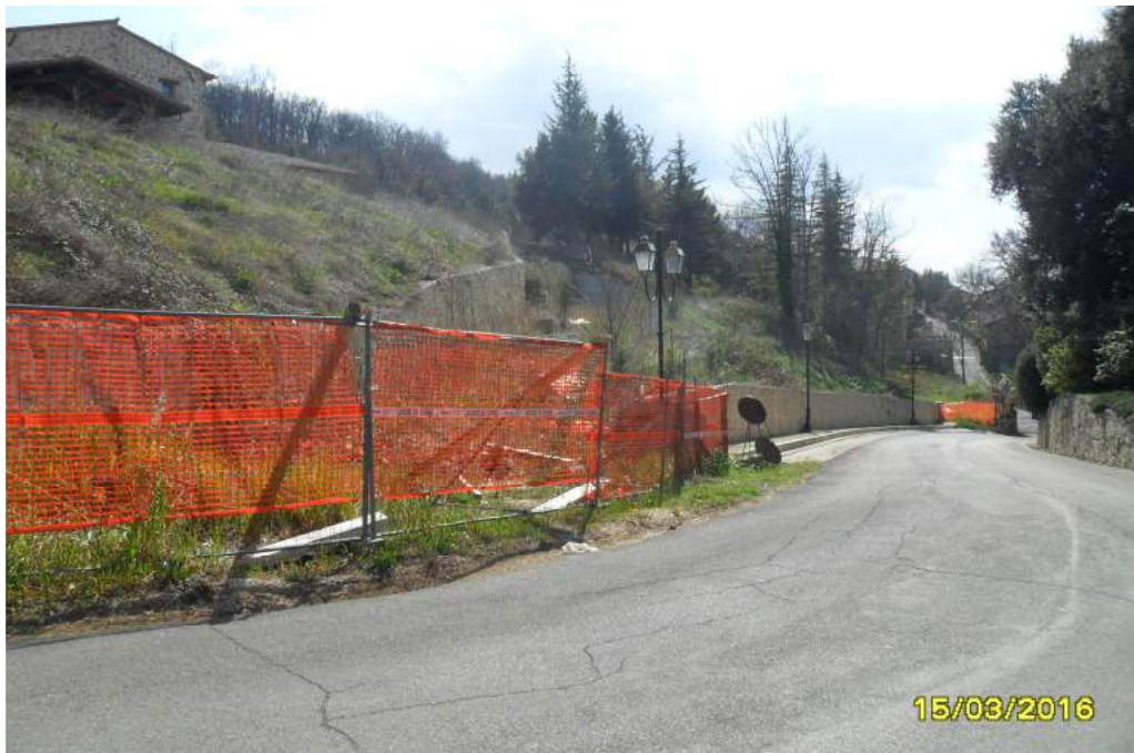
opere urbanizzazione lottizzazione (dalla via San Rocco)
