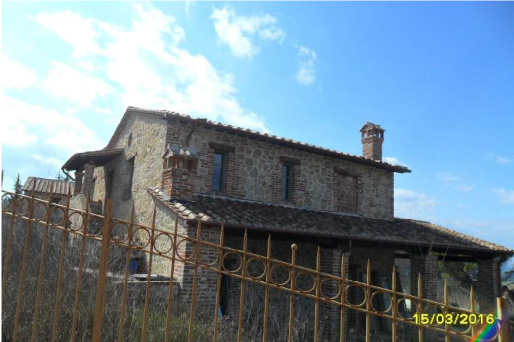
CORPO B - esterno fabbricato
