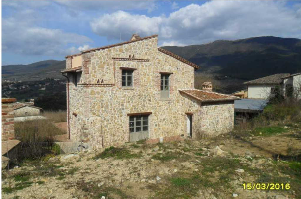
CORPO F - esterno fabbricato
