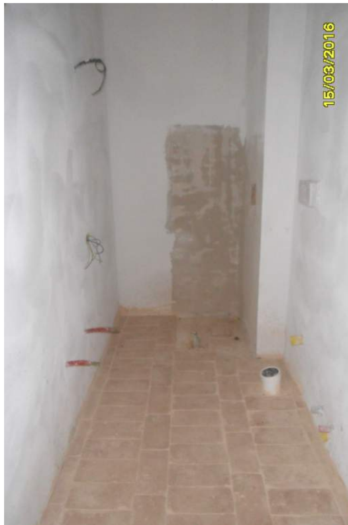
CORPO A - interno fabbricato
