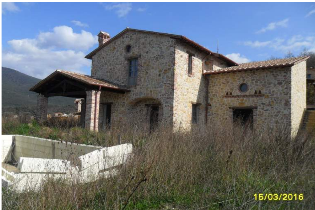
CORPO B - esterno fabbricato
