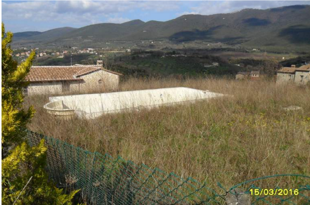
CORPO F - esterno fabbricato
