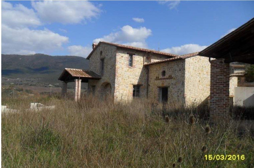
CORPO B - esterno fabbricato
