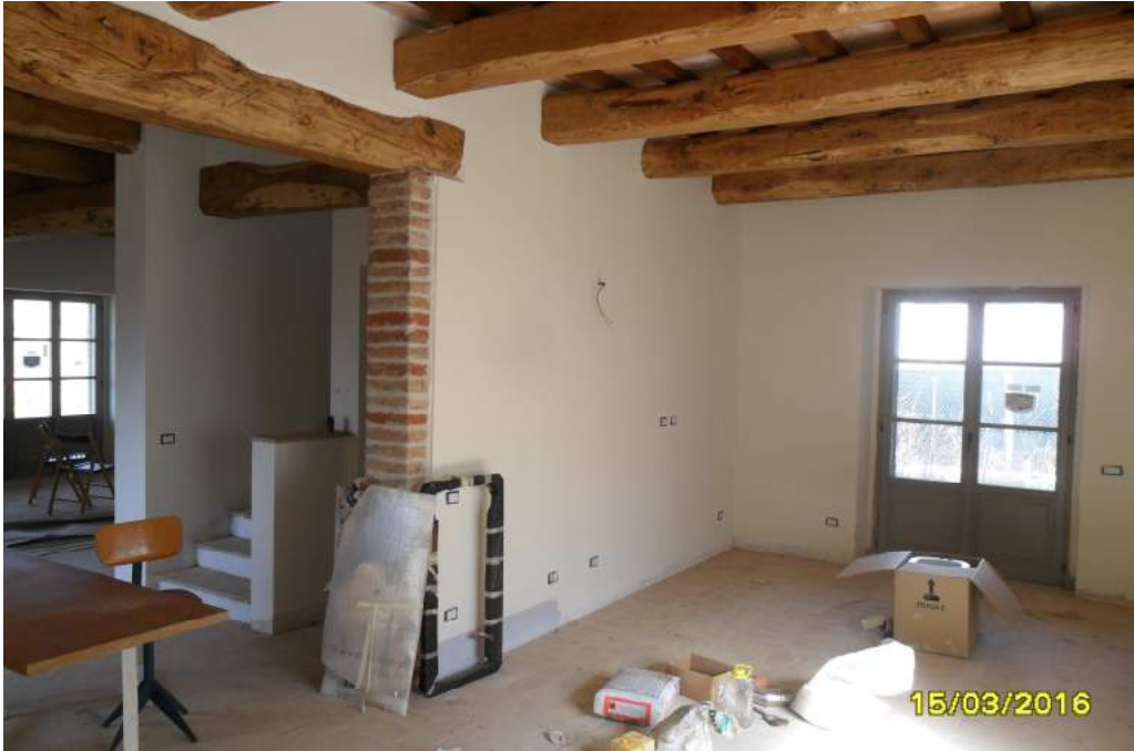
CORPO F - interno fabbricato
