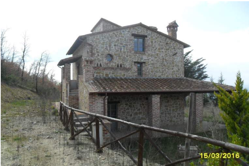
CORPO D - esterno fabbricato
