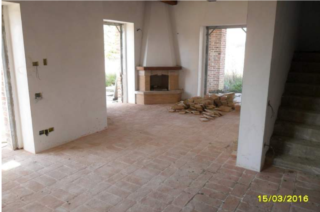
CORPO B - interno fabbricato
