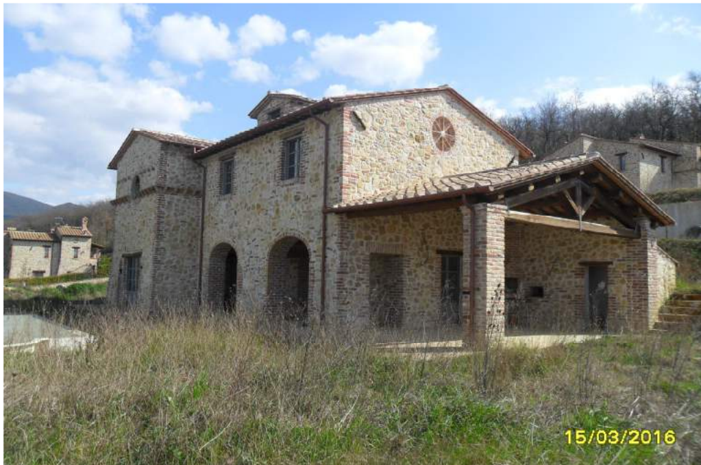
CORPO A - esterno fabbricato
