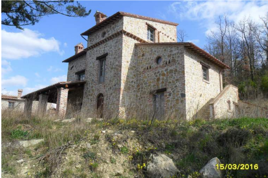
CORPO D - esterno fabbricato
