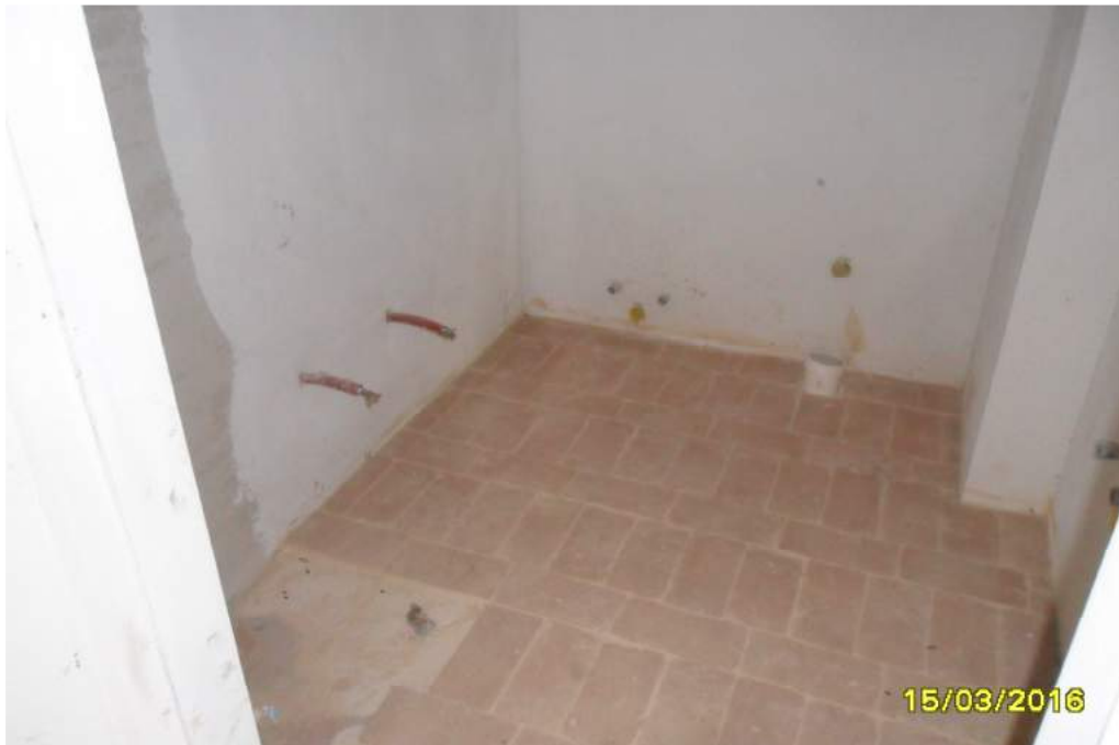
CORPO A - interno fabbricato
