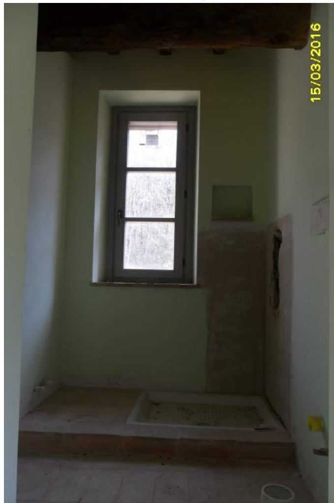
CORPO D - interno fabbricato
