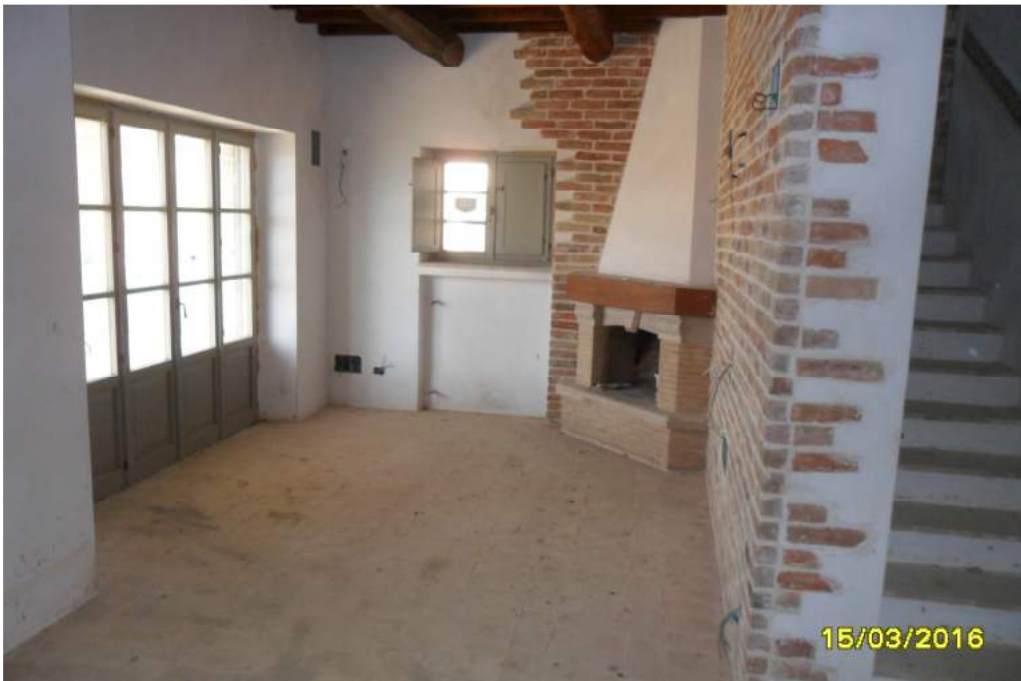
CORPO C - interno fabbricato
