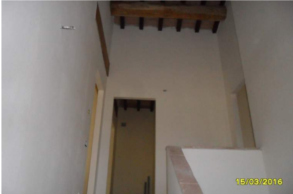
CORPO F - interno fabbricato
