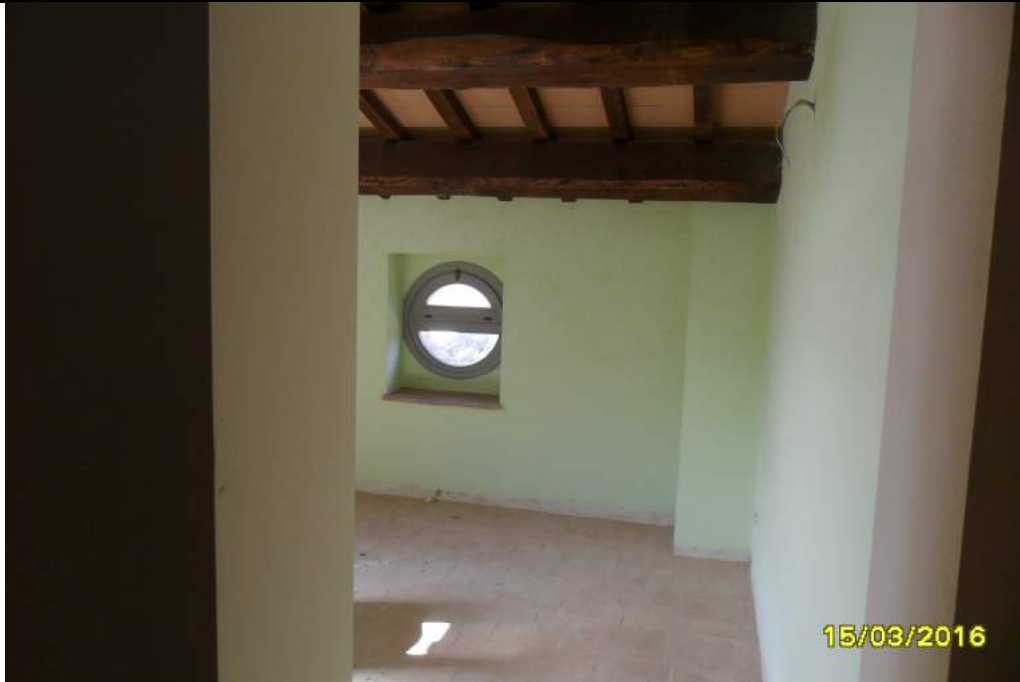
CORPO D - interno fabbricato
