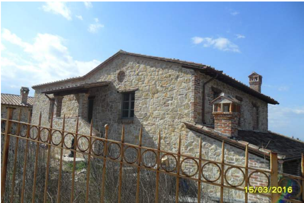
CORPO B - esterno fabbricato
