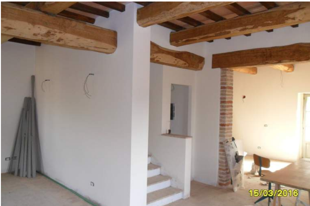
CORPO F - interno fabbricato
