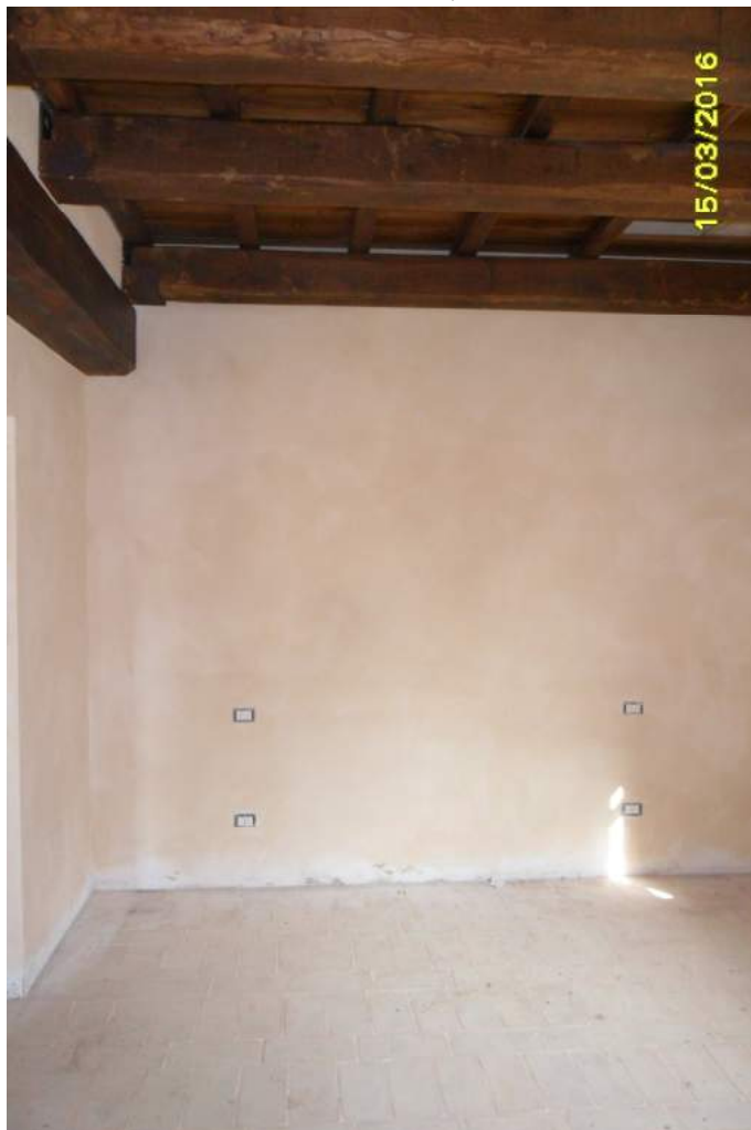
CORPO E - interno fabbricato
