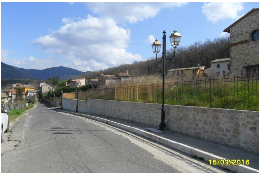
opere urbanizzazione lottizzazione (dalla via San Rocco)
