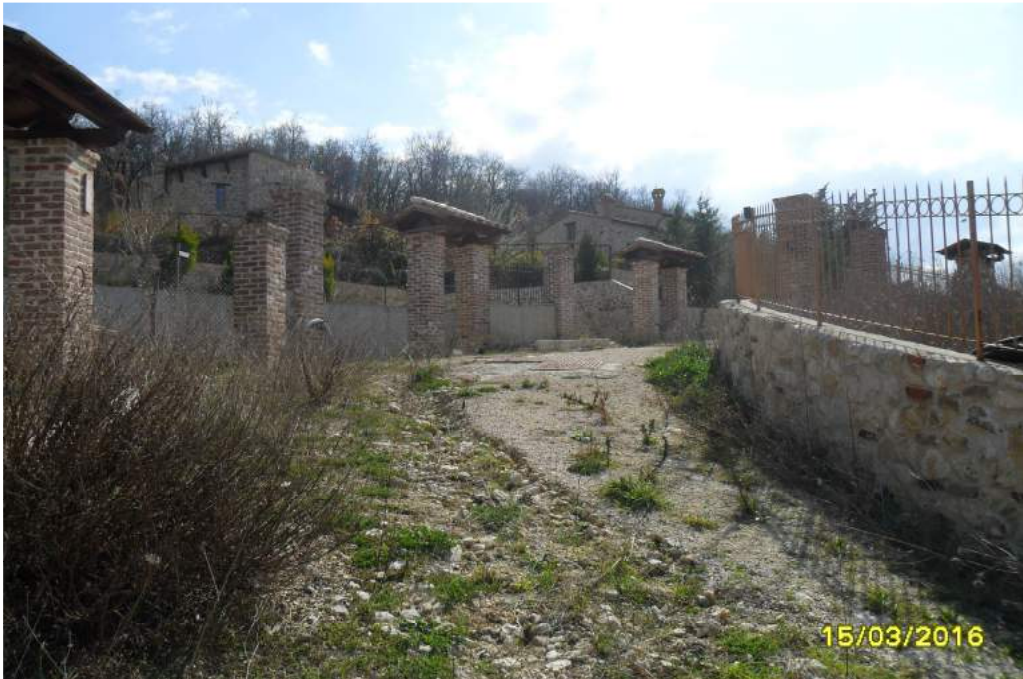
opere urbanizzazione lottizzazione (viabilità interna da cedere al Comune)
