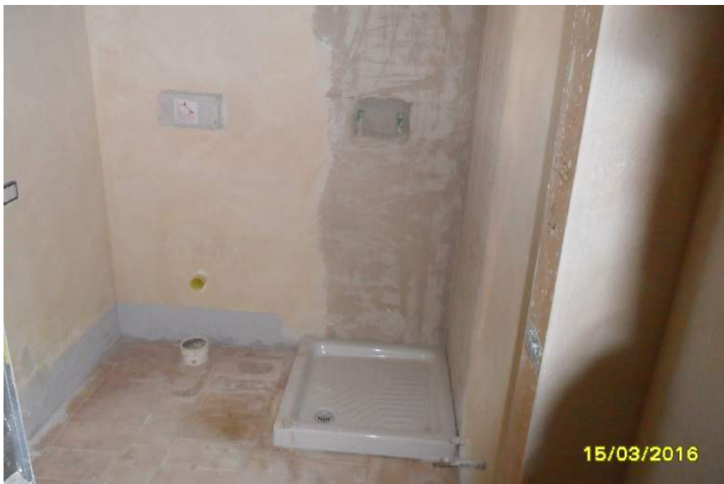
CORPO E - interno fabbricato
