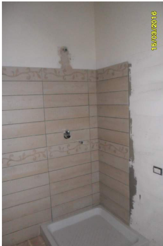
CORPO F - interno fabbricato
