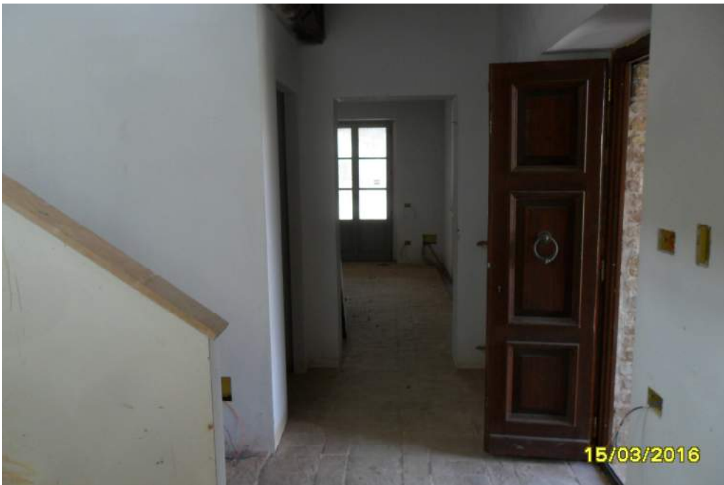
CORPO A - interno fabbricato
