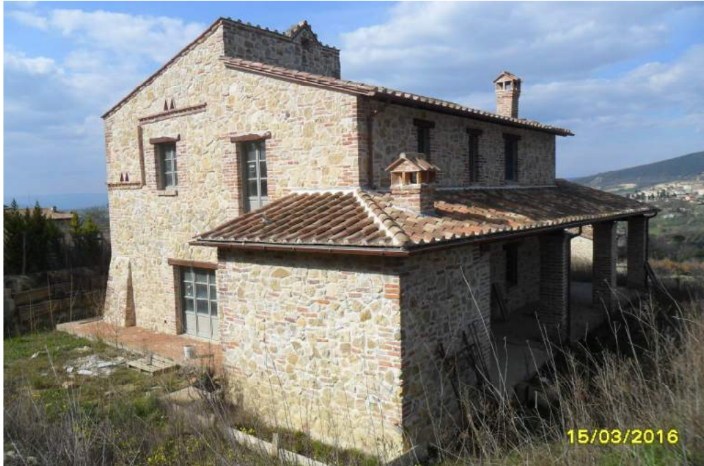
CORPO F - esterno fabbricato
