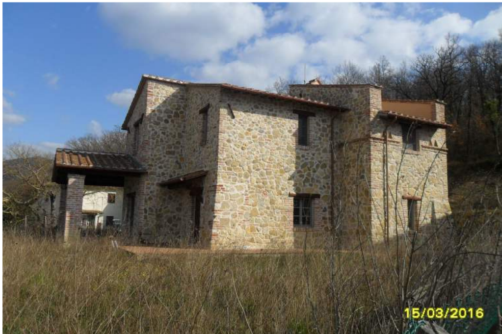
CORPO F - esterno fabbricato
