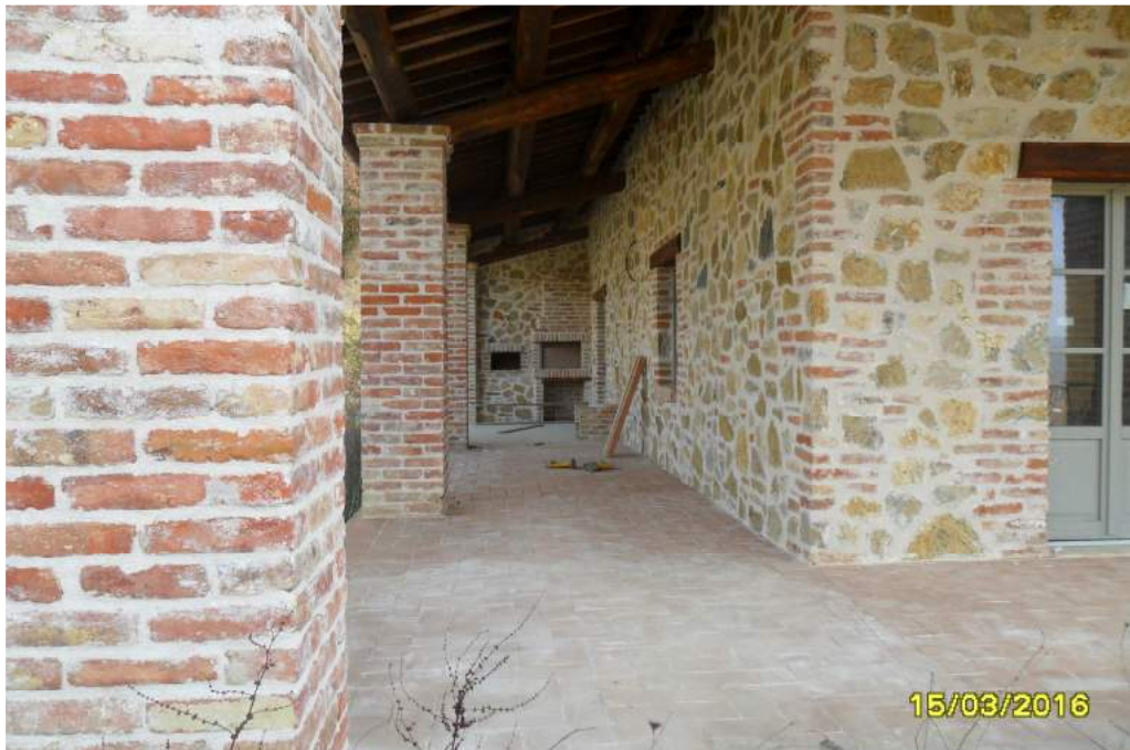
CORPO F - esterno fabbricato
