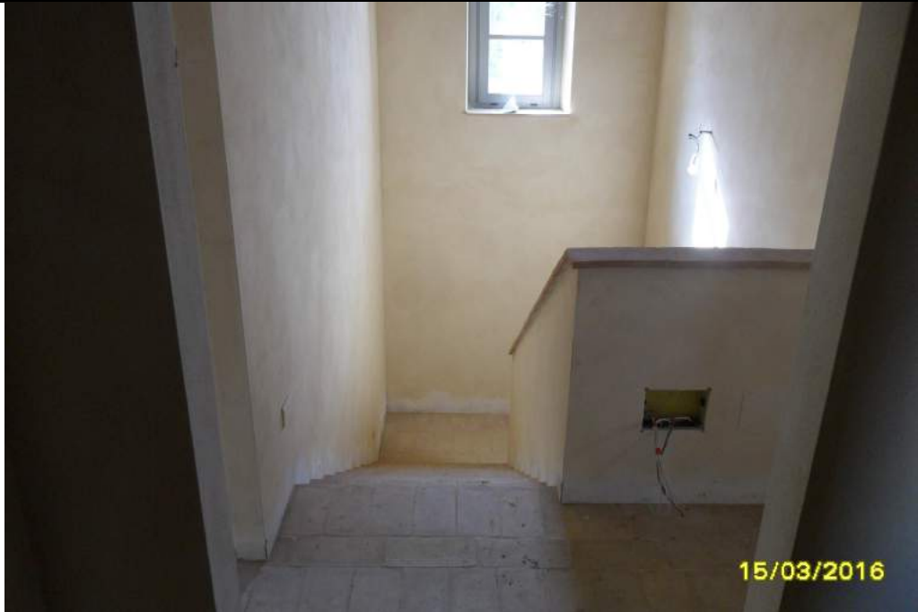
CORPO E - interno fabbricato
