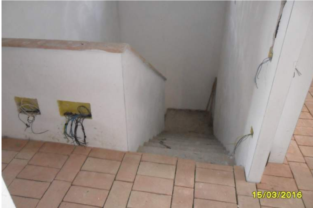
CORPO B - interno fabbricato
