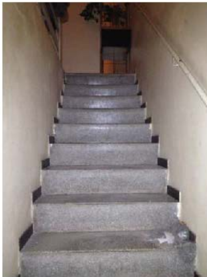
Accesso al primo piano, tramite scala interna, dalla cucina
