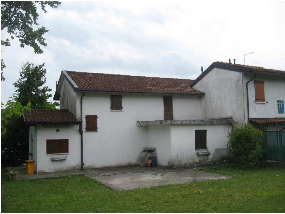
Vista retro lato nord
