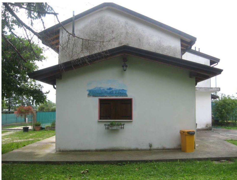
Vista laterale est
