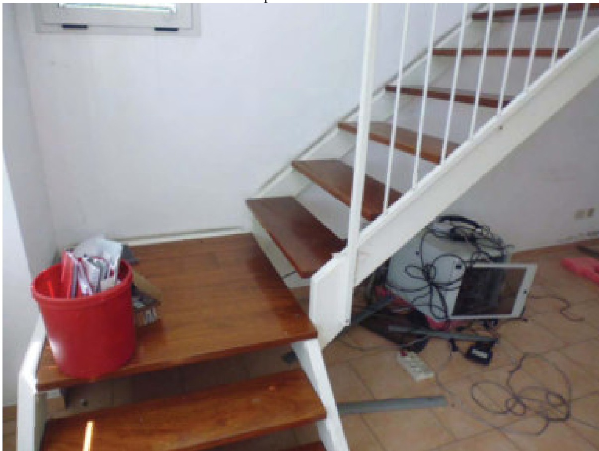
Foto 38 – particolare scala uffici
