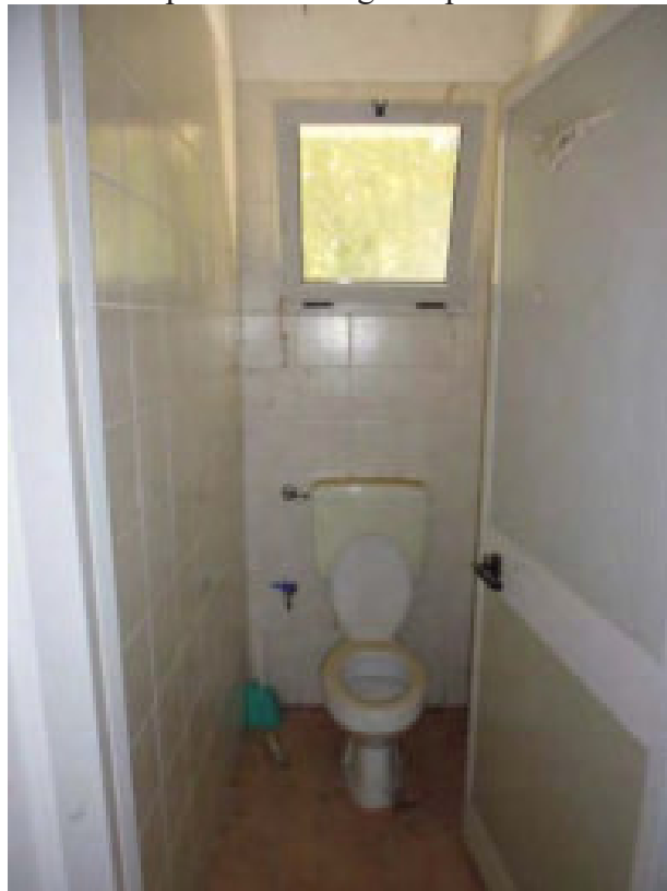
Foto 35 – particolare bagno dipendenti/donne
