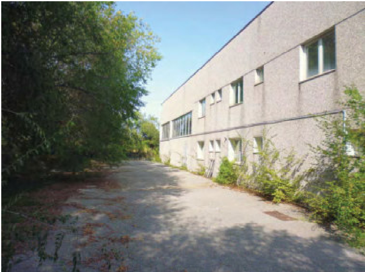
Foto 4 – vista lato nord
