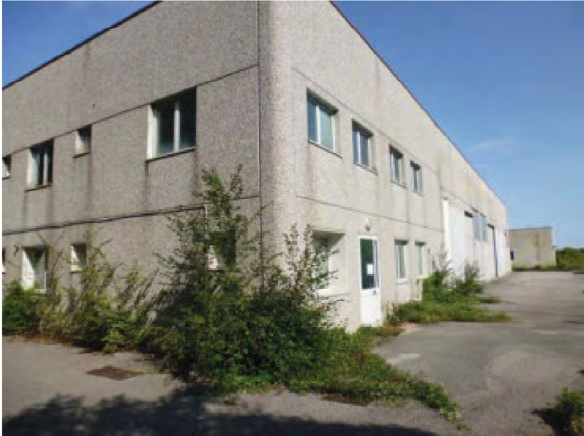
Foto 3 – vista lato ovest
