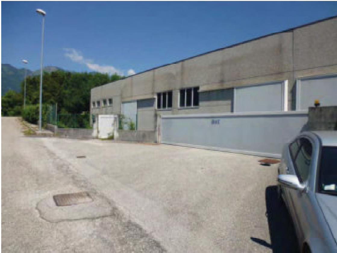
Foto 1 – vista accesso al fabbricato
