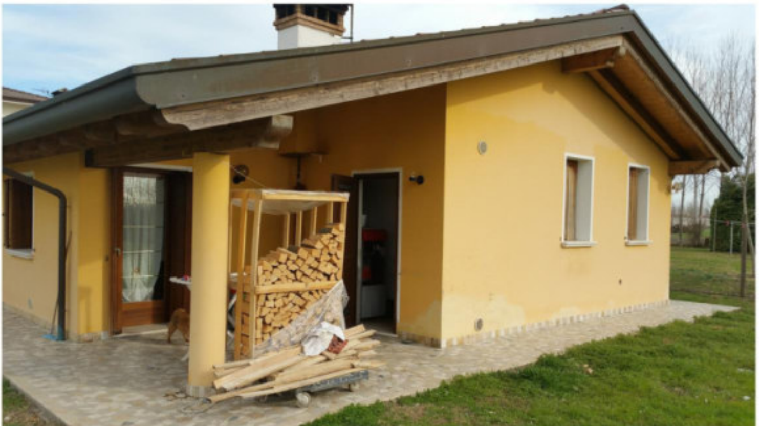
18 - lato sud particolare portico
