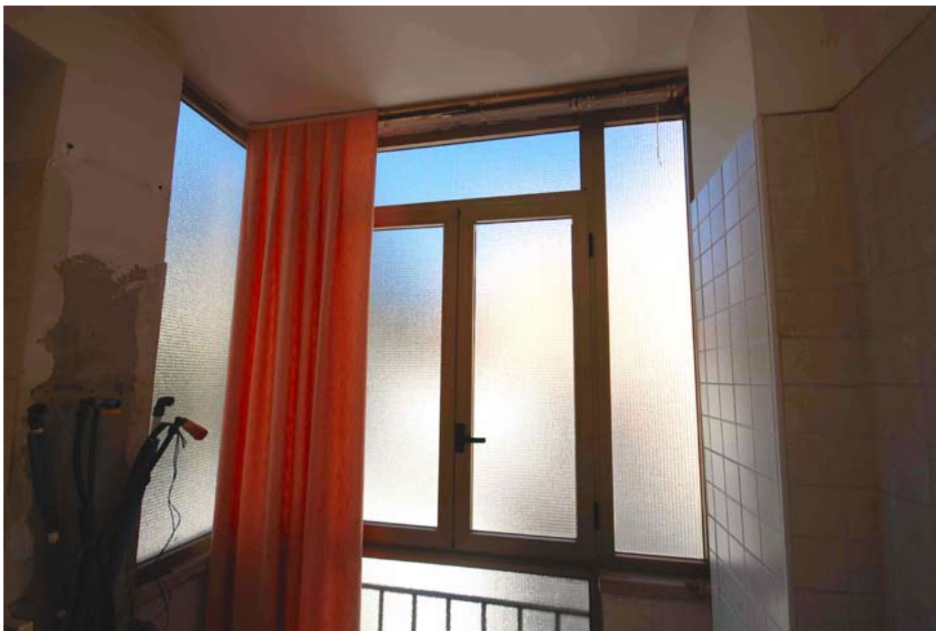
Foto 14_ Interno_Ambito veranda con infissi in alluminio
