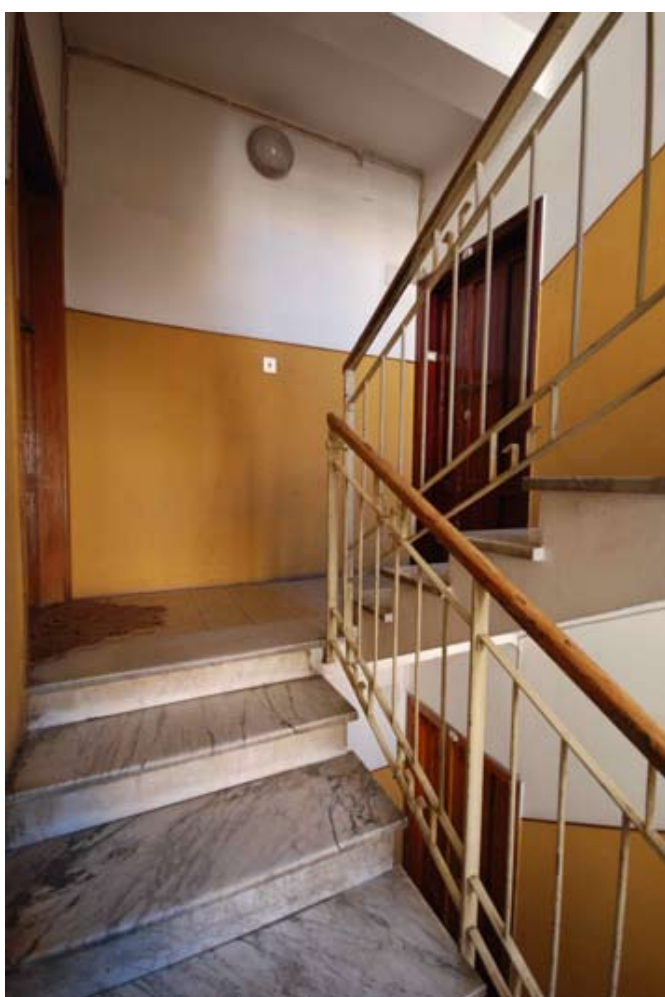
Foto 08_ Vista della scala condominiale
