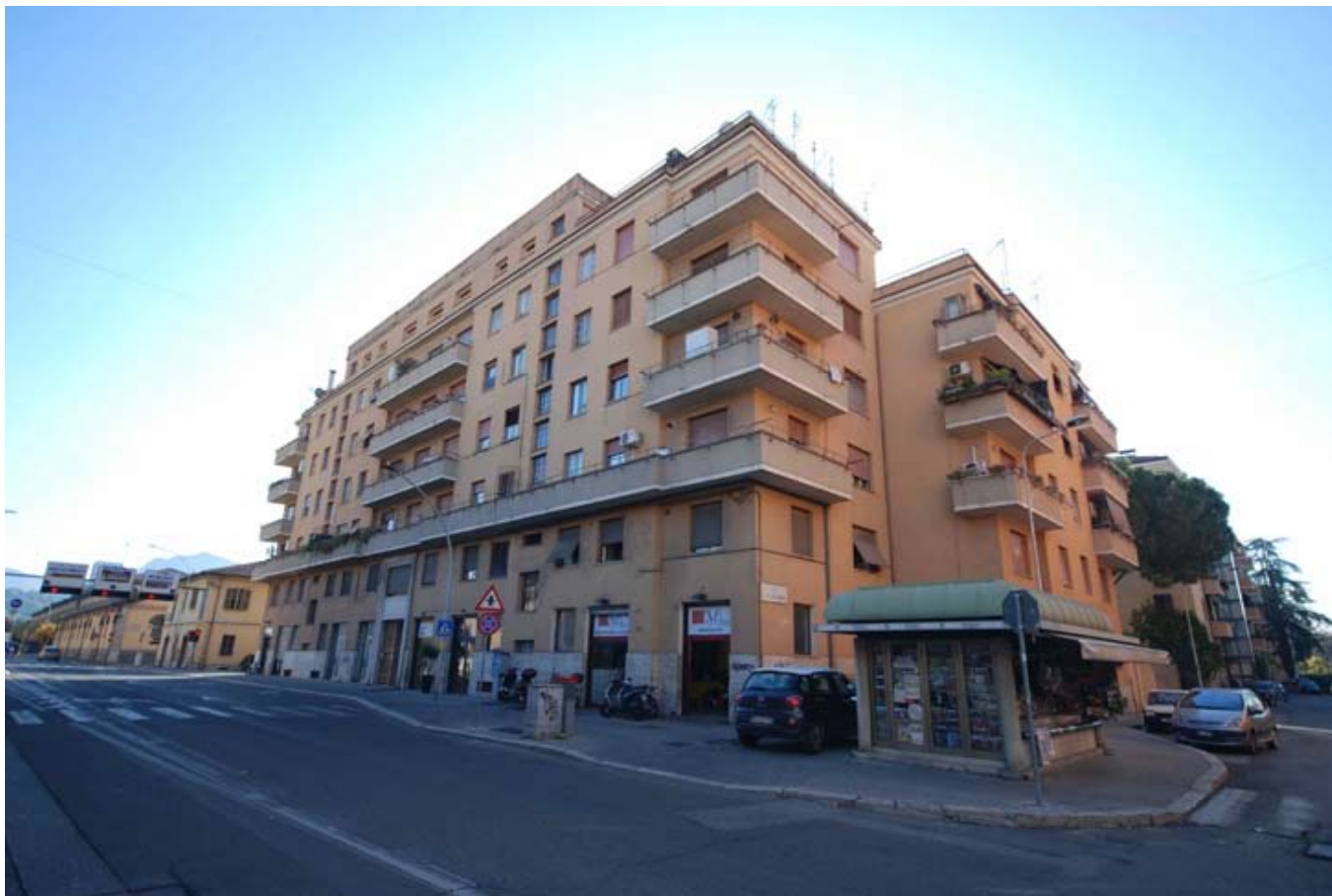
Foto 01_ Complesso condominiale visto da Viale Brin
