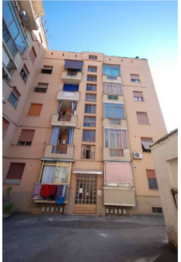
Foto 05_ Palazzina denominata "SCALA D"
