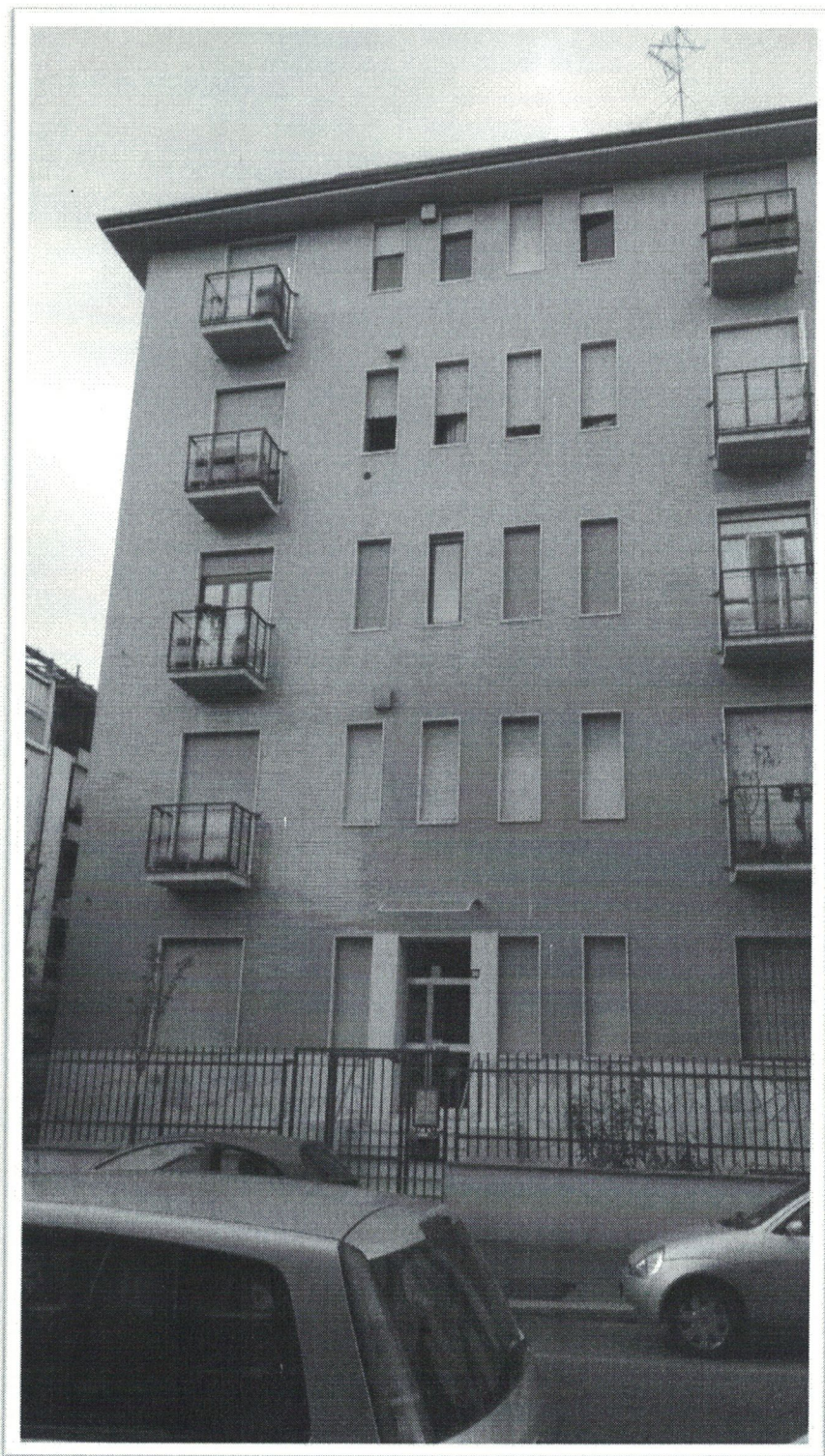
Vista del fabbricato
