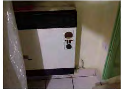
Particolare salotto foto 14
