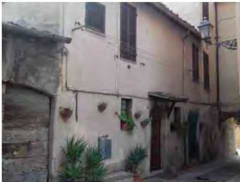
Facciata esterna su Via San Nicandro
