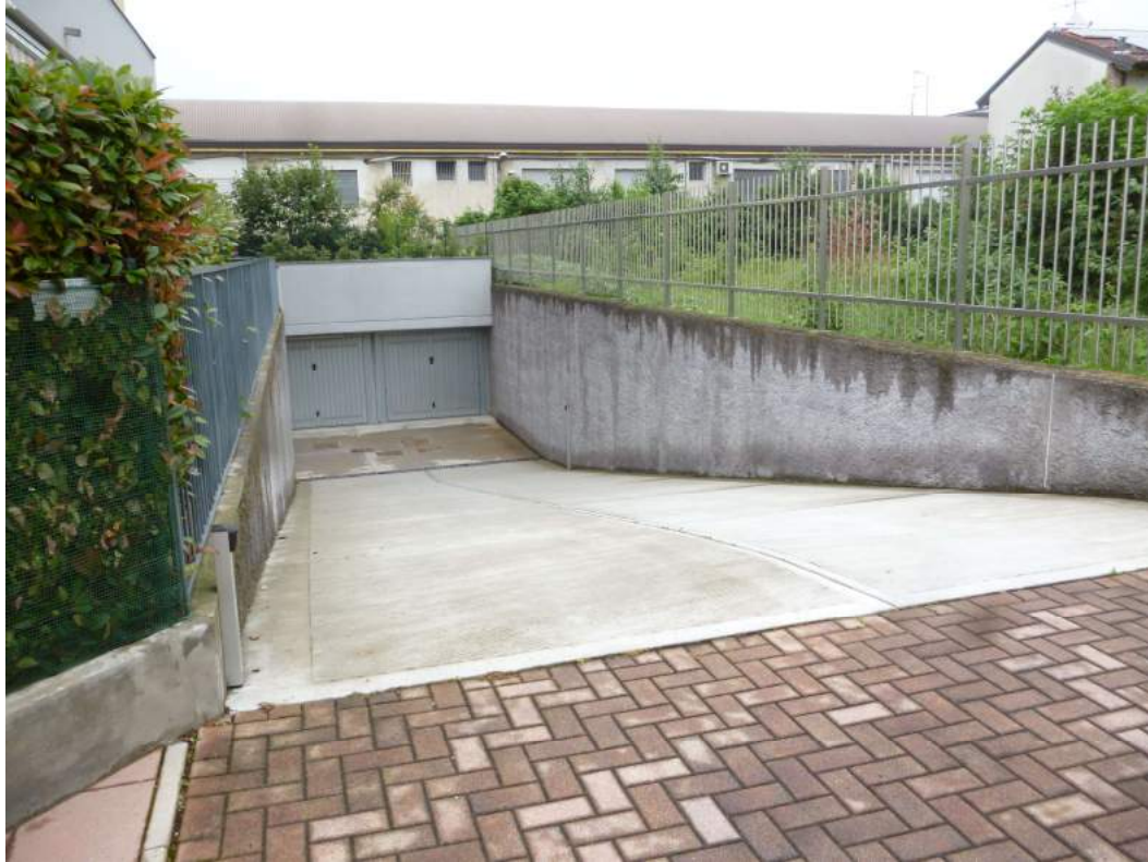
FOTO 3 – Rampa di ingresso ai box
