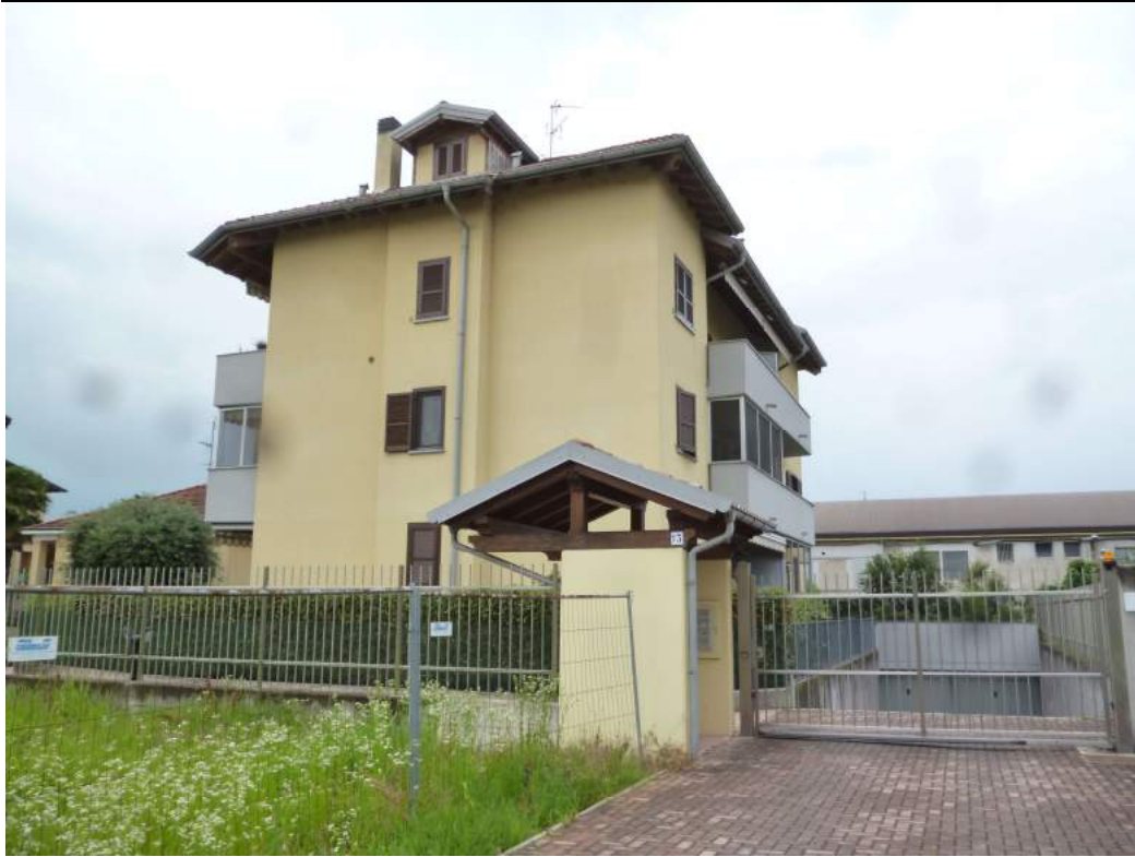
FOTO 1 – Ingresso carraio e pedonale da Via L. Manara n° 13 in RHO - Lucernate
