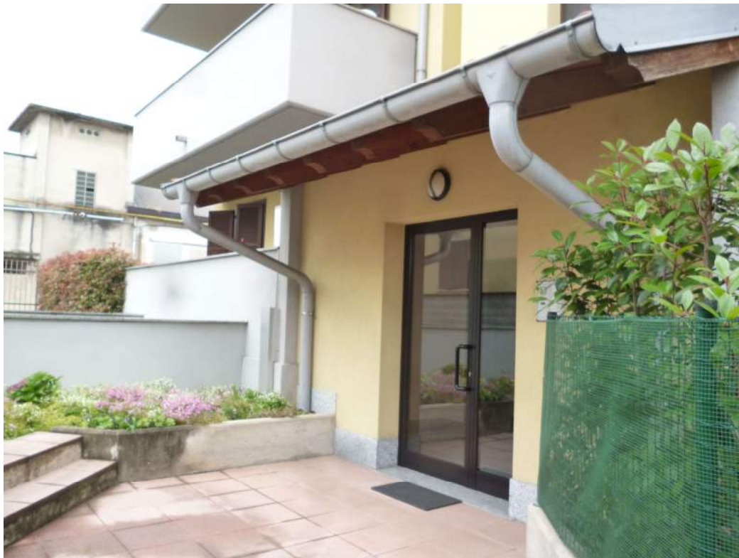
FOTO 2 – Ingresso all' edificio dal vialetto condominiale
