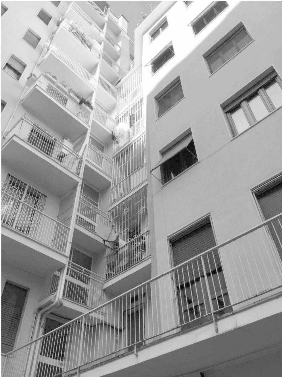
Fotografia n. 3 – Vista della facciata sul cortile interno dei box (retro del Condominio Via Marghera n. 45 – Milano), su cui affaccia parte dell'appartamento oggetto della procedura al piano primo (sul retro, piano terzo fuori terra)
