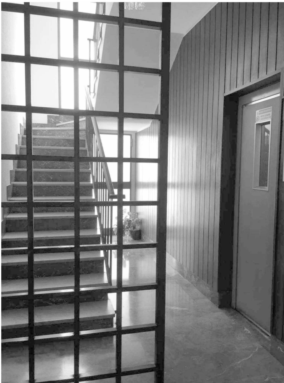
Fotografia n. 13 – Particolare del corpo scale, con ascensore, che conduce all'appartamento oggetto della procedura al piano primo
