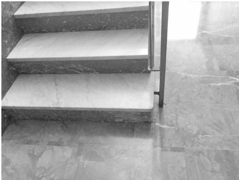
Fotografia n. 15 – Particolare della rampa delle scale
