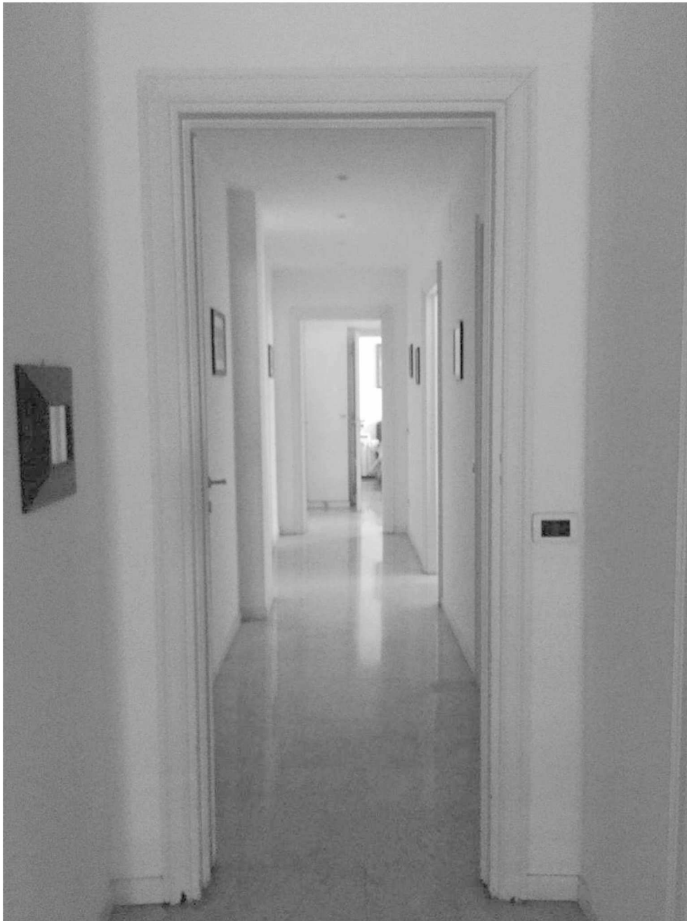
Fotografia n. 33 – Vista del disimpegno, ribassato ad altezza di 2,56 ml. c.ca, che conduce alla zona notte
