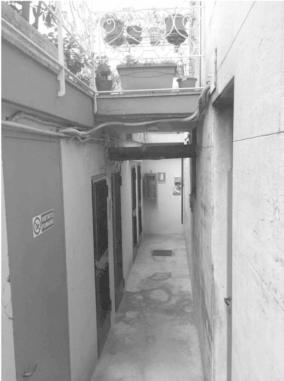
Fotografia n. 47 – Vista del percorso di accesso scoperto alle cantine (piano seminterrato)
