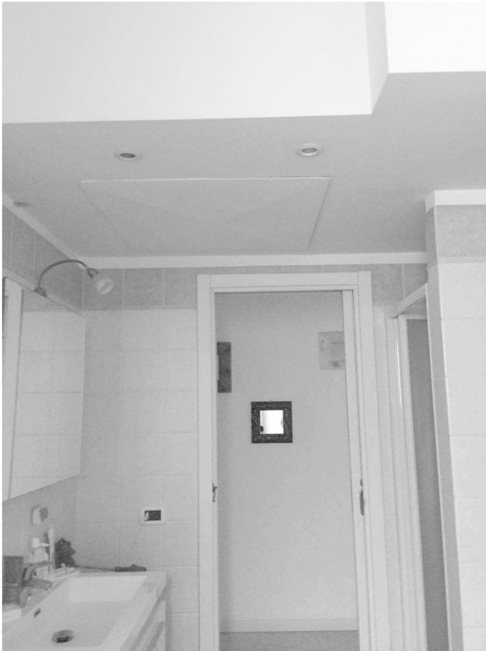
Fotografia n. 28 – Vista dell'ingresso del primo locale bagno con doccia e del ribassamento (altezza di 2,28 ml. c.ca) localizzato solo nella prima parte del locale
