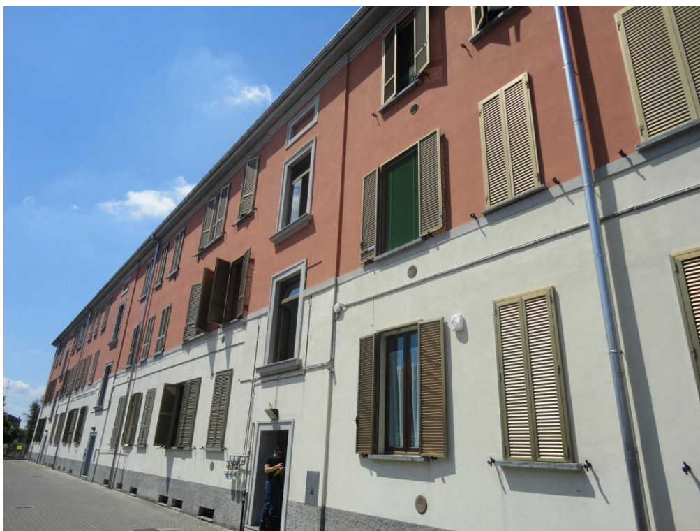
Foto n. 1 e n. 2: Foto esterne del fabbricato
