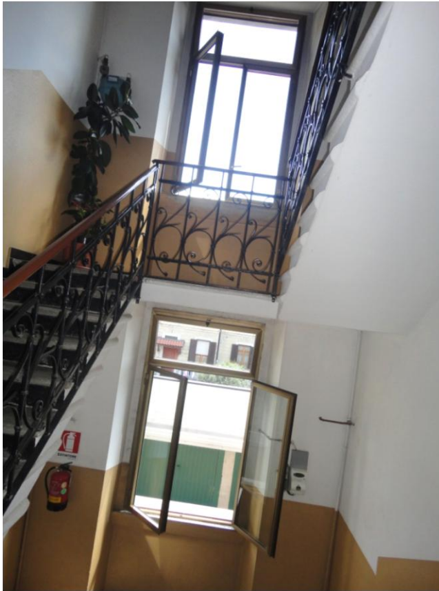
Foto n.3 e n.4: Vista del corpo scale e della porta di ingresso
