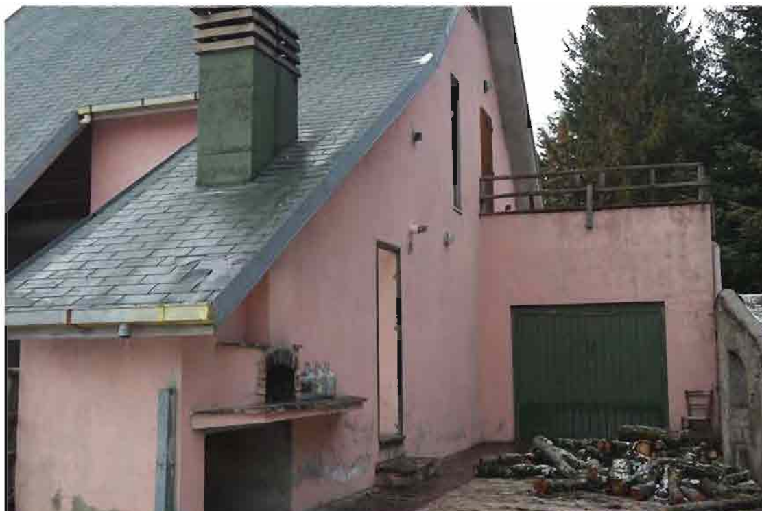
25-Vista esterna locale sgombero
