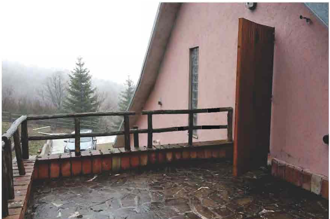
16-Vista esterna – Terrazzo scoperto accessibile dal primo piano
