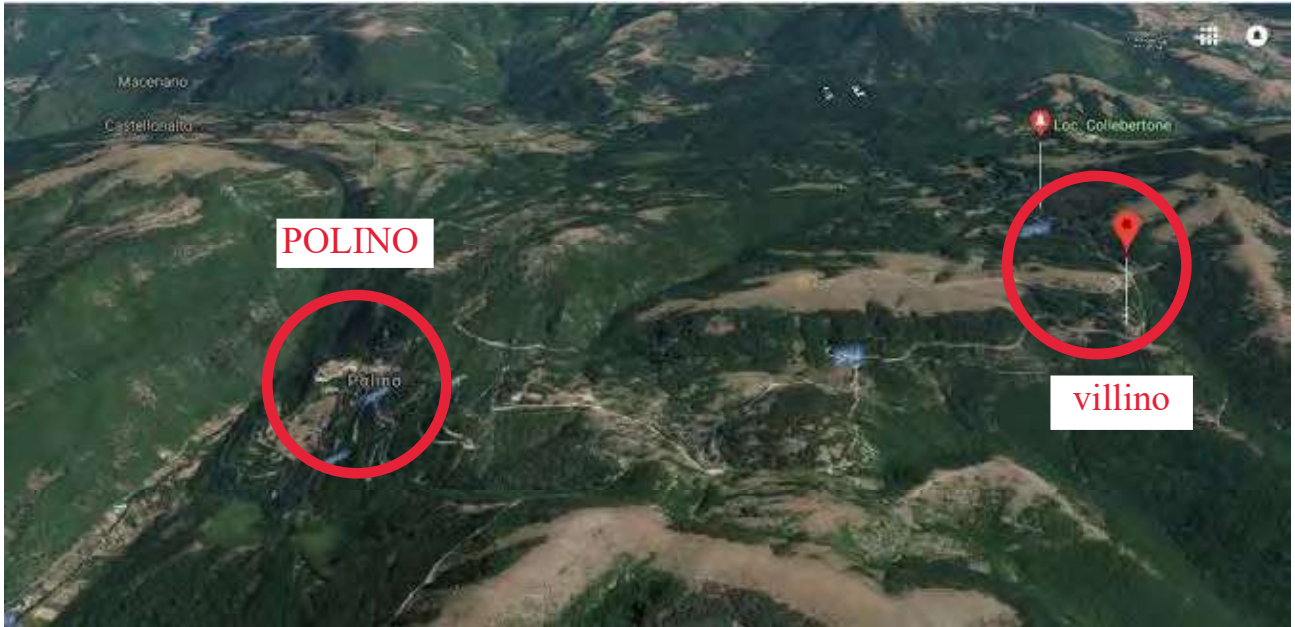
03-Vista aerea dell'area ed inquadramento rispetto al comune di Polino
