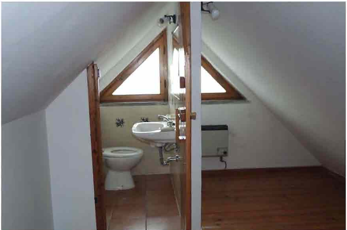
24- Vista interna – Locale sottotetto con bagno
