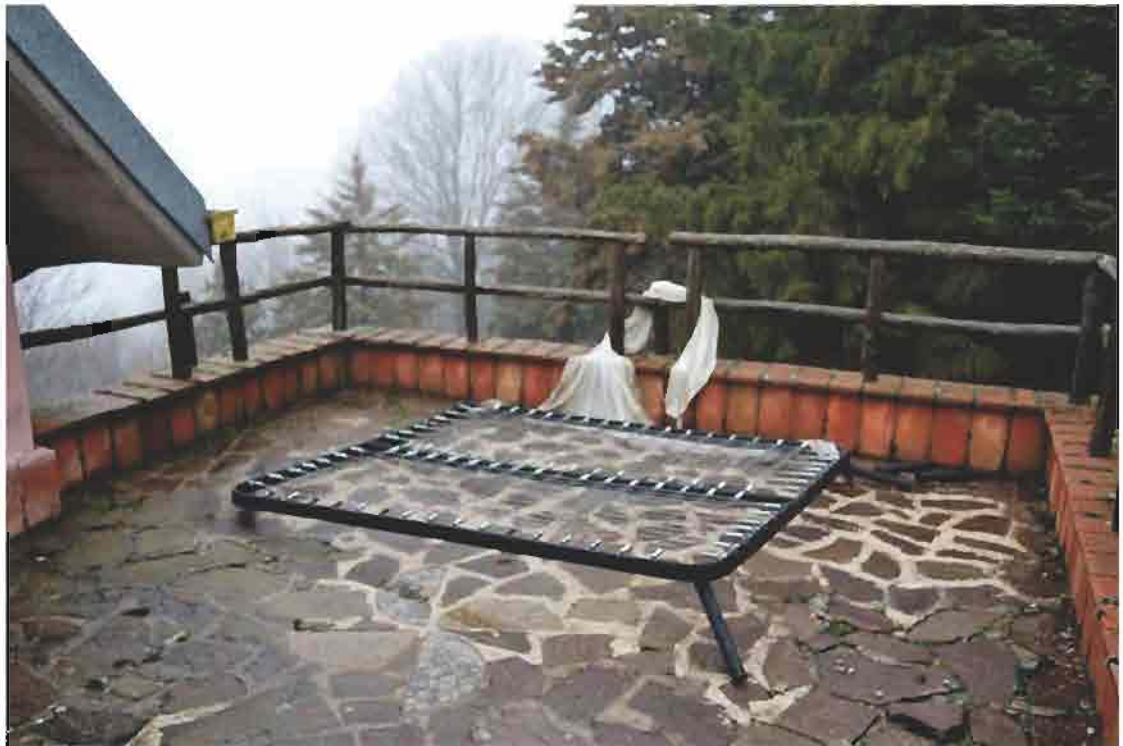
15-Vista esterna – Terrazzo scoperto accessibile dal primo piano
