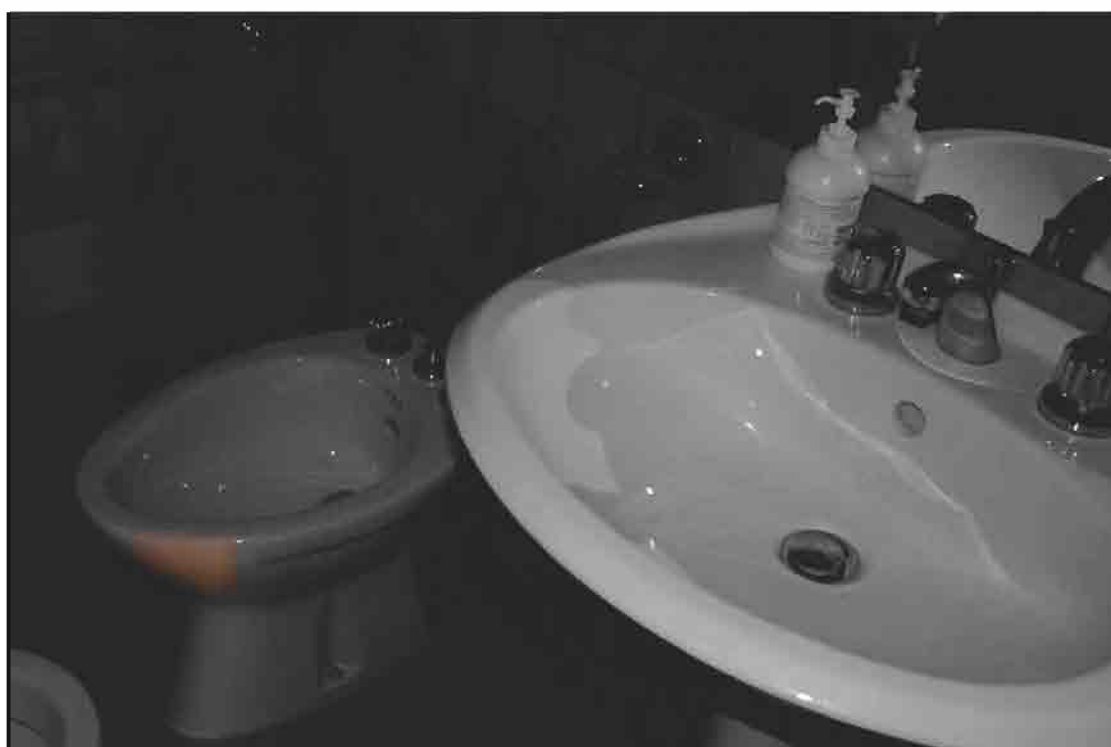
22- Vista interna – Bagno al primo piano
