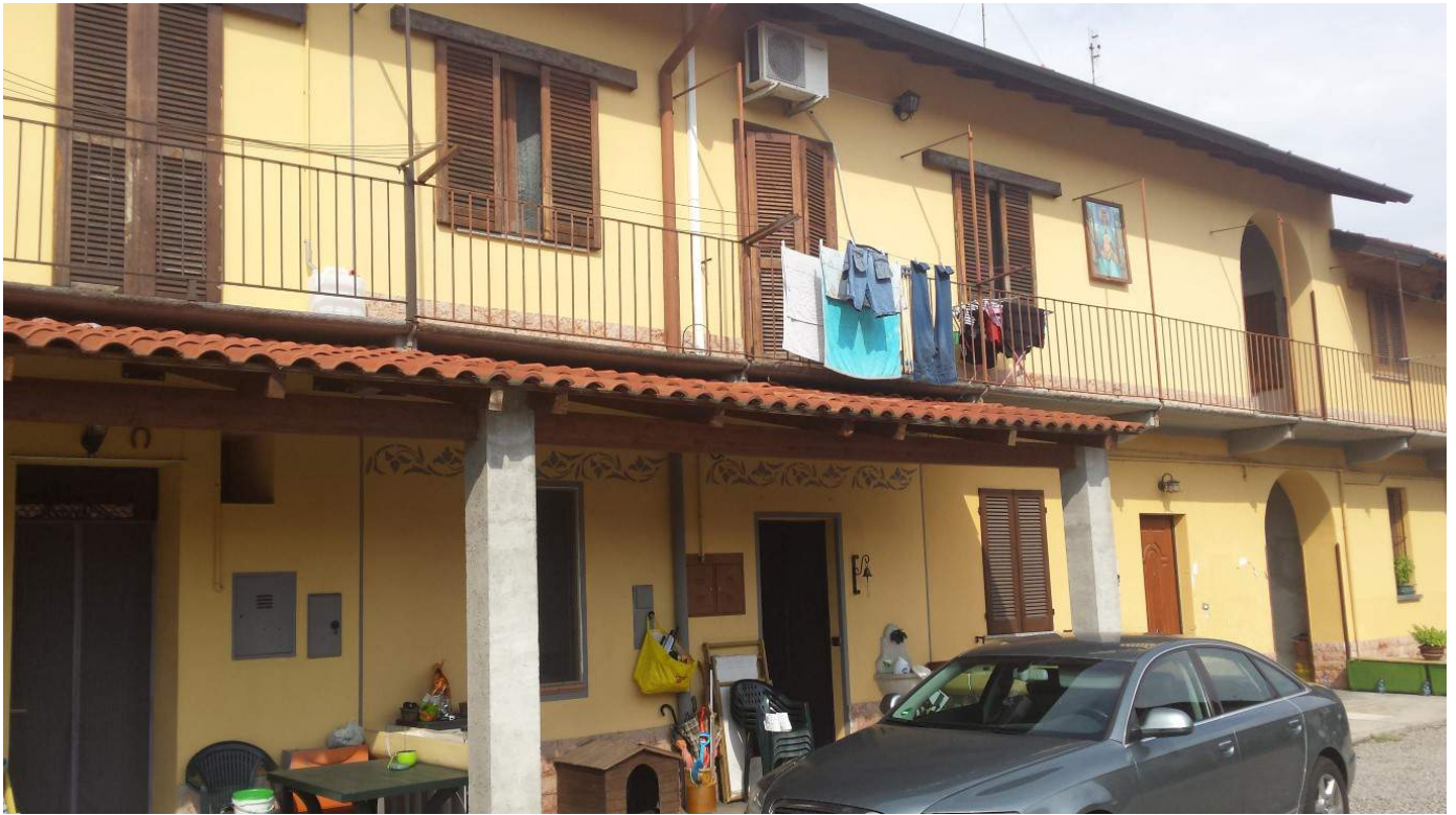
Foto n. 1 – prospetto su corte interna
