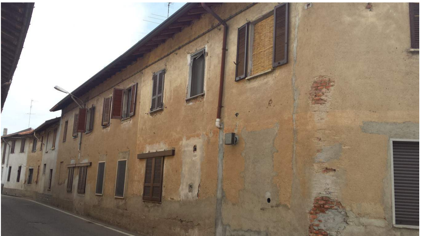
Foto n. 2 – prospetto su via San Francesco
