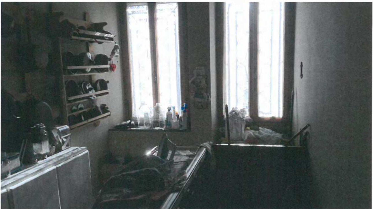
Foto n.14 - Disimpegno di collegamento tra piano primo e terra
