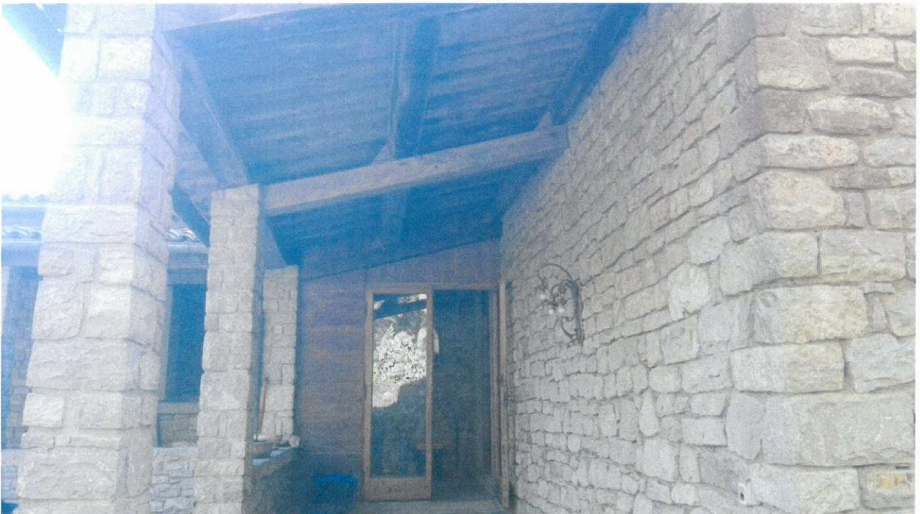
Foto n.4 - Prospetto Nord e portico comune
